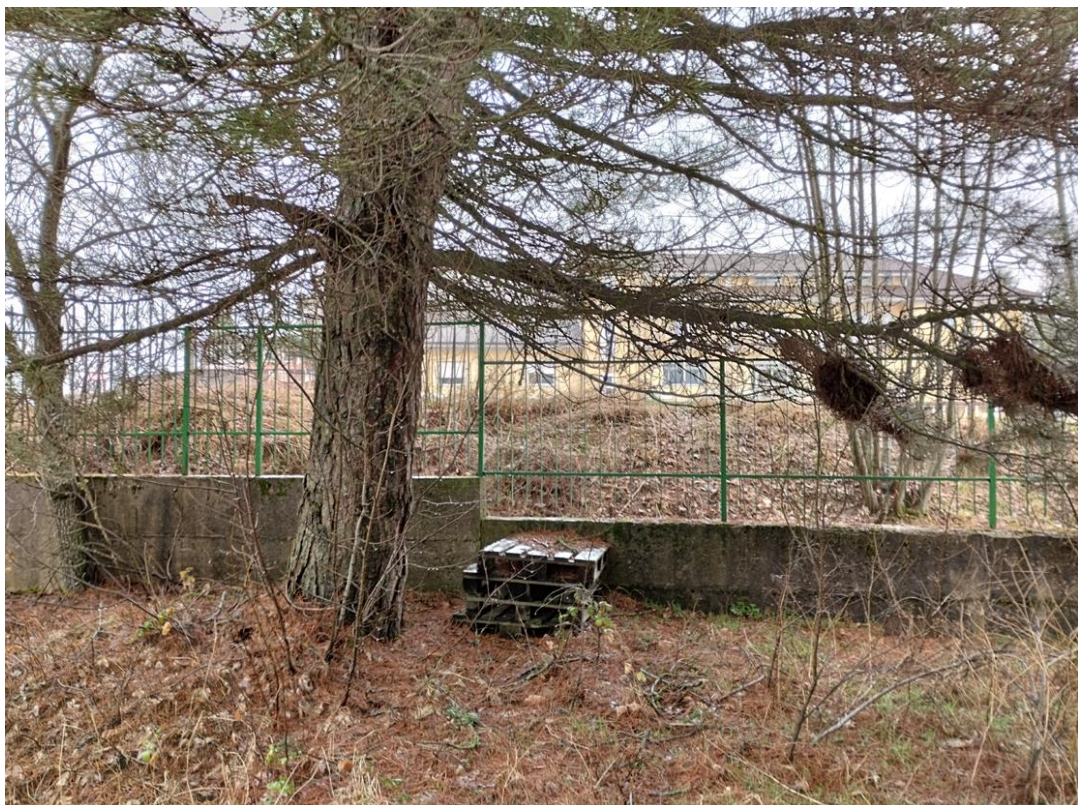
Foto 12 – Muro di recinzione in c.a. sormontato da recinzione metallica
