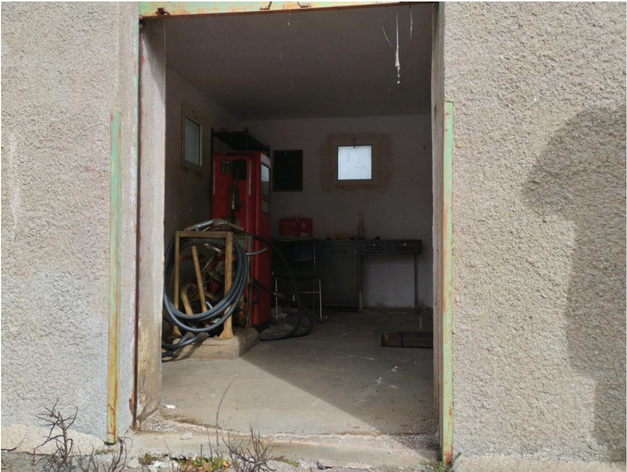
Foto 6 – Fabbricato di vecchio impianto: vista interni
