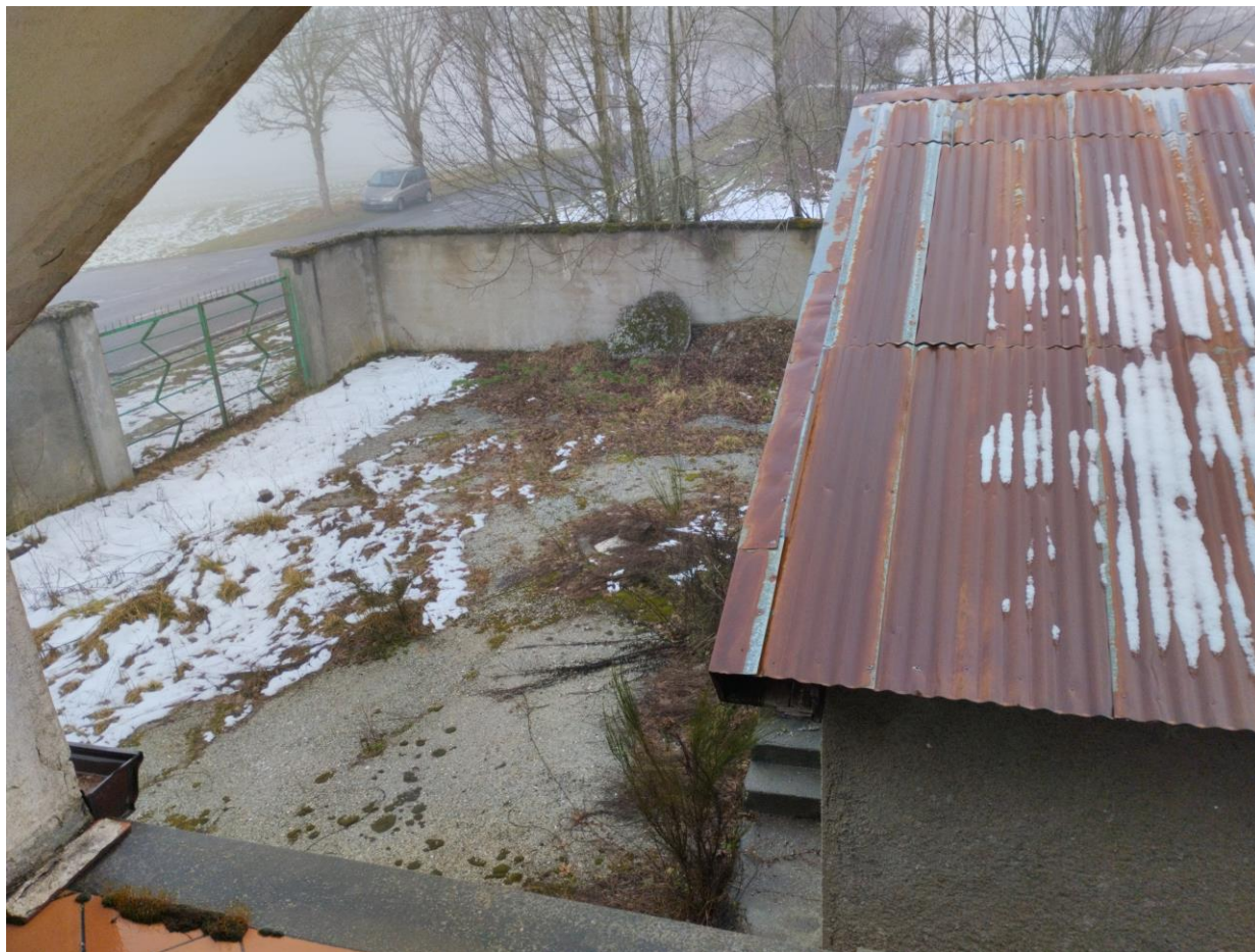
Foto 3 – Fabbricato di vecchio impianto: copertura in lamiera
