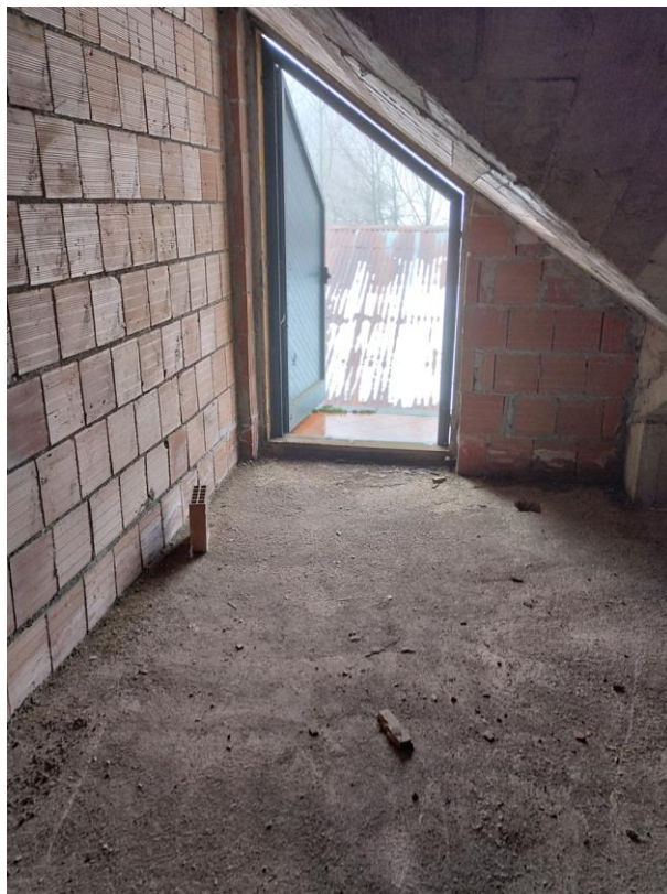
Foto 10 – Fabbricato più recente: scorcio interni piano sottotetto
