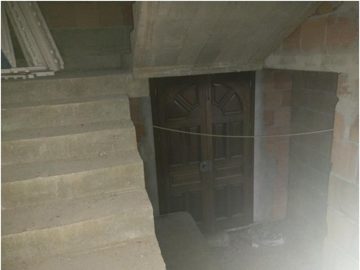
Foto 9 – Fabbricato più recente: scala di collegamento con il piano sottotetto
