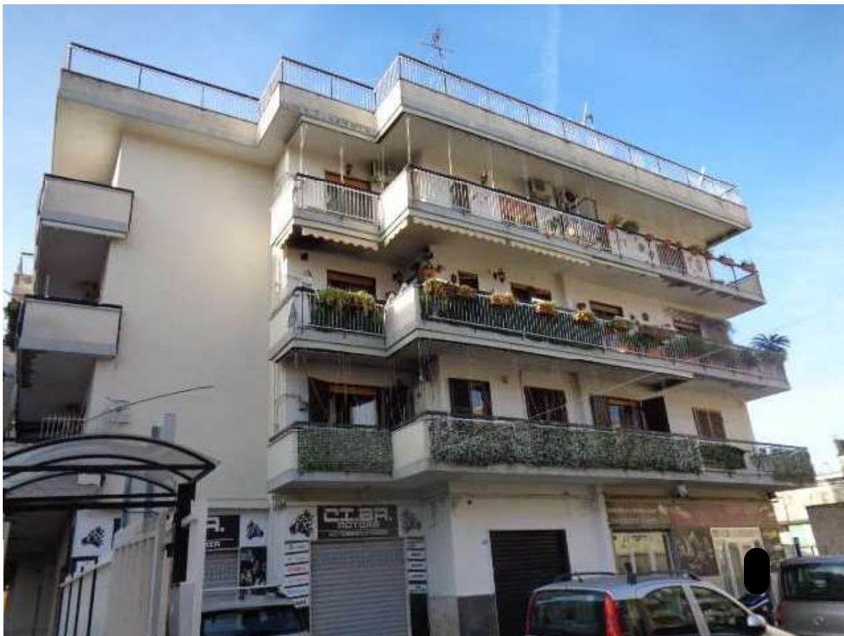
Foto n. 5: Facciata principale del fabbricato d'interesse.
