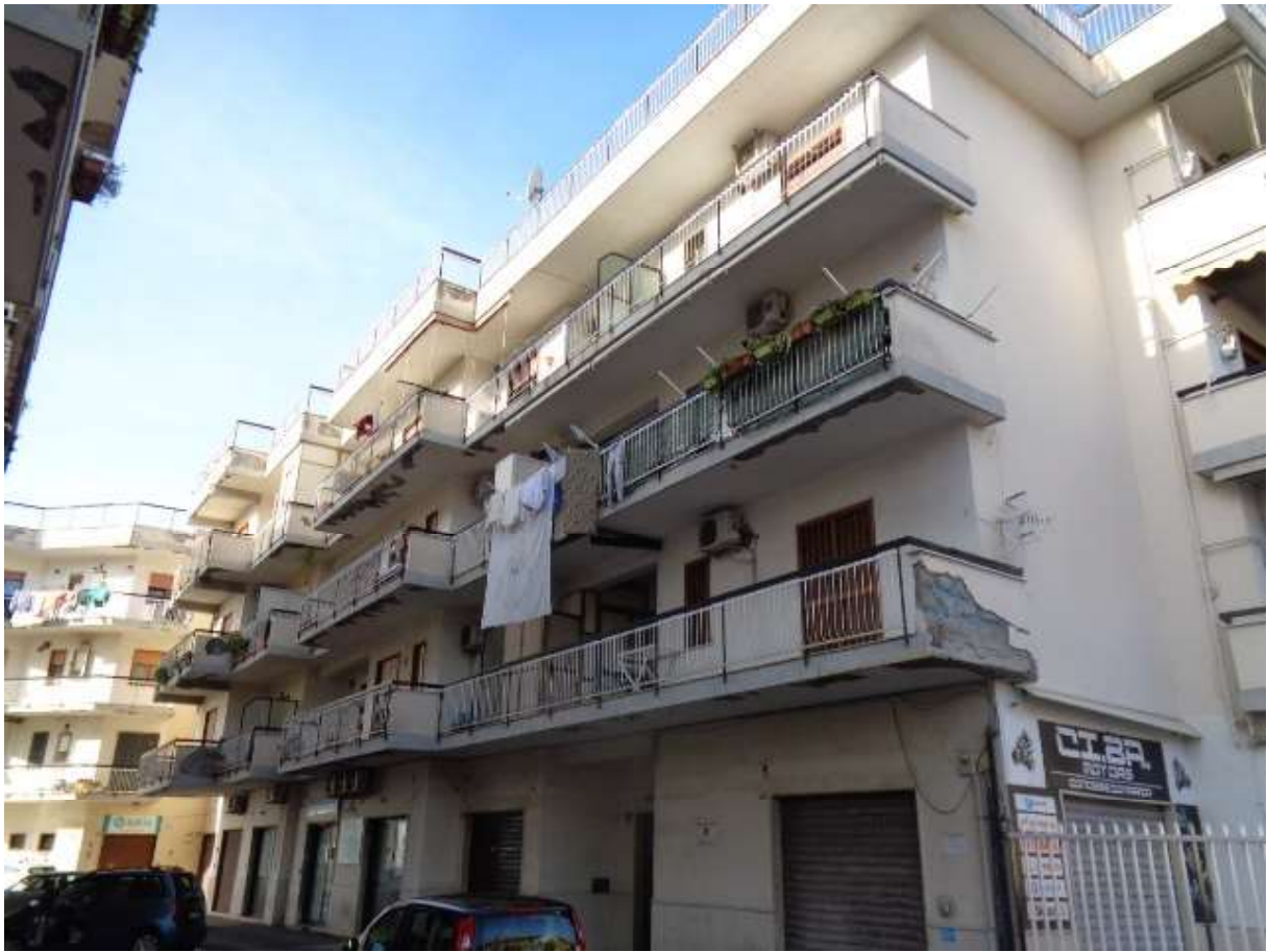
Foto n. 7: • Facciata del fabbricato d'interesse dal lato del viale interno.
