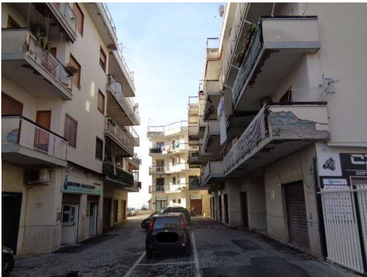
Foto n. 6: • Viale interno del complesso.
