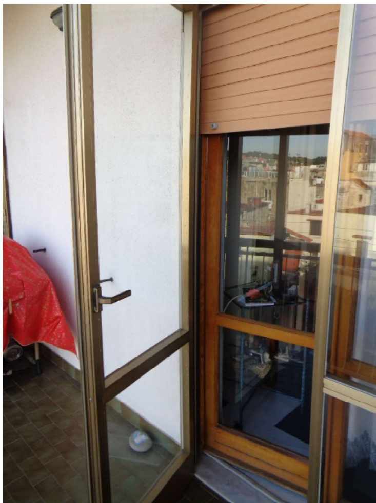
Foto n. 34: • Doppi infissi camere da letto lato destro corridoio.
