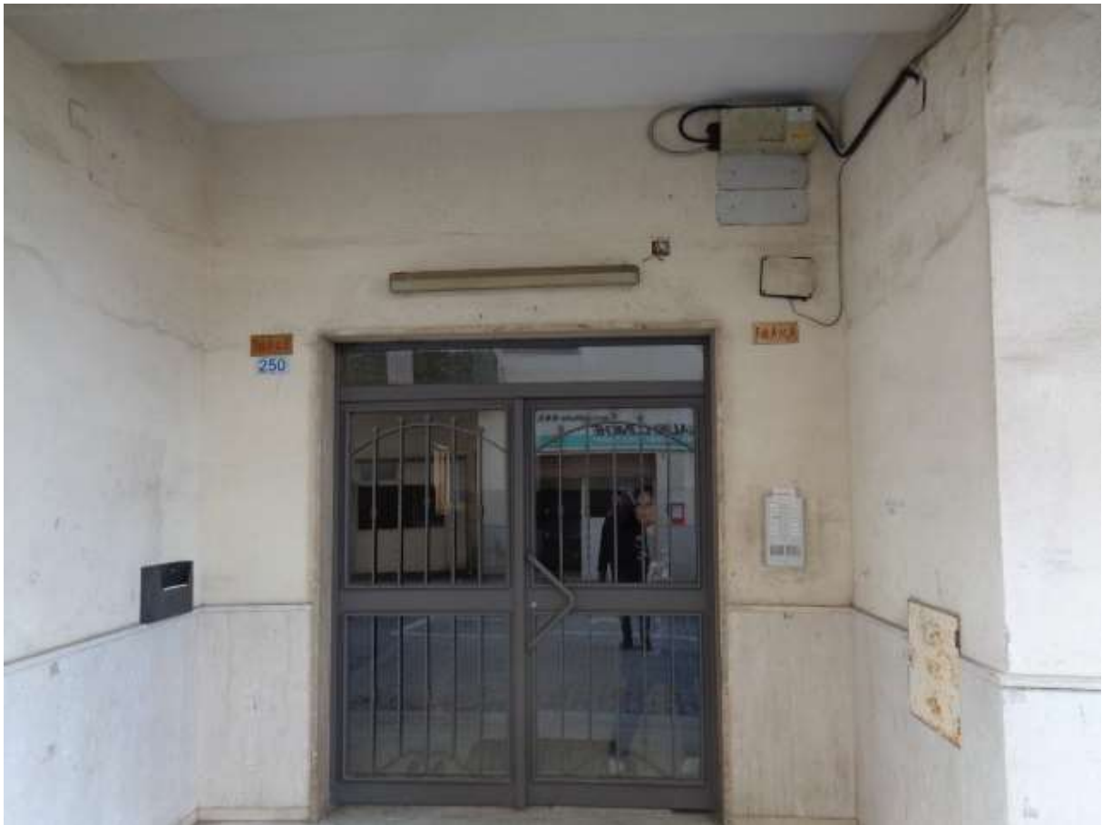
Foto n. 9: • Portone di accesso al fabbricato d'interesse dal viale interno.
