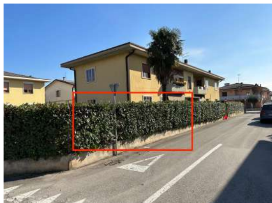
Vista dalla strada (angolo nord-ovest).
