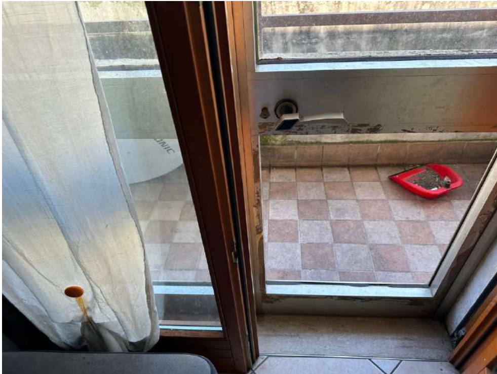
Dettaglio serramenti e poggiatesta.
