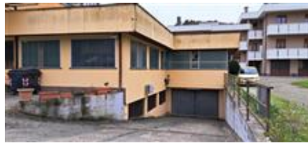
scivolo di accesso al piano interrato
