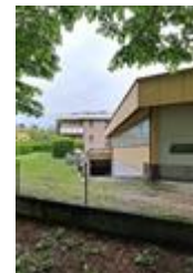
scivolo di accesso al piano interrato, sul retro lungo viale del Lazzaretto
