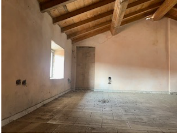
Foto interna – piano sottotetto
