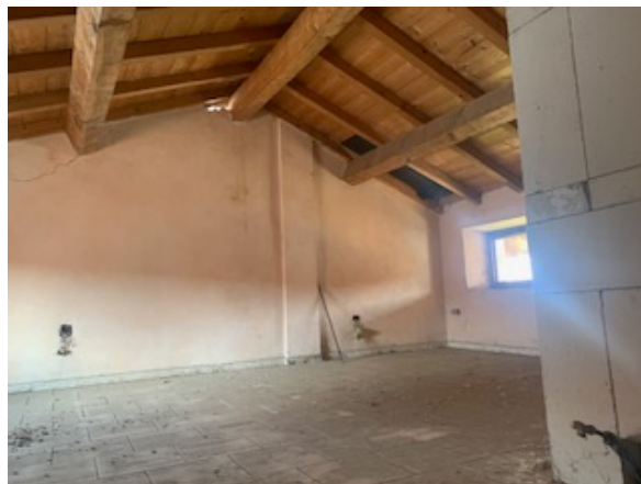
Foto interna – piano sottotetto
