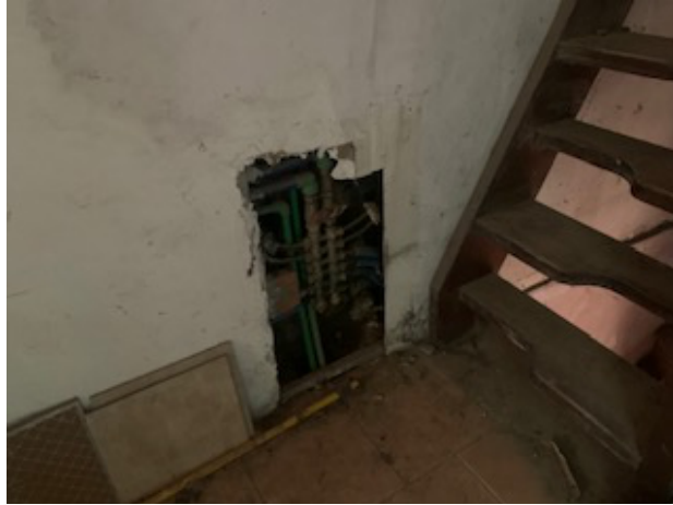
Foto interna – scala di collegamento dal piano primo al piano sottotetto
