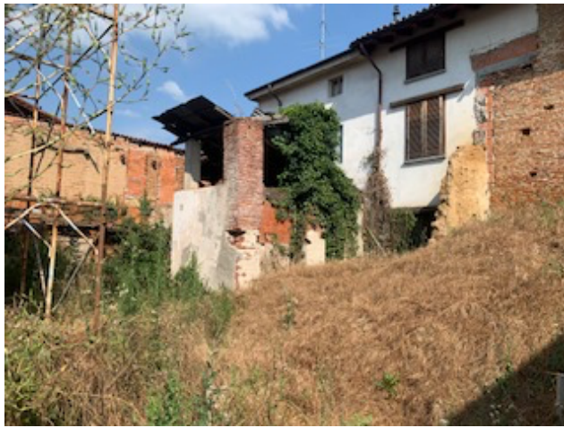
Foto esterna – locale corpo staccato posizionato nell'area esclusiva
