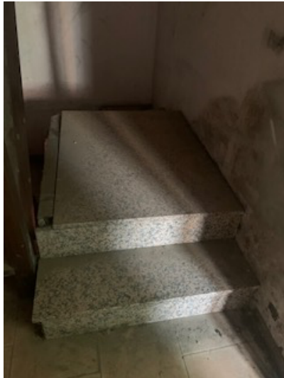
Foto interna – scala di collegamento dal piano terra al primo piano
