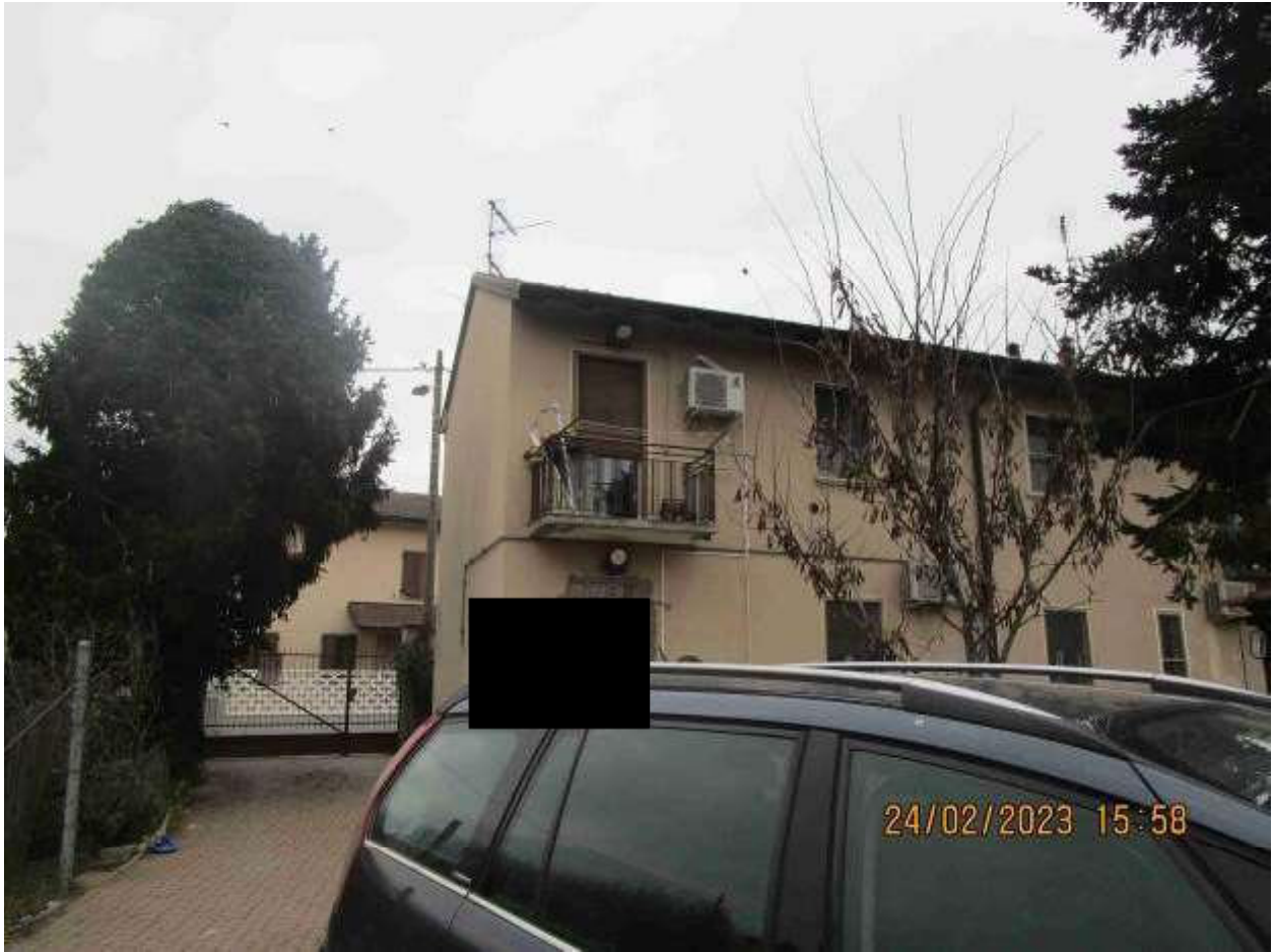
Prospetto su cortile
