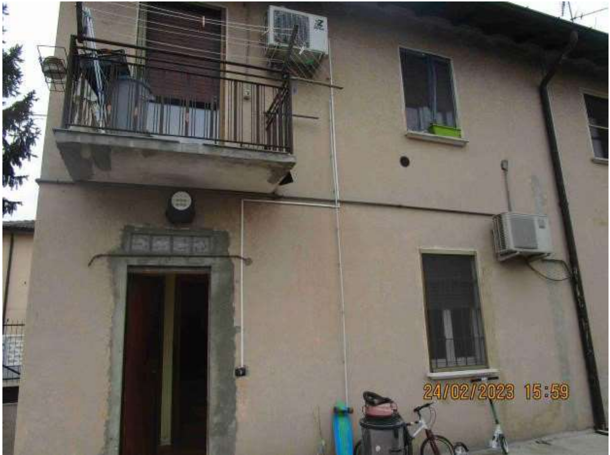
Prospetto su cortile
