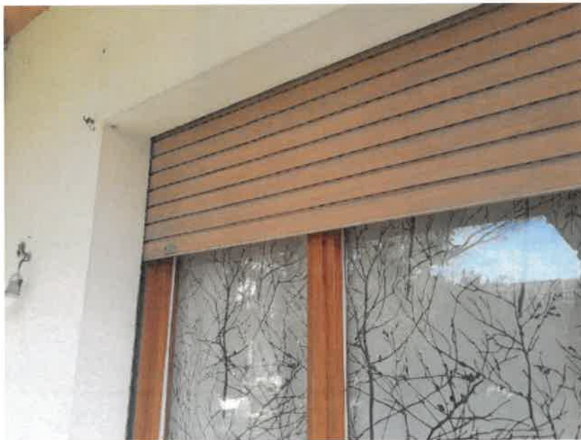
Foto n° 25 – particolare infisso e tapparella appartamento tipo
