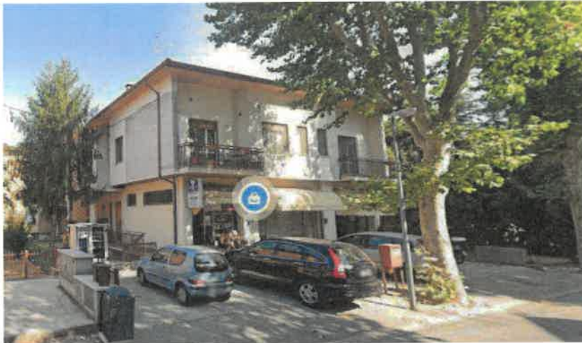
Foto n° 1 – vista d'insieme del fabbricato in Viale Italia
