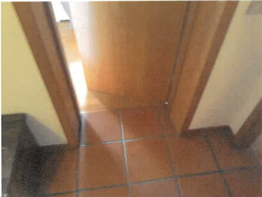
Foto n° 24 – – pavimento appartamento. sub 13
