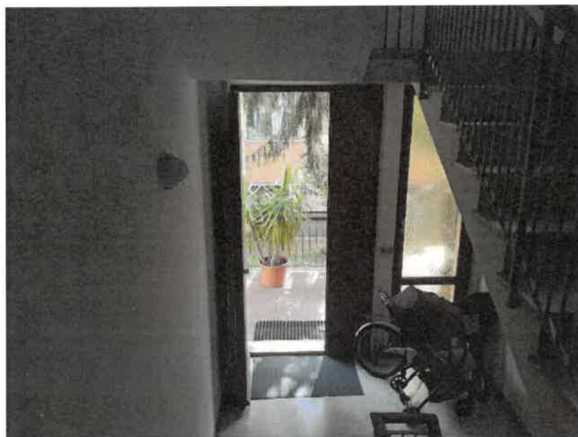
Foto n° 6 – ingresso condominiale scale di accesso alle u.i.
