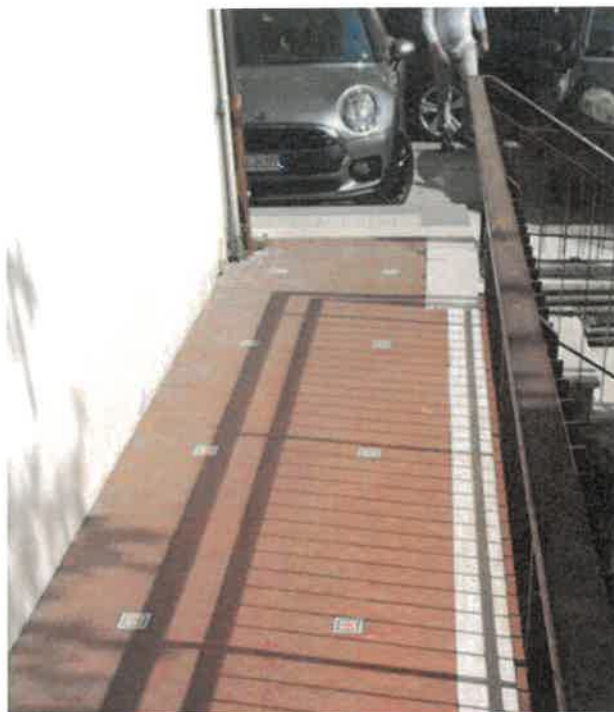
Foto n° 5 – pavimentazione ingresso e balcone tipo
