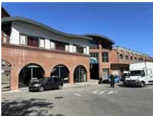
vista esterna del fabbricato con affaccio sulla via Lanino
