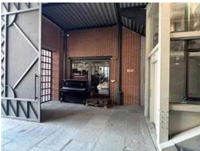
vista della vetrina dell'immobile oggetto di pignoramento con affaccio sull'atrio di ingresso
