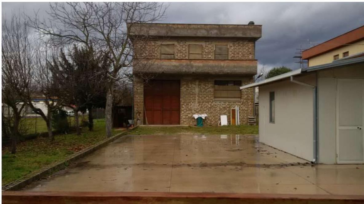
La struttura portante è in blocchi di tufo non intonacati con copertura piana.
