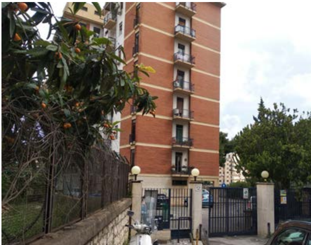
FOTO n.1 Ingresso dal civ 12 via Cimarosa
