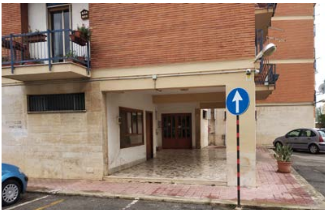
FOTO n. 2 - Ingresso alla palazzina "B"
