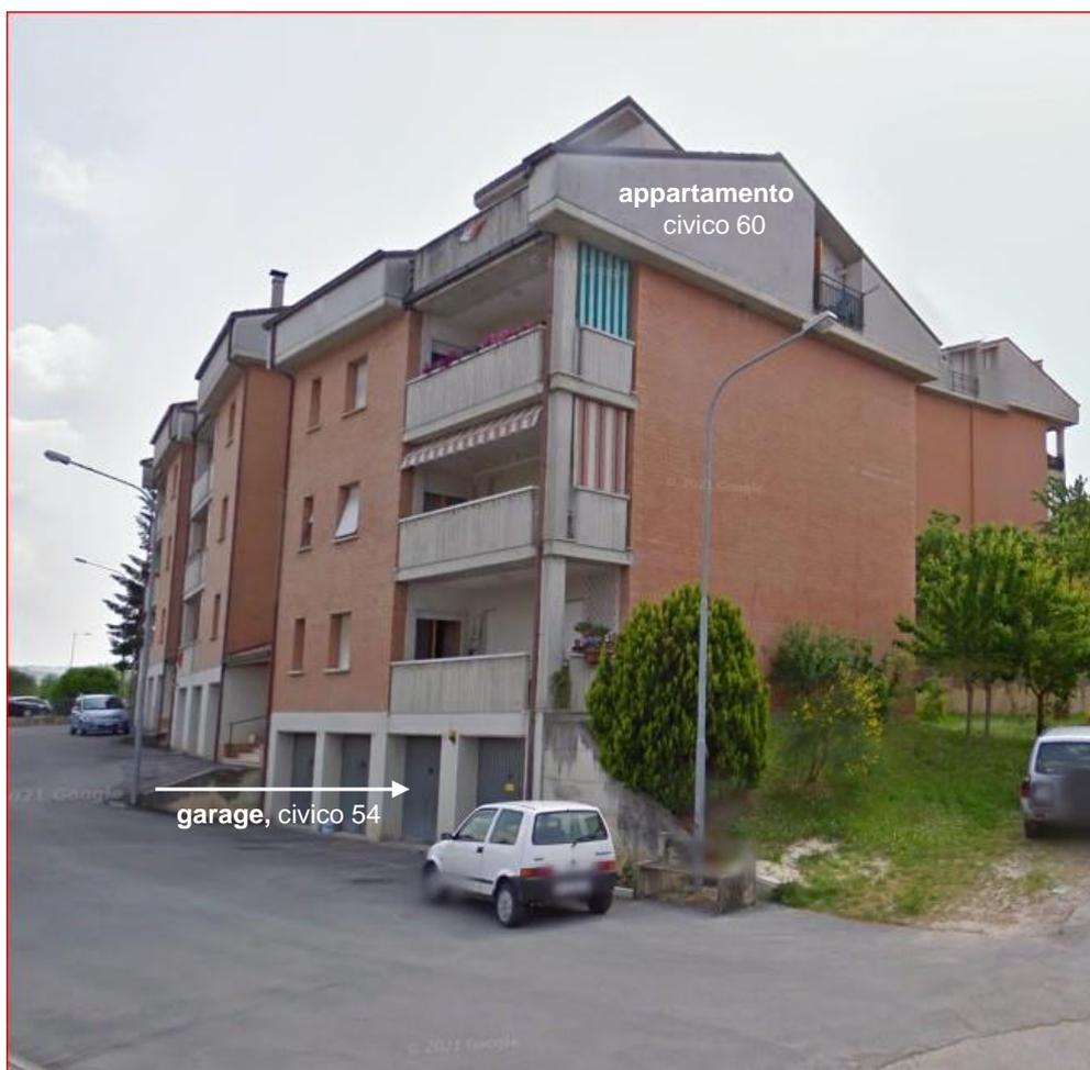
L'edificio ha una struttura con telaio in cemento armato su 4 livelli con solai in latero cemento, tamponature a doppio paramento ante legge 10/1991, ed è senza ascensore. Con riferimento alle parti esterne, l'edificio è in buono stato di conservazione e non risultano danni al recente terremoto 2016.
