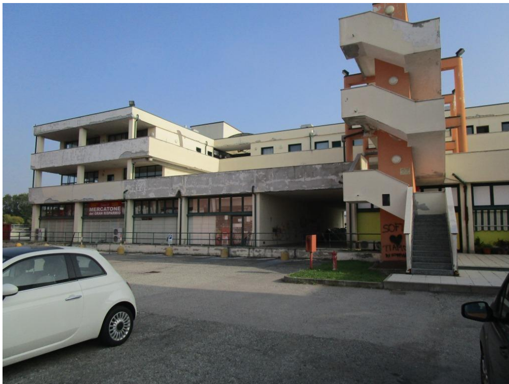
Foto 1 – Vista del complesso immobiliare
