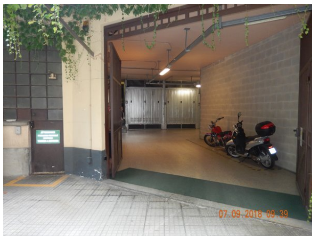
ingresso locali box p.t.
