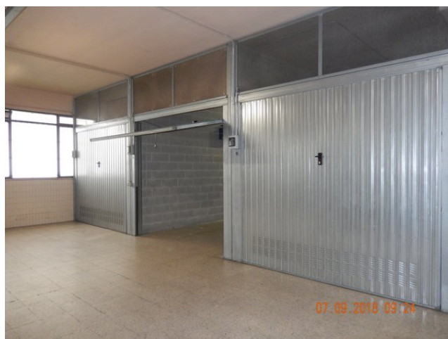
porte di accesso locali box
