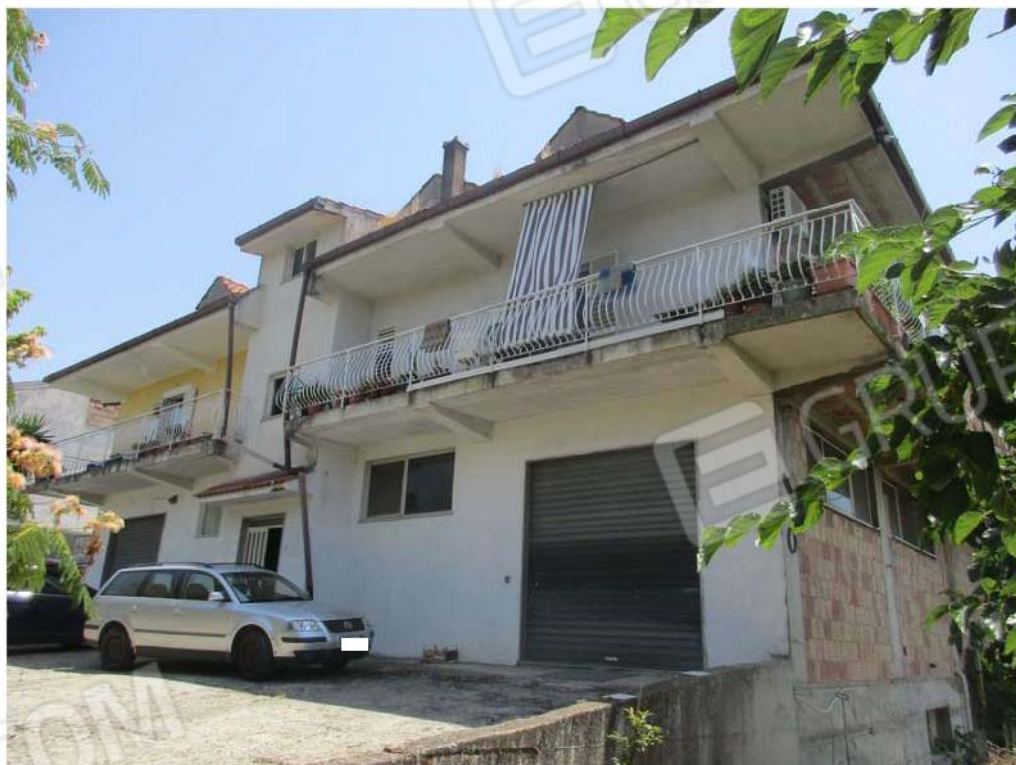
Foto 2: Vista sud ovest del fabbricato
