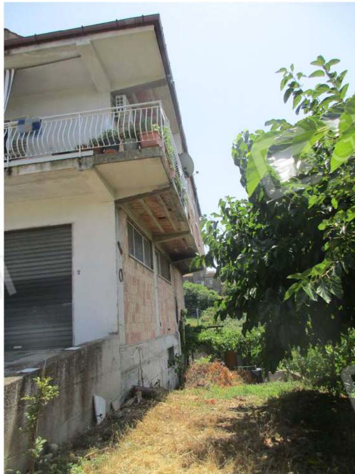
Foto 6: Il fronte Sud del fabbricato
