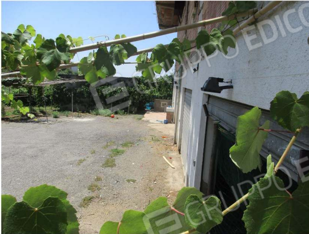
Foto 7: Area esterna esposta ad Est limitrofa agli ingressi al seminterrato
