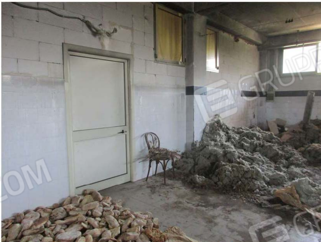
Foto 26 Vista da altra angolazione: in evidenza la parete di separazione con la porzione adibita a magazzino
