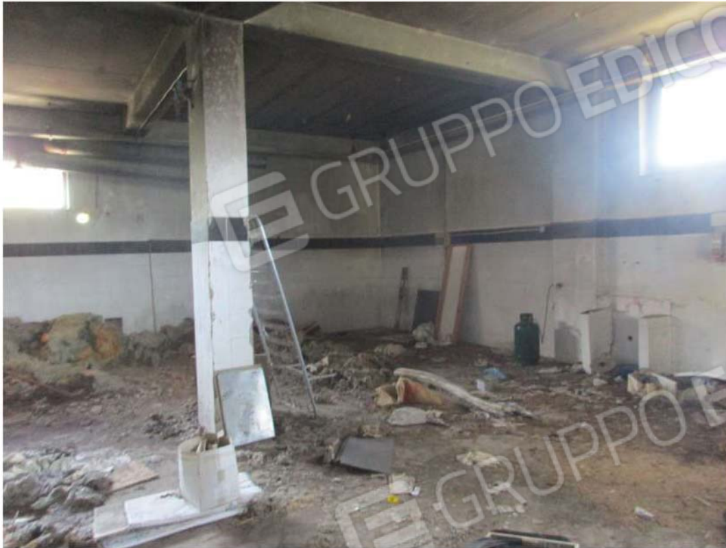
Foto 25: Vista della porzione in passato adibita a forno
