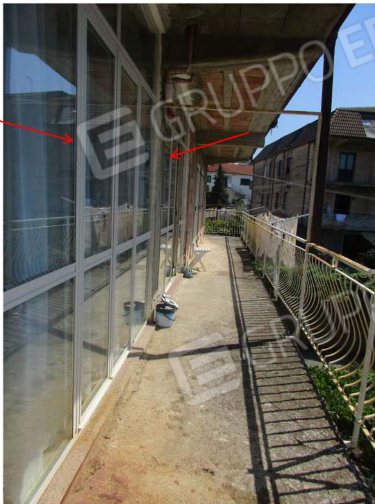
Foto 79: Il balcone sul fronte Sud del fabbricato: le vetrate poste a chiusura delle verande
