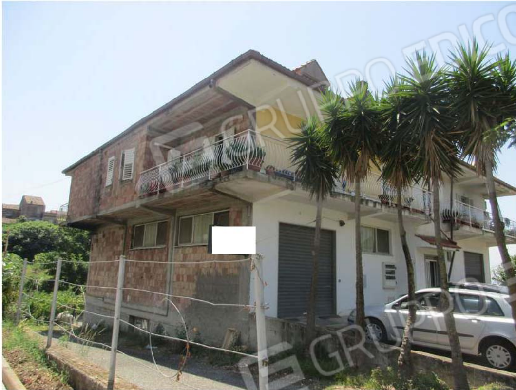
Foto 3: Vista angolo nord-ovest del fabbricato
