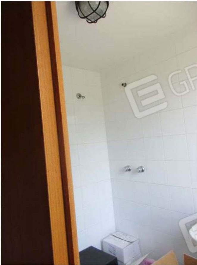
Foto 39: Scorcio del locale doccia
