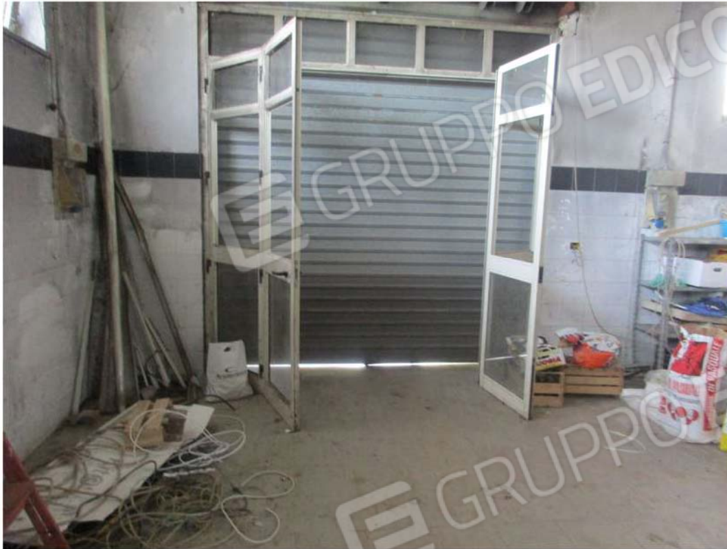
Foto 29: Vista di uno degli accessi esterni
