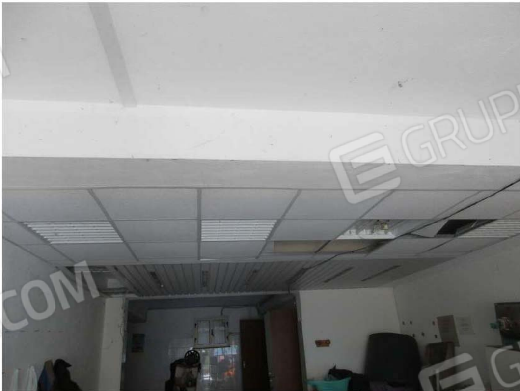
Foto 14: Particolare della controsoffittatura
