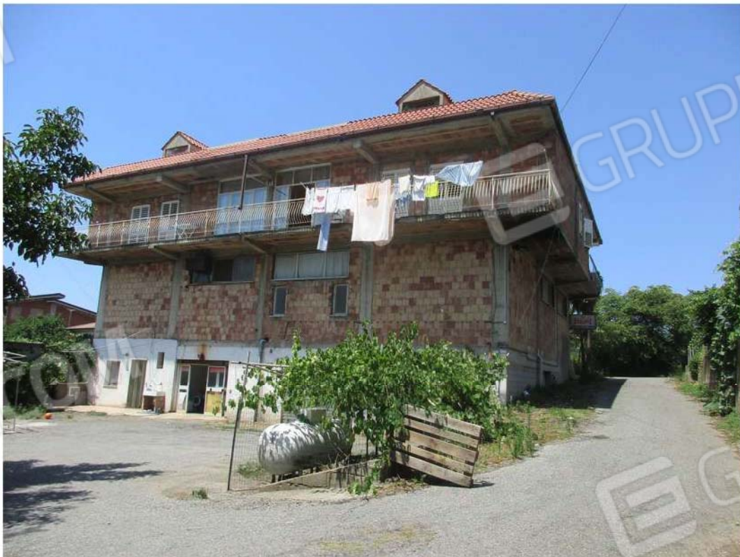
Foto 4: Prospetto est del fabbricato
