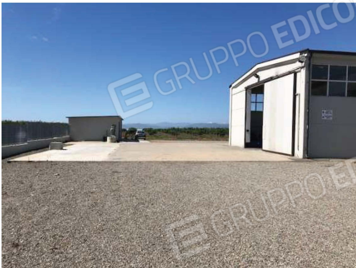
Foto 03 – Vista del deposito posteriore (in fondo a sinistra) e dell'ingresso posteriore del capannone
