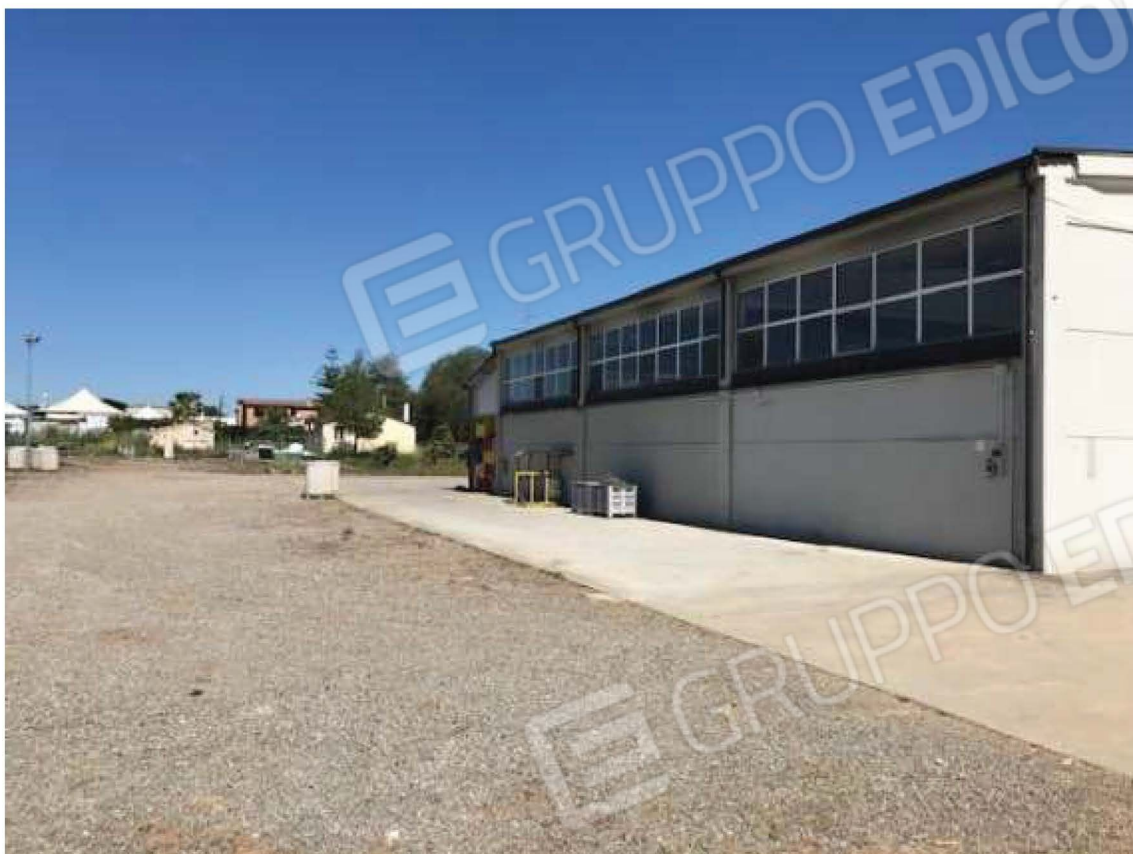
Foto 07 – Vista posteriore del capannone
