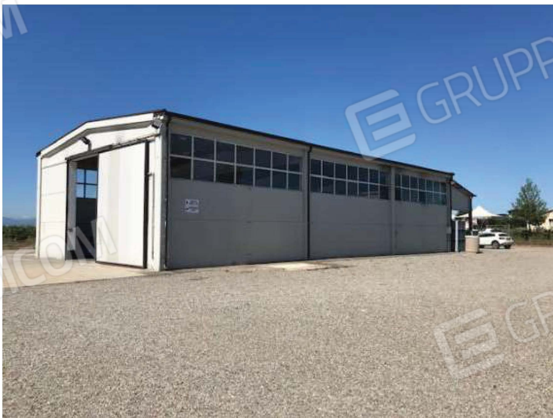
Foto 04 – Vista anteriore del capannone e dell'ingresso posteriore
