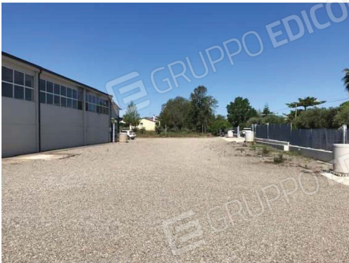
Foto 05 – Pavimentazione rifinita in “brecciato” realizzata tra il capannone e la recinzione su via Parisi
