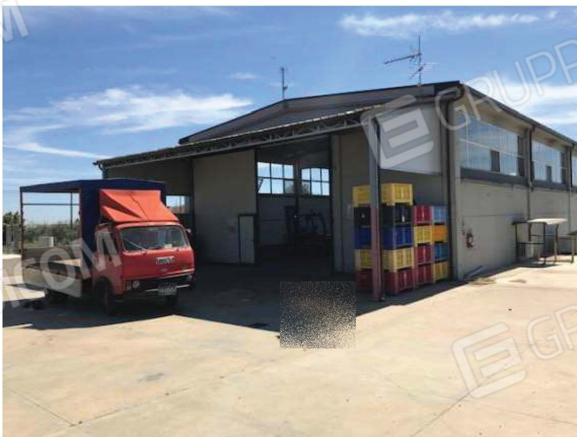
Foto 08 – Vista della tettoia realizzata anteriormente al capannone
