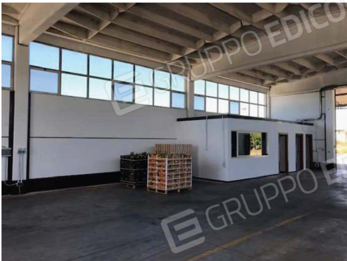
Foto 03 – Vista interna del capannone, con ufficio e WC (parte destra entrando dall'ingresso principale anteriore)
