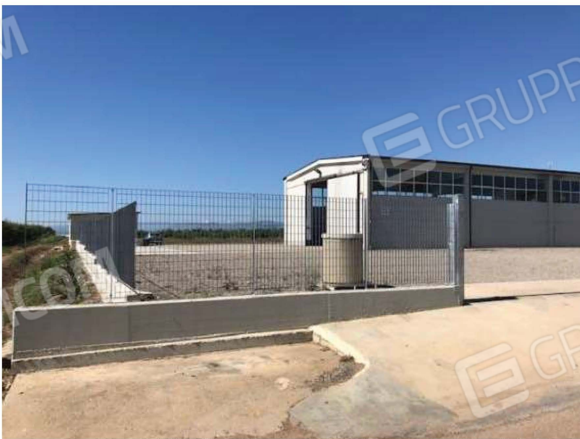
Foto 02 – Vista del capannone dall'ingresso di sinistra
