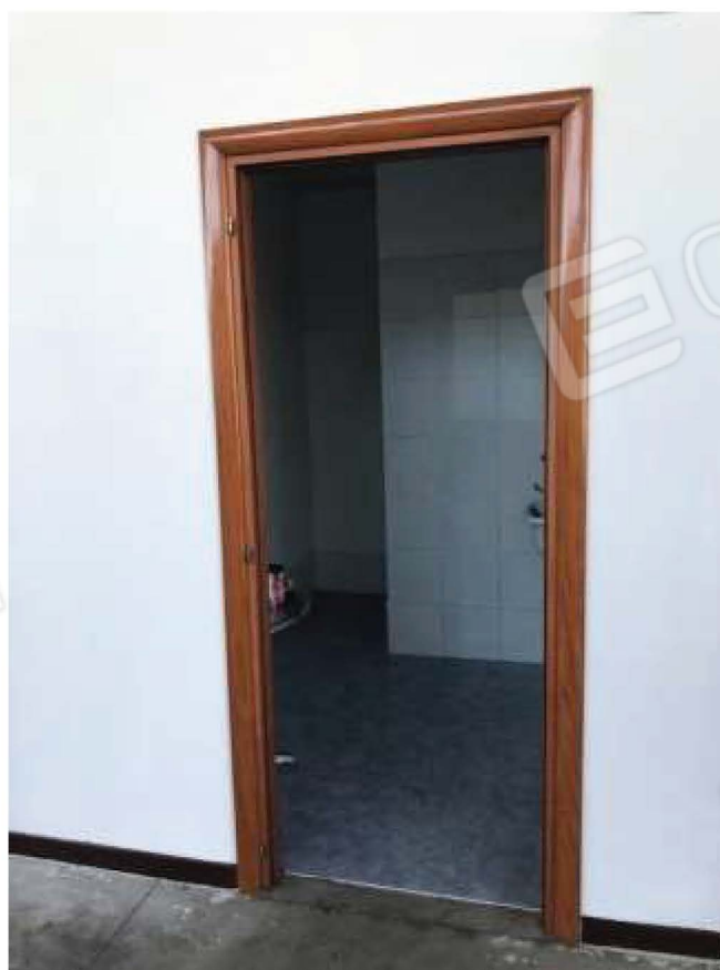
Foto 06 – Dettaglio dell'ingresso nel WC1
