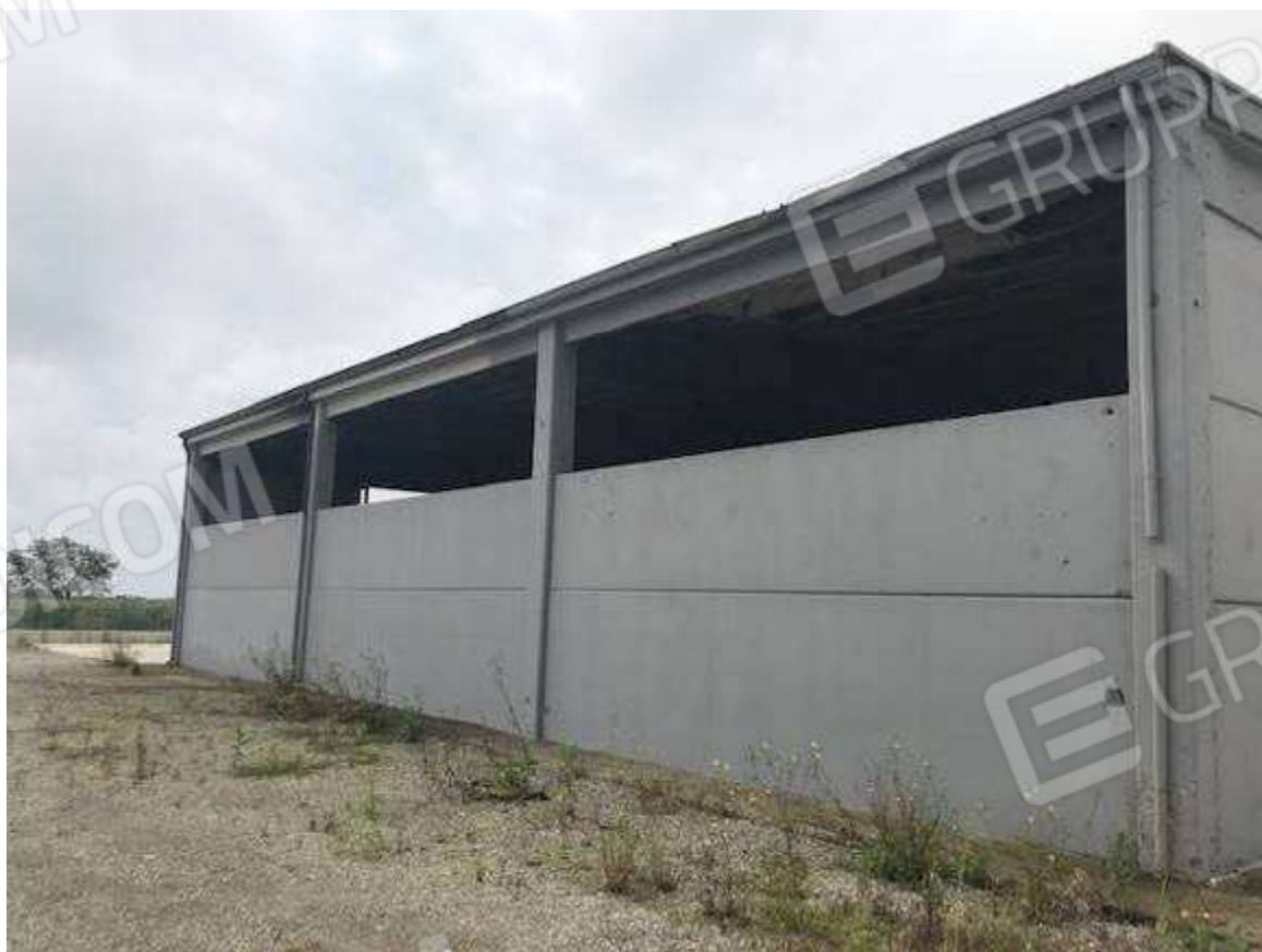
Foto 02 – Esterni del capannone – Vista laterale anteriore (frontistante via Parisi) Le finestre “a nastro” non esistono più.
