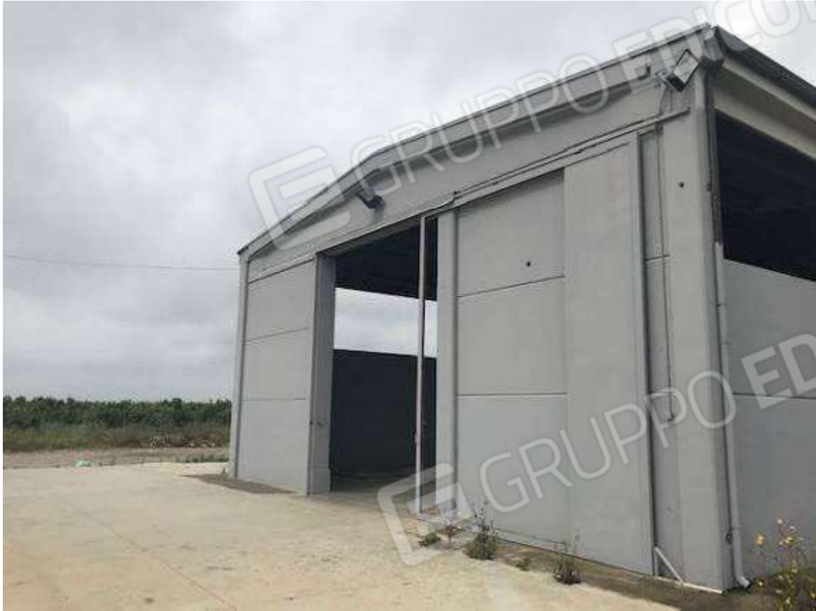
Foto 03 – Esterni del capannone – Vista della testata sinistra (ingresso secondario) Buona parte dei pannelli costituenti il portone d’ingresso non esistono più.
