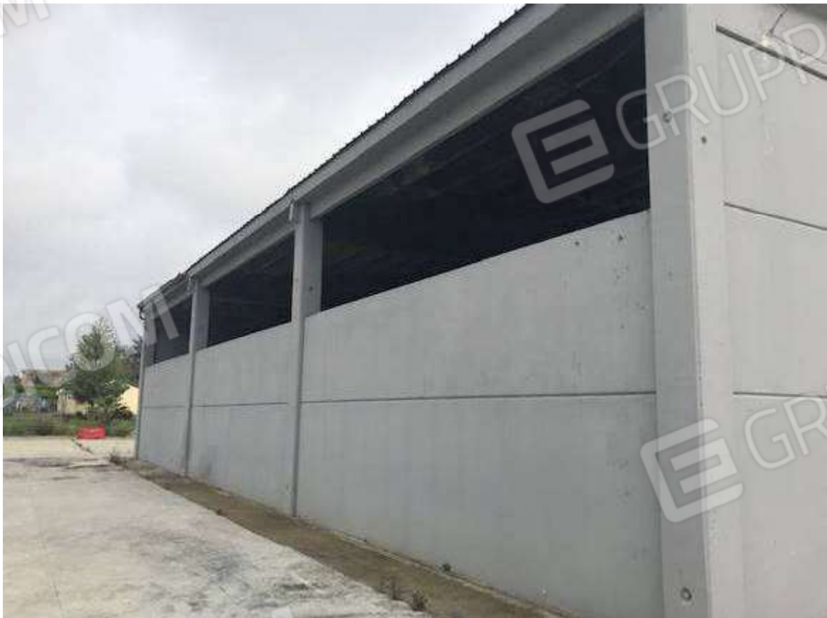
Foto 04 – Esterni del capannone – Vista laterale posteriore (opposta a via Parisi) Le finestre “a nastro” non esistono più.
