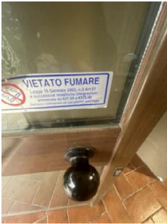
Foto n°6 – Dettaglio porta ingresso
