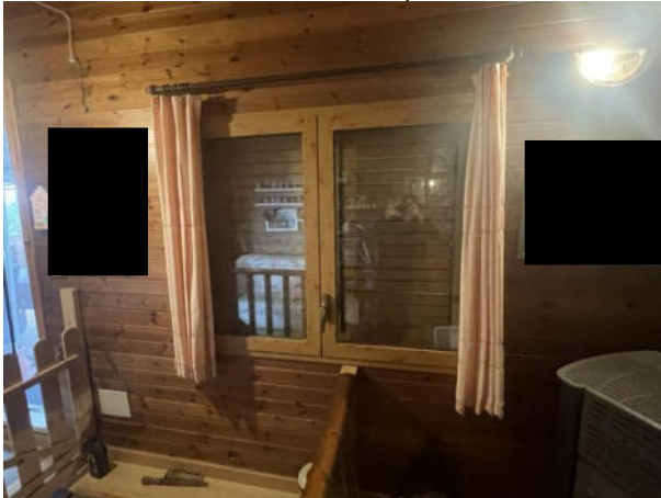
Foto n°40 – Infissi piano rialzato
