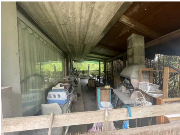
Foto n°66 - Tettoia lato Nord piano seminterrato
