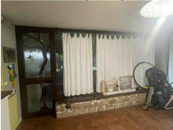
Foto n°8 – Infissi lato Nord
