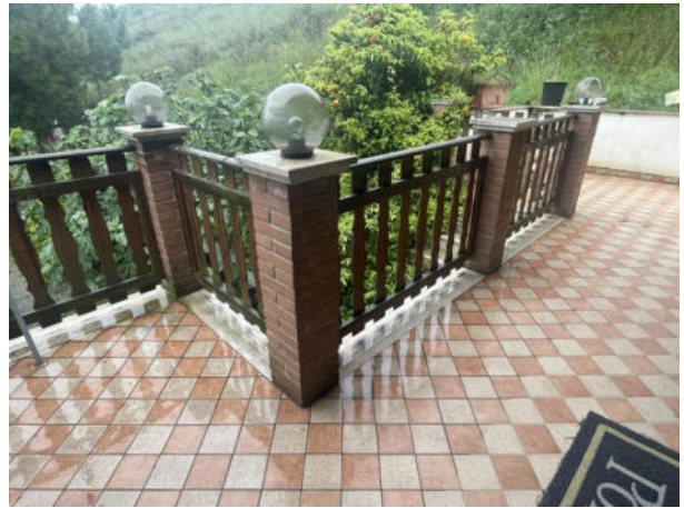
Foto n°63 - Scala esterna di accesso alla terrazza
