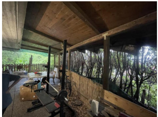
Foto n°67 - Tettoia lato Nord piano seminterrato
