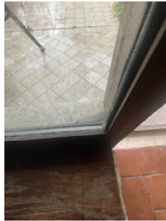
Foto n°7 – Dettaglio infissi lato Est
