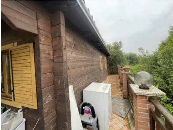
Foto n°56 - Fronte Nord piano rialzato
