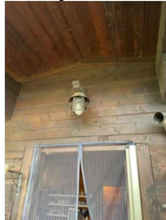
Foto n°51 - Dettaglio ingresso e punto luce esterno
