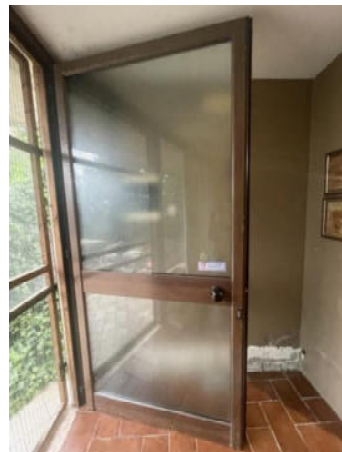
Foto n°5 – Porta di ingresso Est piano seminterrato
