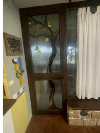
Foto n°9 - Portafinestra lato Nord
