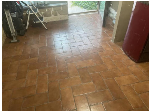
Foto n°11 – Pavimentazione piano seminterrato
