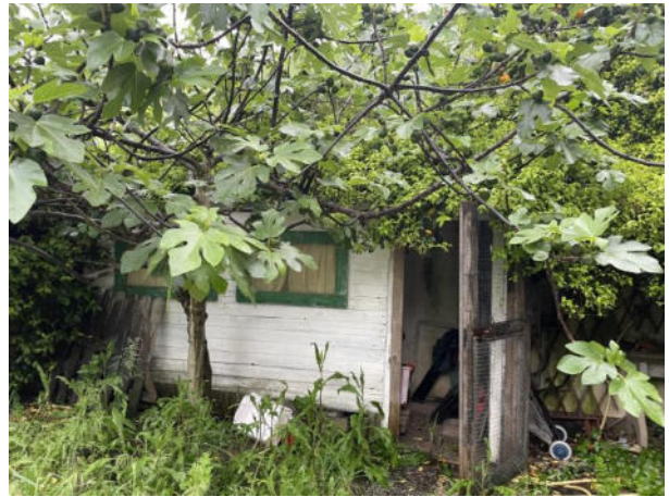
Foto n°71 – Piccolo fabbricato di legno lato Sud
