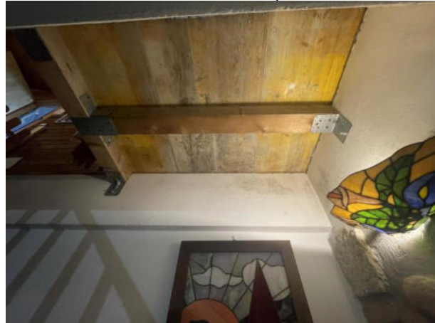
Foto n°33 – Soppalco in prossimità della scala
