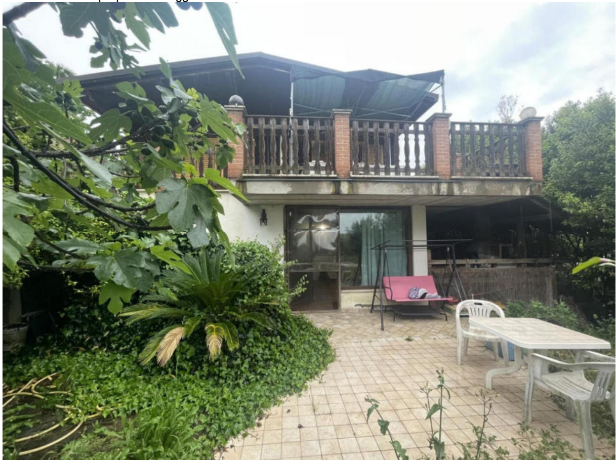
Foto n°3 – Vista edificio lato Est
