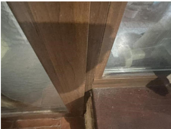
Foto n°10 – Dettaglio infissi lato Nord
