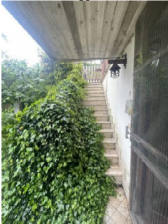
Foto n°64 - Scala esterna di accesso alla terrazza
