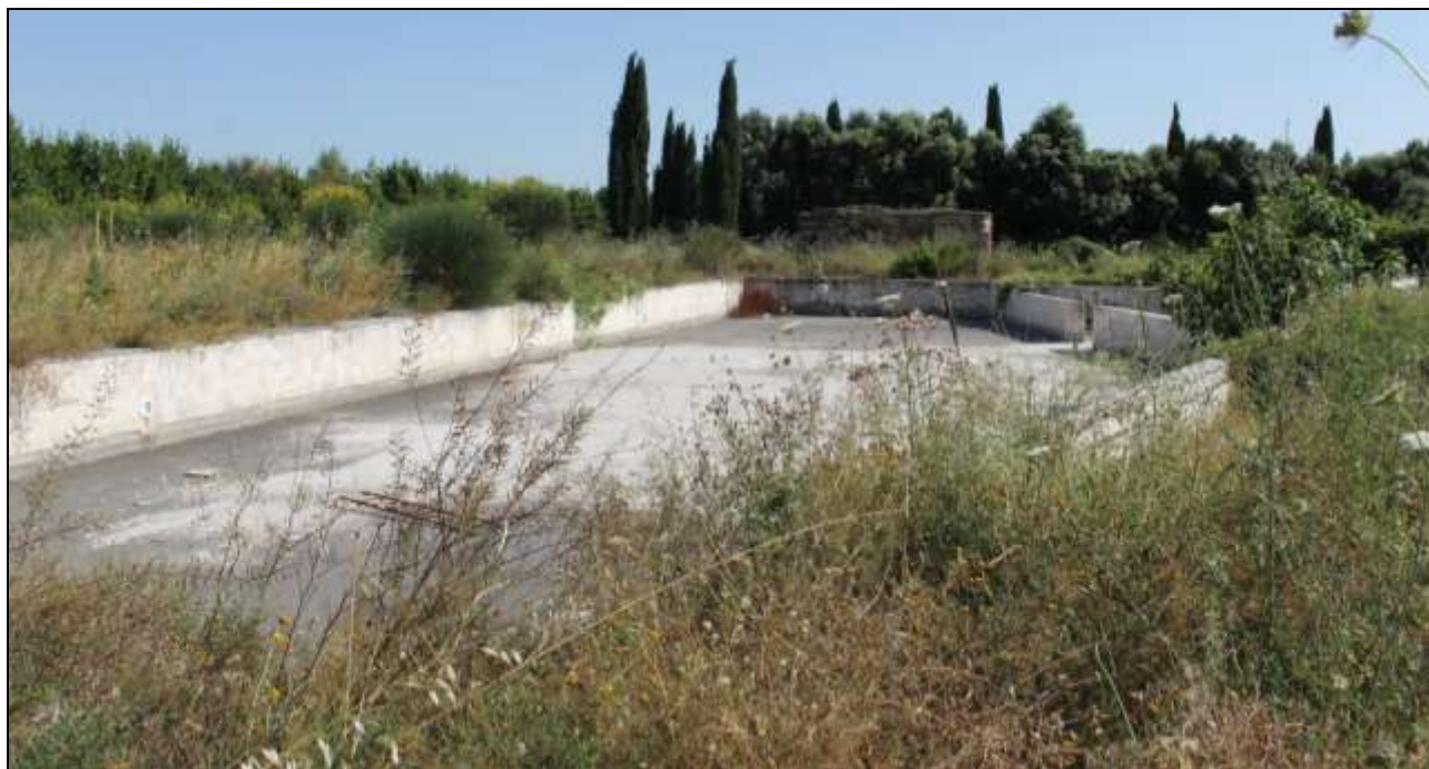
Foto "18" – Vista della "PISCINA clienti esterni"
