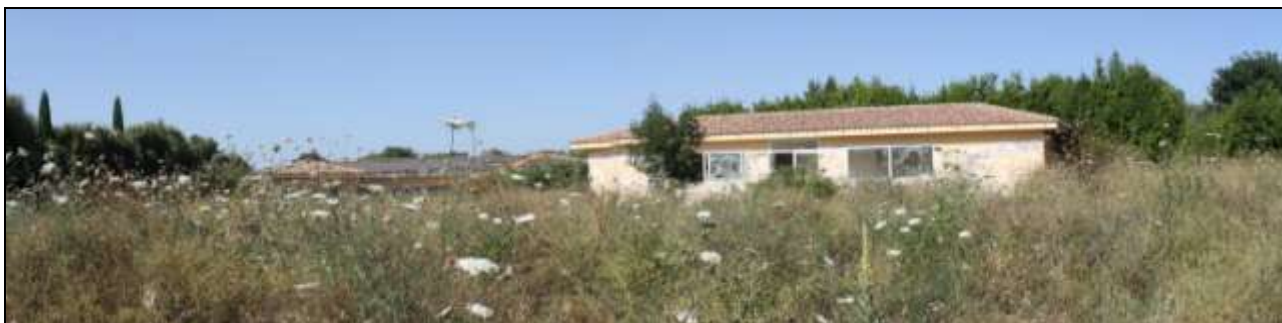
Foto "15" – Vista del Fabbricato "BAR clienti esterni"
