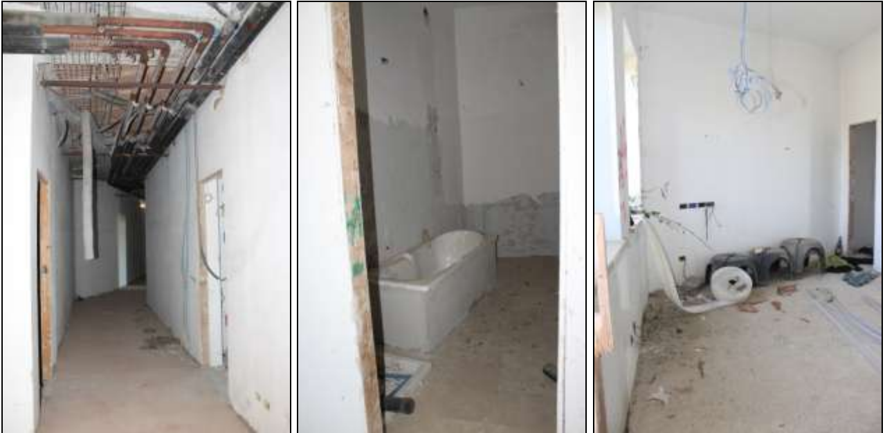
Foto "33-34-35" – Vista Interno del FABBRICATO "A"
