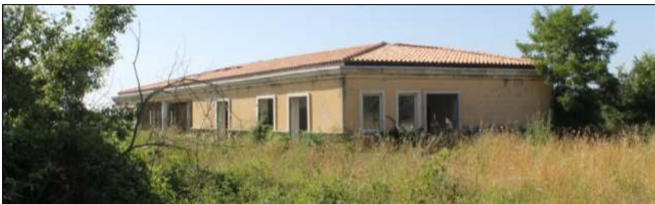
Foto "11" – Vista del FABBRICATO "B"
