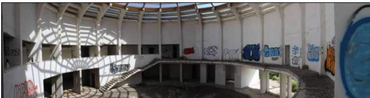
Foto "23" – Vista Interno del FABBRICATO "A"
