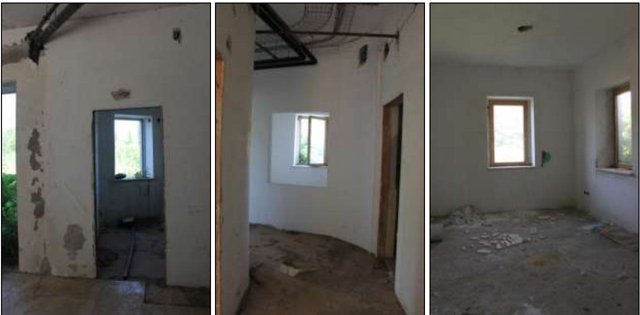
Foto "28-29-30" – Vista Interno del FABBRICATO "A"
