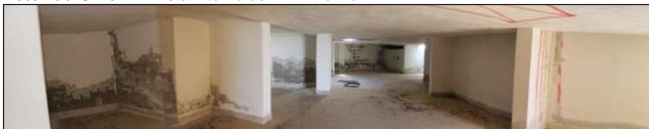
Foto "53" – Vista Interno del FABBRICATO "A"
