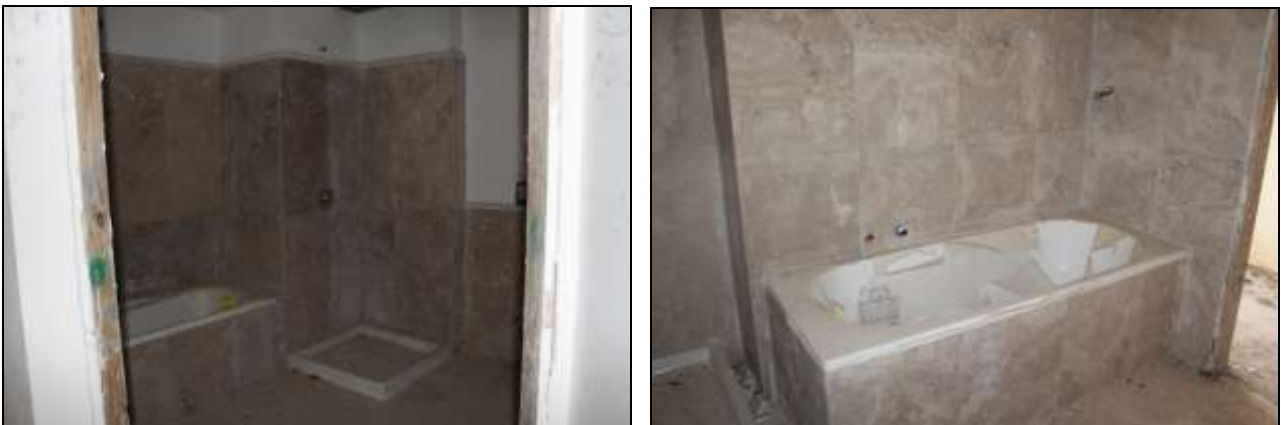
Foto "45-46" – Vista Interno del FABBRICATO "A"
