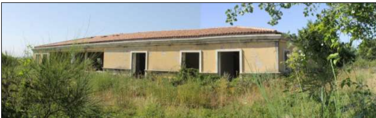
Foto "12" – Vista del FABBRICATO "B"
