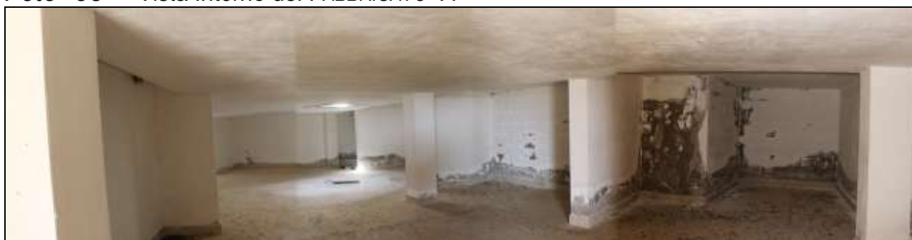
Foto "54" – Vista Interno del FABBRICATO "A"
