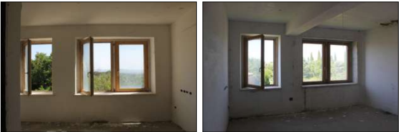
Foto "43-44" – Vista Interno del FABBRICATO "A"
