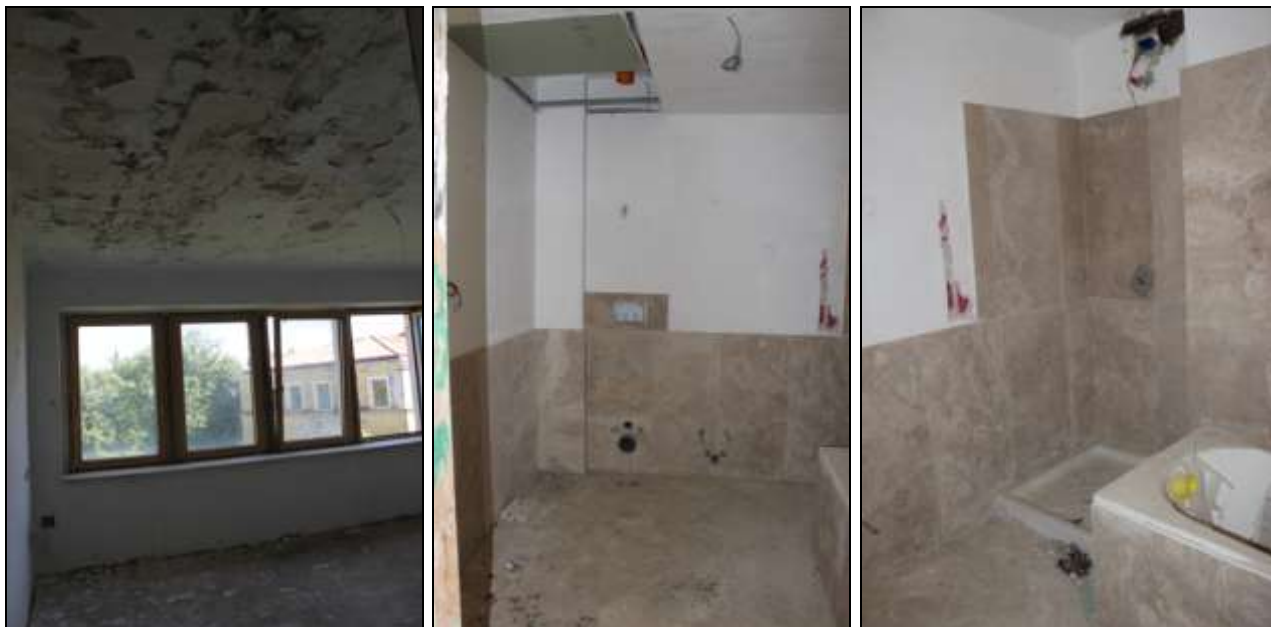
Foto "47-48-49" – Vista Interno del FABBRICATO "A"
