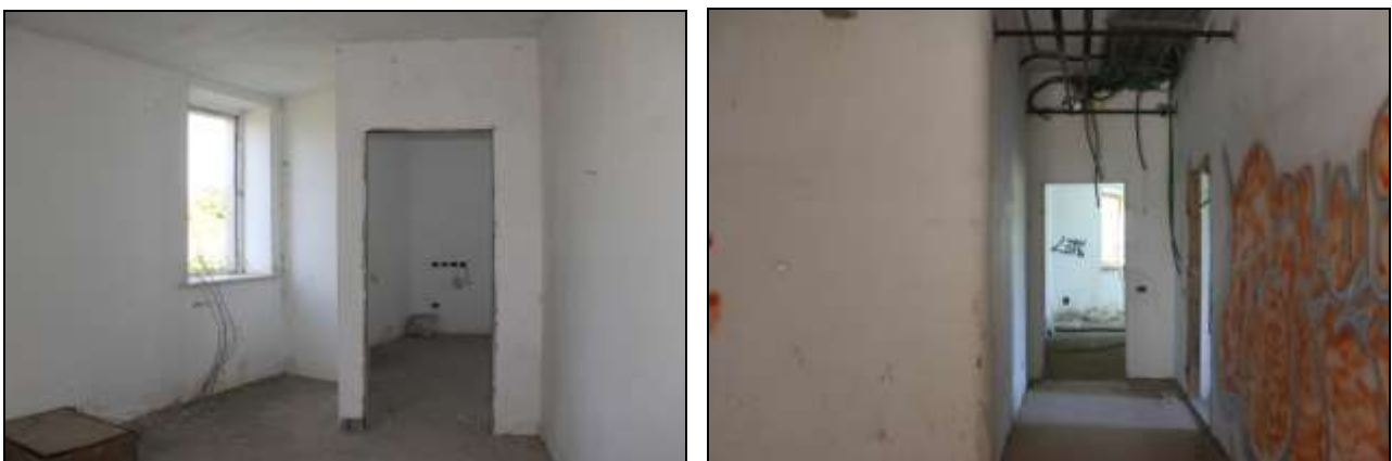
Foto "38-39" – Vista Interno del FABBRICATO "A"
