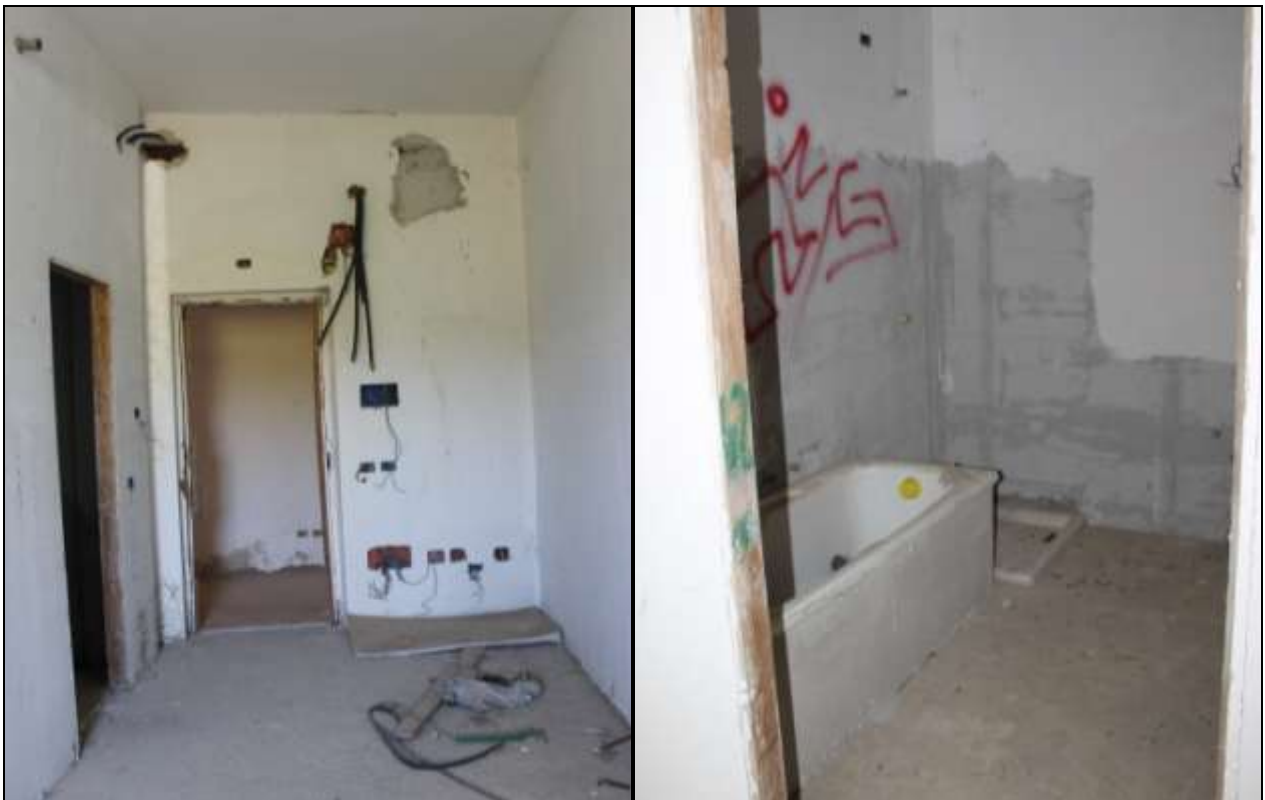
Foto "36-37" – Vista Interno del FABBRICATO "A"
