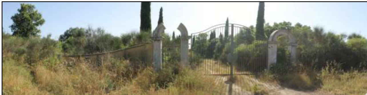
Foto "1" – Vista dell'Ingresso Principale sulla Strada Vicinale del Tosteto
