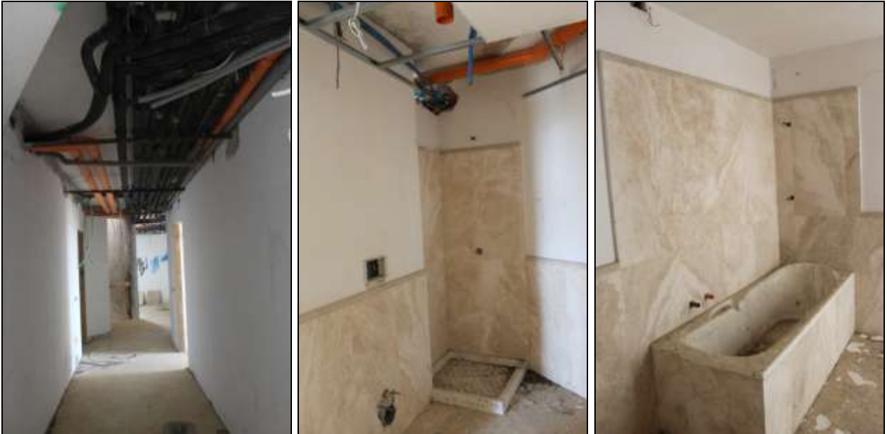
Foto "40-41-42" – Vista Interno del FABBRICATO "A"
