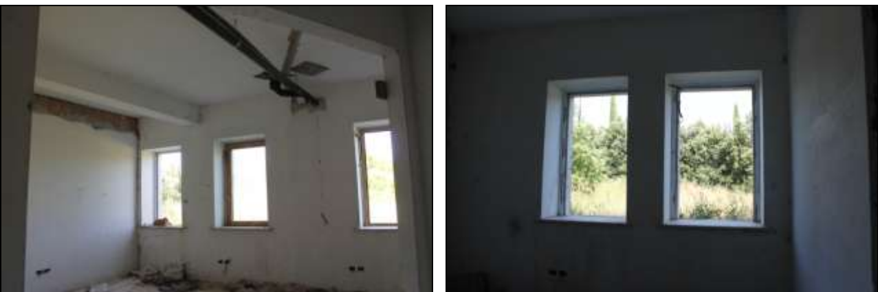
Foto "31-32" – Vista Interno del FABBRICATO "A"
