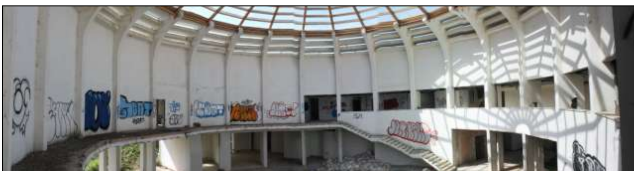
Foto "24" – Vista Interno del FABBRICATO "A"
