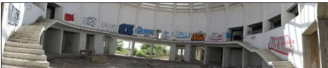
Foto "22" – Vista Interno del FABBRICATO "A"
