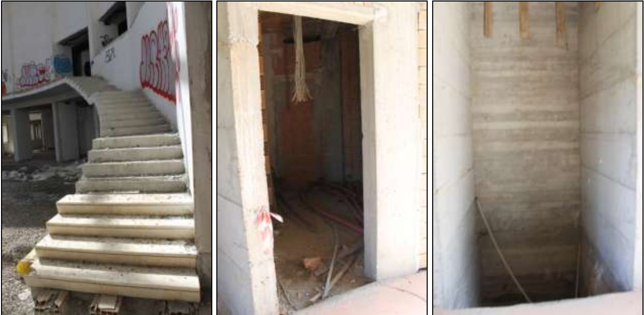
Foto "25-26-27" – Vista Interno del FABBRICATO "A"
