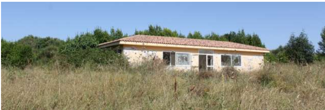
Foto "16" – Vista del Fabbricato "BAR clienti esterni"
