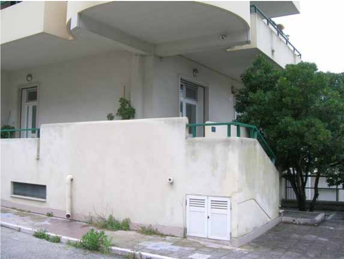
Angolo del vano n. 1 – veduta esterna.
