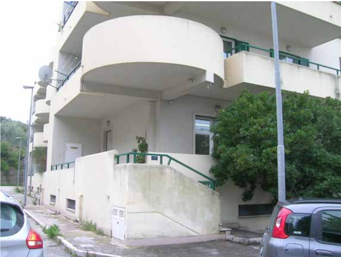
Prospetto retrostante Via Dante Alighieri – ingresso civico n. 117.
