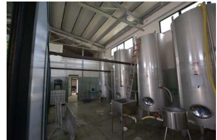
Foto 10 – Capannone area silos
