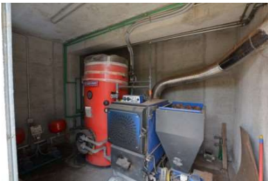
Foto 24 – Capannone - Locale caldaia
