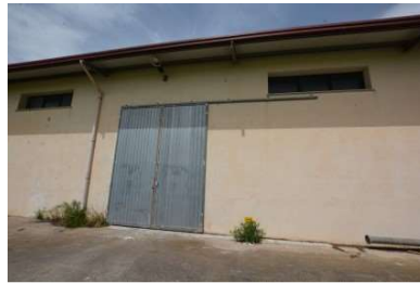
Foto 21– Capannone prospetto SUD - Ingresso carrabile
