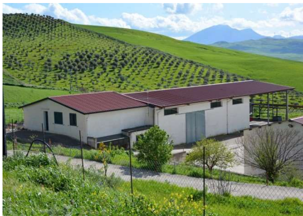
Foto 2 - Capannone Fg. 30, p.lla 630 sub. 1 e 2
