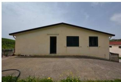
Foto 29 - Ingresso alloggio da p.lla 629
