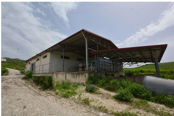
Foto 3 - Capannone Fg. 30, p.lla 630 sub. 1 e 2
