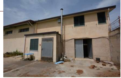
Foto 19 – Capannone prospetto SUD - Locale caldaia e porticato/deposito
