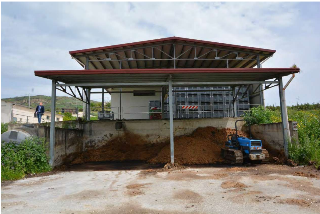
Foto 27 – Capannone ind. (Bene 2 e 3) – tettoia prospetto SUD – Particolare pannelli solari Foto 28 - Capannone ind. (Bene 2) – prospetto Ovest – Tettoie (2) e (1)
