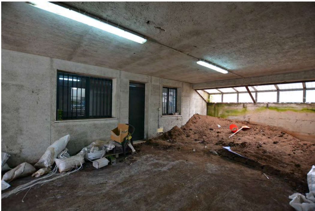
Foto 13 - Capannone industriale (Bene 2) – Deposito (ex portico)
