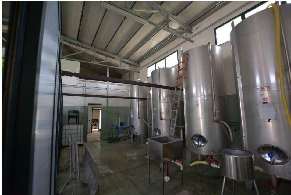
Foto 9 – Capannone industriale (Bene 2) - area magazzino e silos
