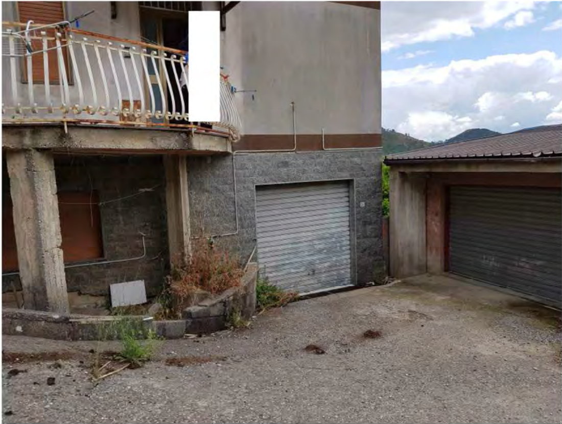
Prospetto lato garage
