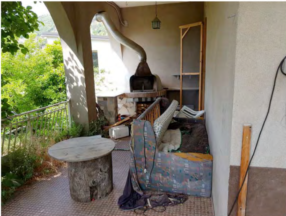
Piano seminterrato: portico
