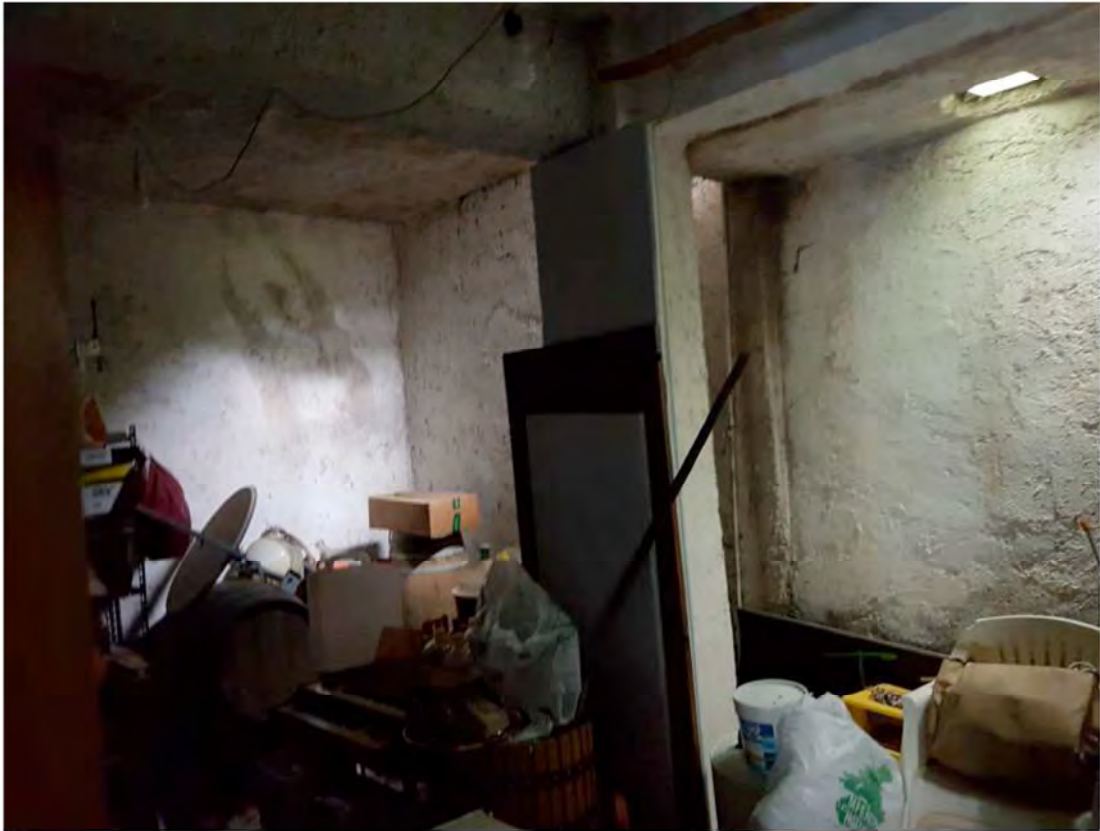
Piano seminterrato: cantina
