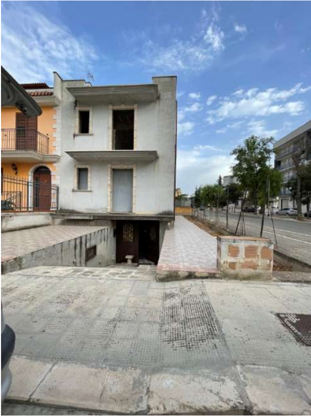
Figura 3. LOTTO UNICO: Fabbricato unifamiliare in cui si trovano gli immobili pignorati al F. 8, P.IIa 3929, Sub. 1 e 2 ubicati in San Ferdinando di Puglia (BT) alla Via V. Bachelet n. 2 e 4 (facciata prospiciente la Via V. Bachelet).
