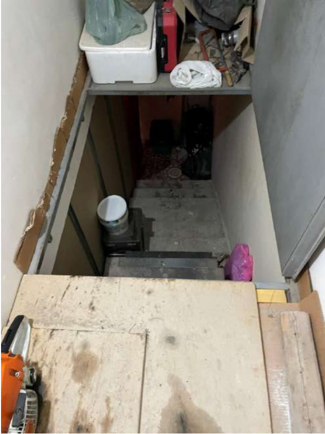
Figura 14. LOTTO UNICO: Immobile pignorato al F. 8, P.IIa 3929, Sub. 1 e 2 ubicato in San Ferdinando di Puglia (BT) alla Via V. Bachelet n. 2 e 4 (botola e scala interna di collegamento tra box-auto e appartamento).
