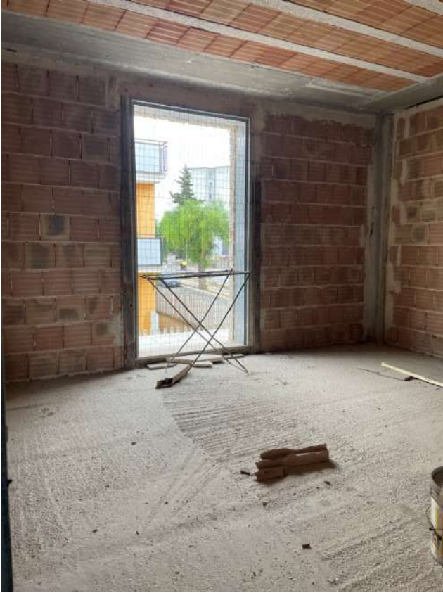
Figura 10. LOTTO UNICO: Immobile pignorato al F. 8, P.IIa 3929, Sub. 1 ubicato in San Ferdinando di Puglia (BT) alla Via V. Bachelet n. 4 (vano prospiciente la Via V. Lenoci posto al piano primo).
