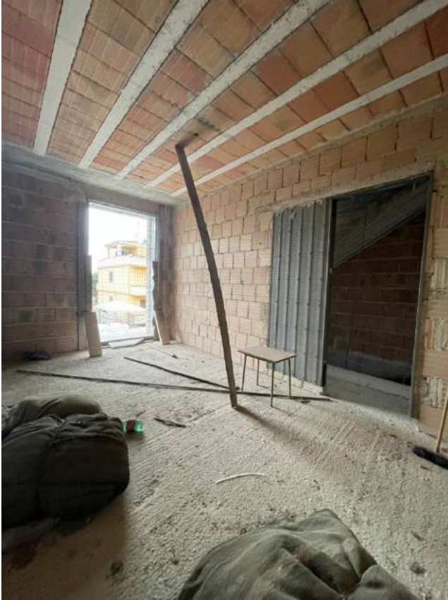
Figura 8. LOTTO UNICO: Immobile pignorato al F. 8, P.IIa 3929, Sub. 1 ubicato in San Ferdinando di Puglia (BT) alla Via V. Bachelet n. 4 (vano prospiciente la Via V. Bachelet posto al piano primo).
