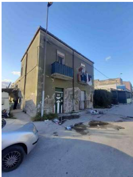
Foto 1 – LOTTO B – Via Marina di Ponente, 67 – Appartamento e Deposito
