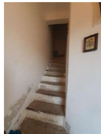
Foto 4 – Vano scala per accesso ad appartamento 1° piano
