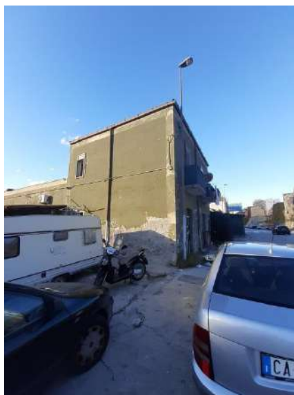
Foto 2 – Fabbricato Via Marina Ponente, 67
