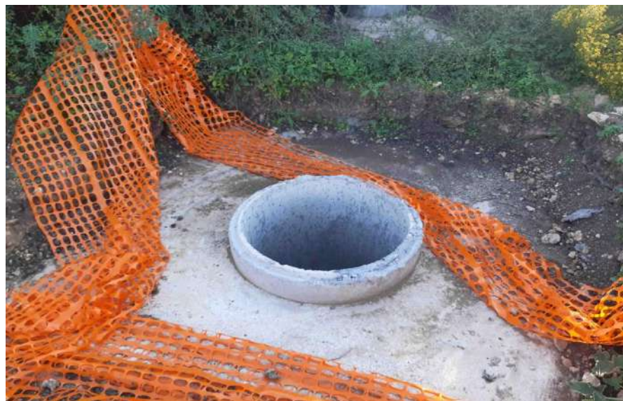
Foto 4 – Foro per palificazione elettrica
