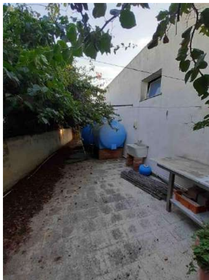
Foto 16 – Esterno Locale Tecnico
