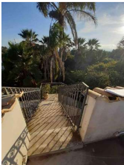
Foto 8 – Scala di accesso al lastrico solare
