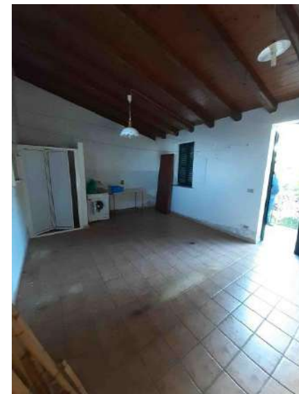
Foto 18 – Locale Tecnico: Vano_1
