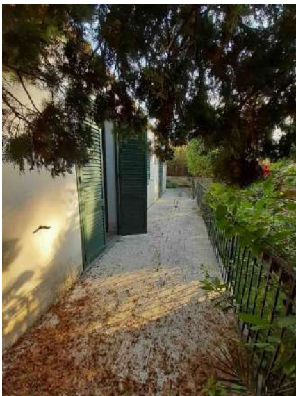
Foto 15 – Fabbricato Locale Tecnico
