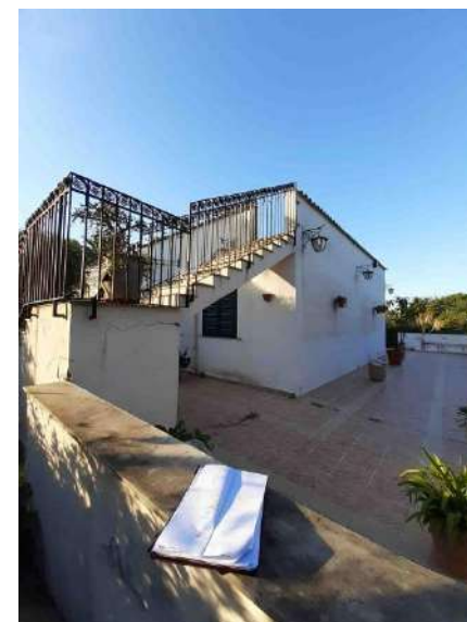
Foto 7 – Scala di accesso al lastrico solare
