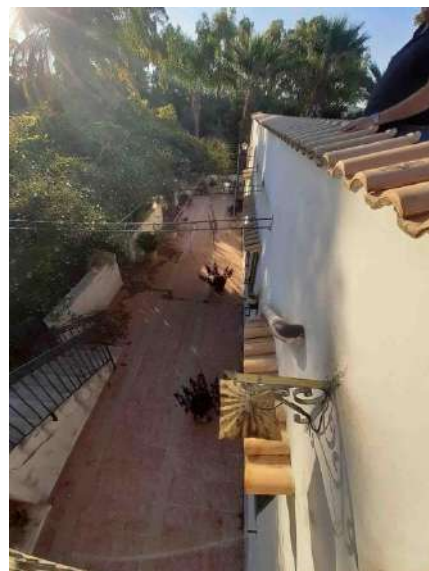
Foto 10 – Veranda versante Sud
