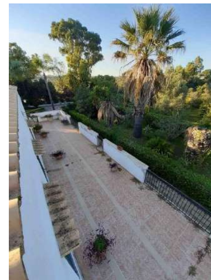
Foto 11 – Veranda versante Nord
