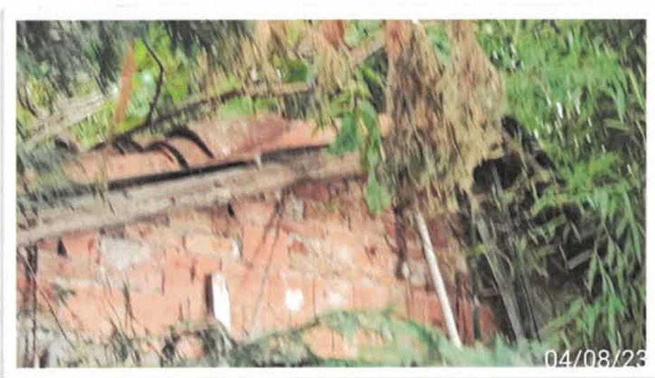
Locali inaccessibili ad uso deposito
