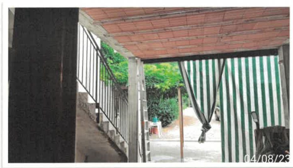
Soletta e pilastri terrazzo da regolarizzare
