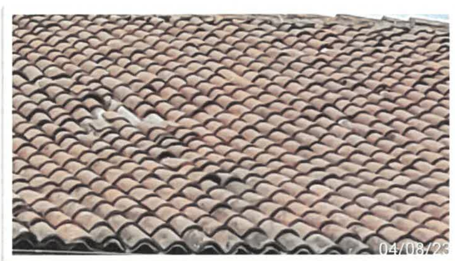
Particolare tetto in coppi da ristrutturare
