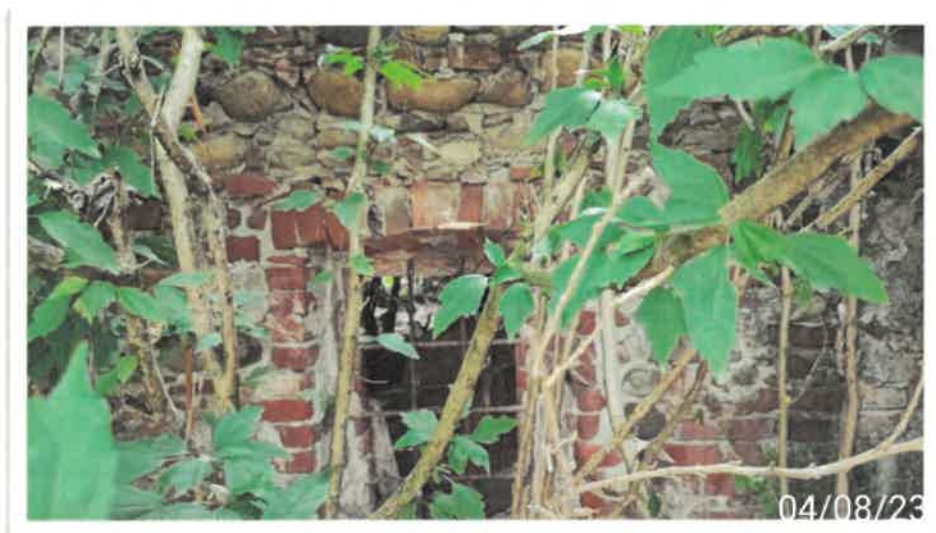
Locali inaccessibili ad uso deposito
