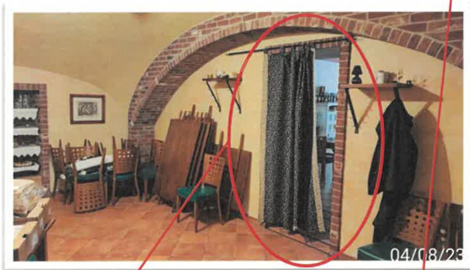
Locale di sgombero P.T.
