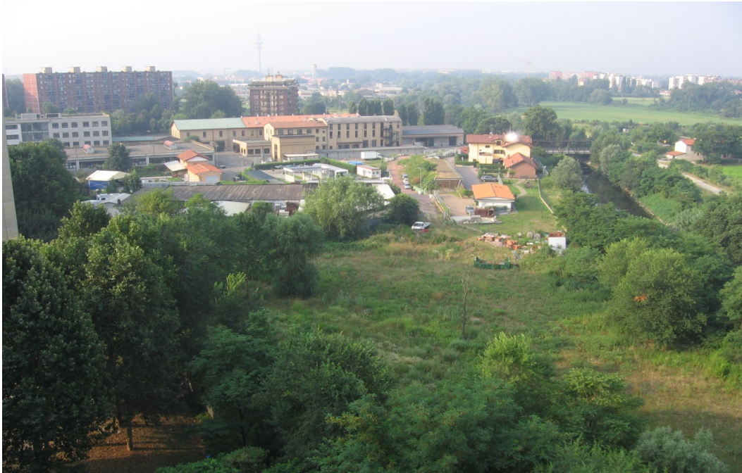
Lotto n. 1 (A) – Situazione dell’area di intervento prima dell’inizio dei lavori
