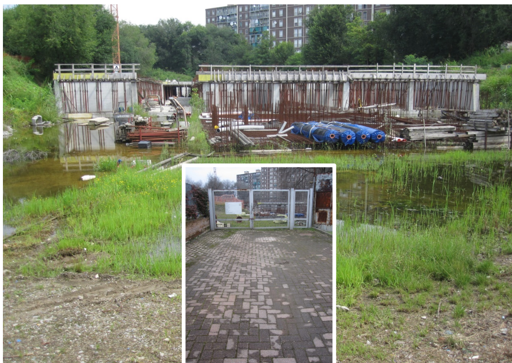
Lotto n. 1 (A) – Ingresso e visioni d'insieme del cantiere
