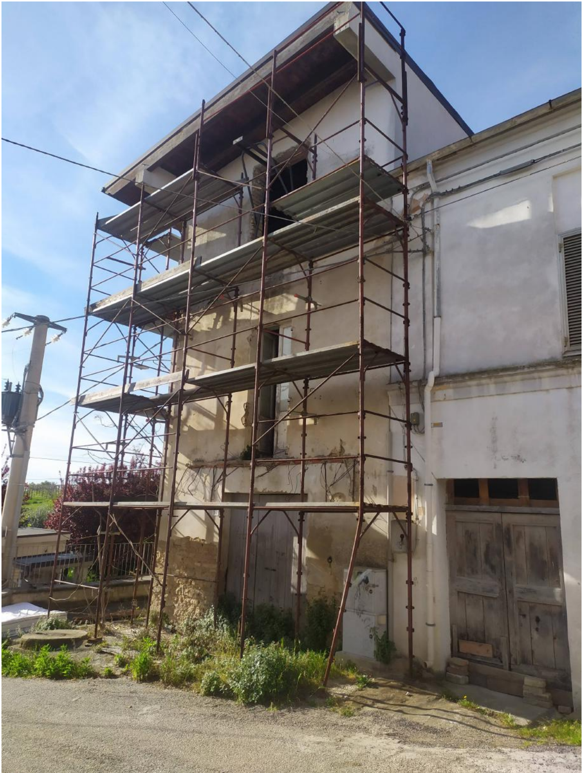
Esterno (foglio 14 n. 120 sub. 8)
