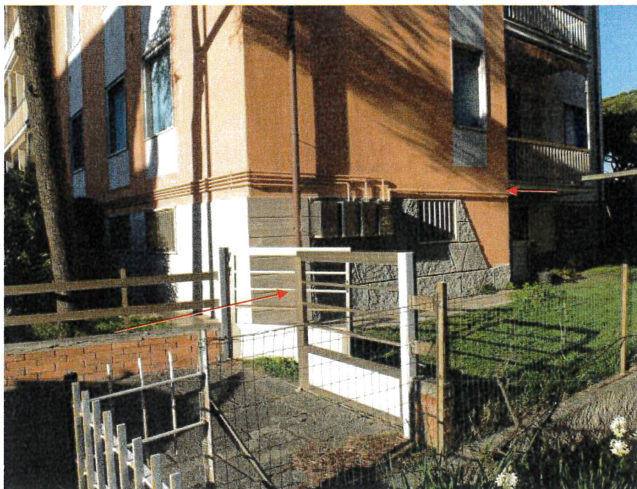
Foto1 – Accesso sud alla corte comune da via Silvio Pellico
