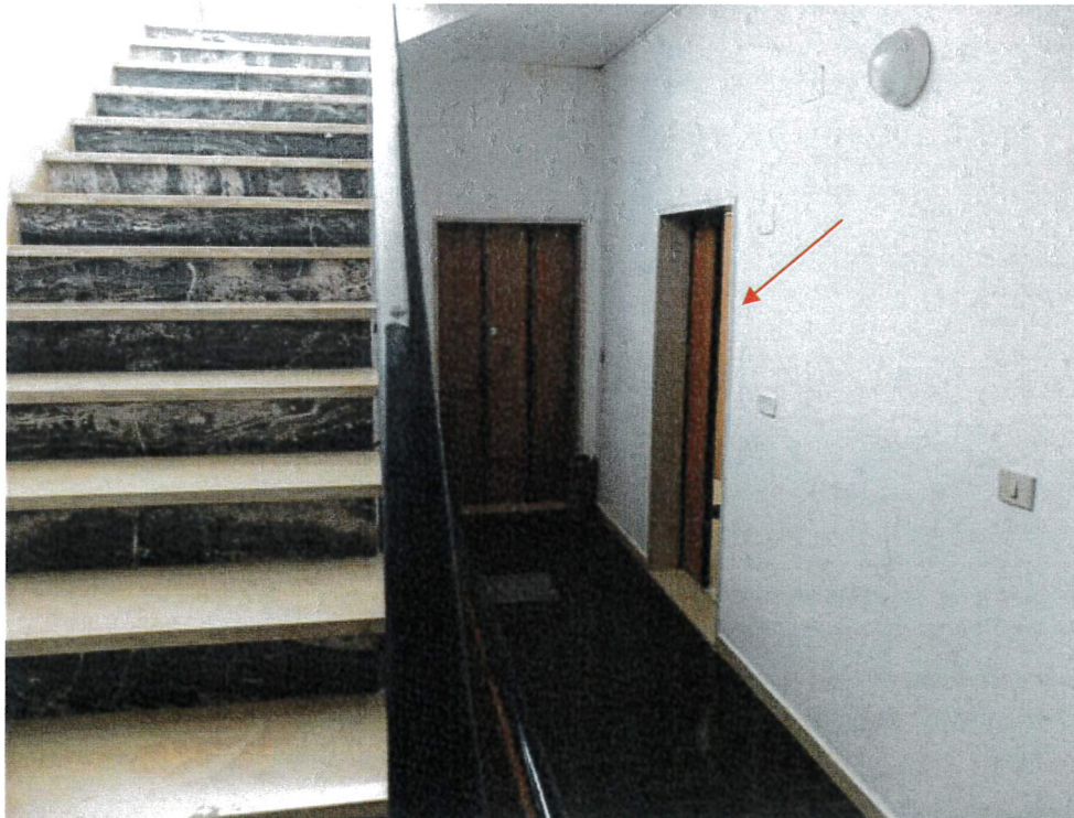
Foto 6 – pianerottolo condominiale 3° piano – ingresso al corridoio comune
