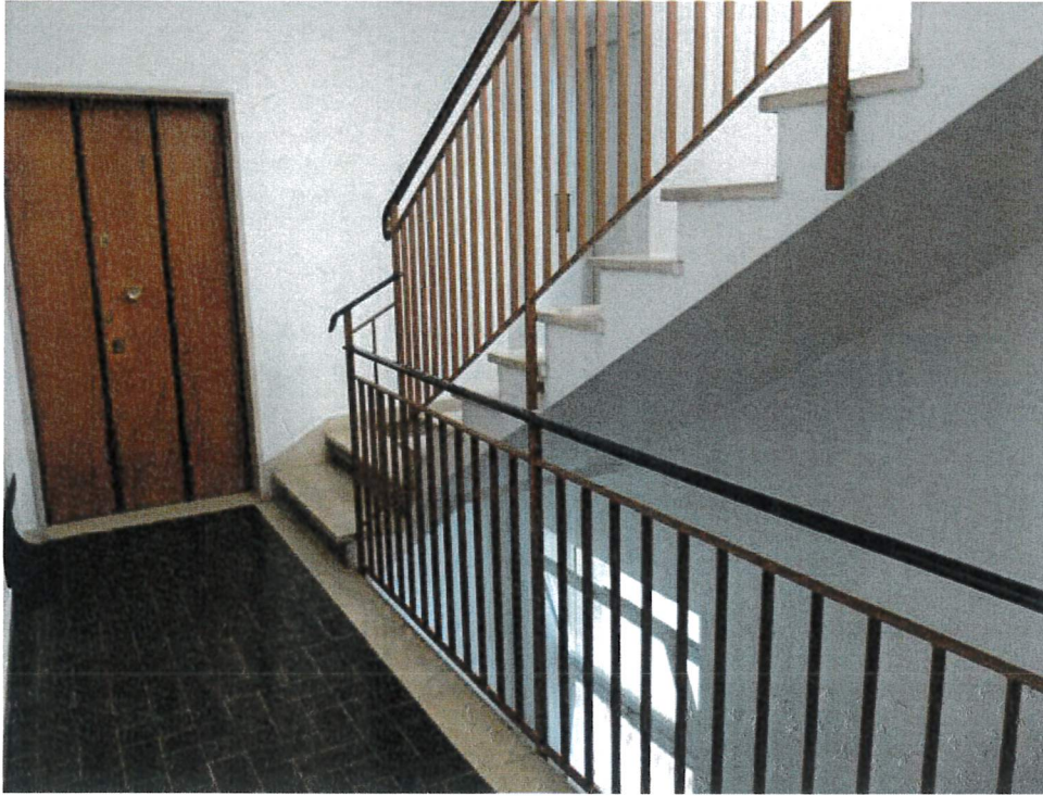
Foto 5 – pianerottolo condominiale 3° piano
