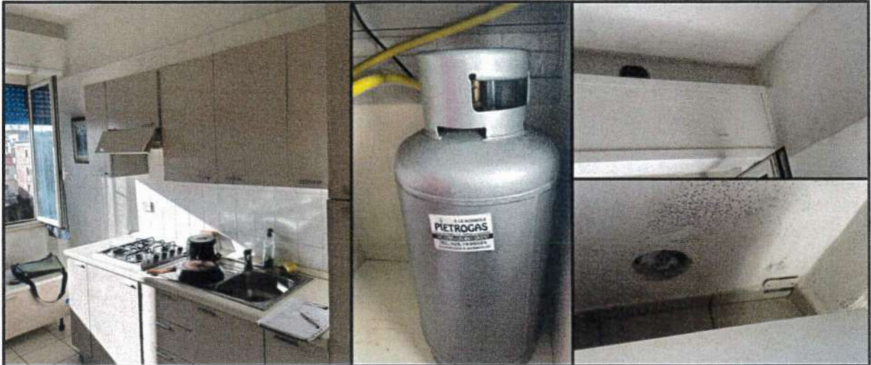
Impianto gas: piano cottura e fori nel vano giorno dell'immobile residenziale
