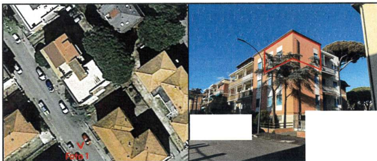
Accesso all'immobile: ortofoto e vista degli immobili
