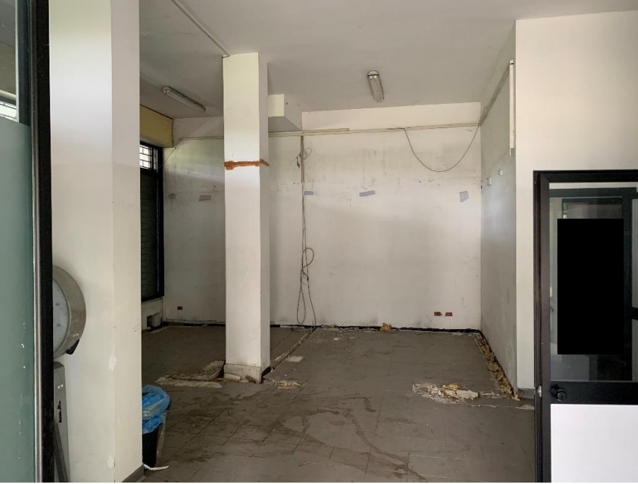
19 locale negozio a piano terra vista interna
