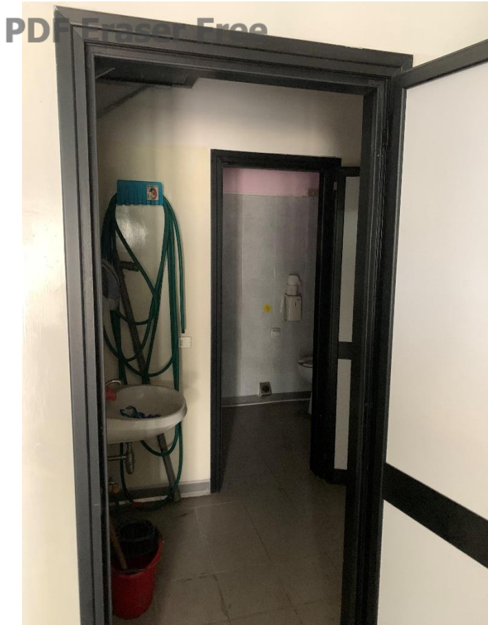
21 locale negozio a piano terra ingresso disimpegno zona bagno
