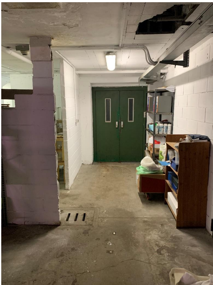
12 zona piano interrato
