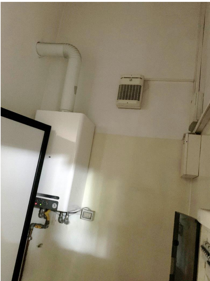
22 locale disimpegno a piano terra
