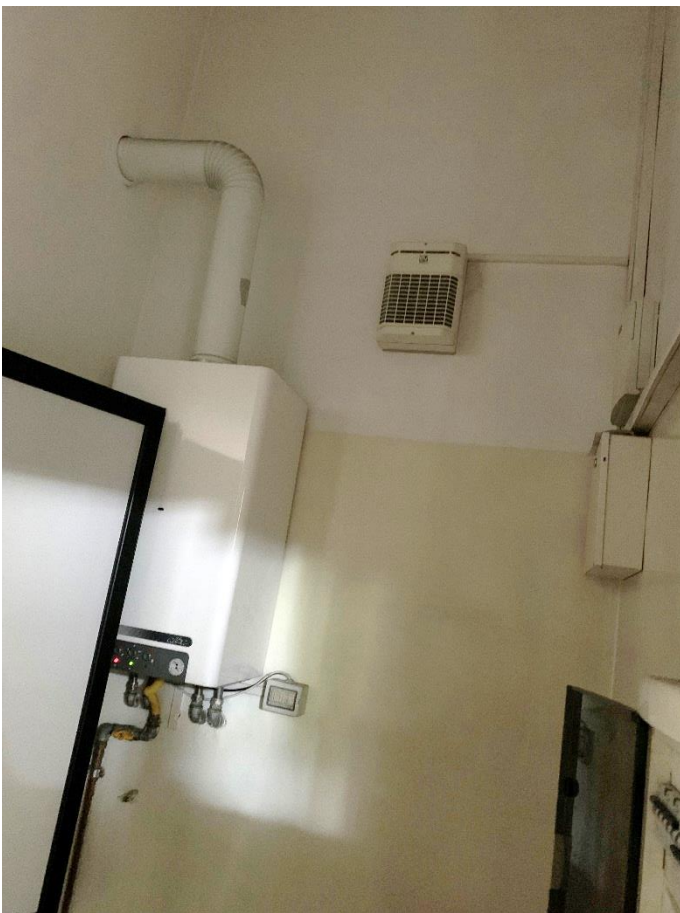
22 locale disimpegno a piano terra
