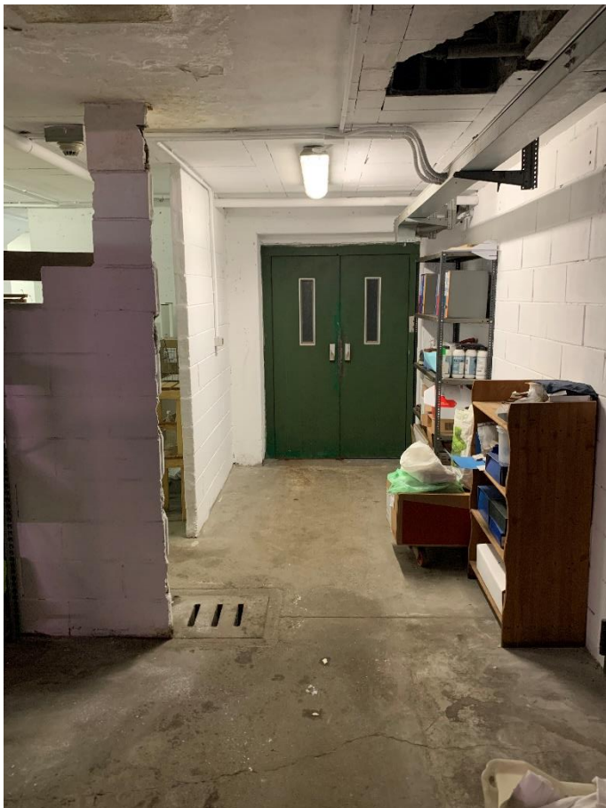
12 zona piano interrato
