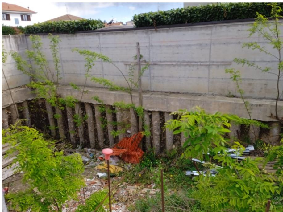
*Figura 6\_PARTICOLARE PALIFICAZIONE A CONFINE*
