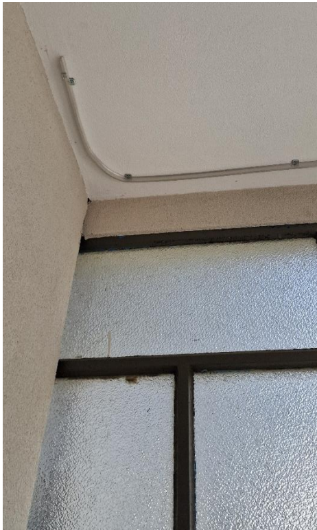
Foto n.39 – Poggiolo – vista di dettaglio n.3
