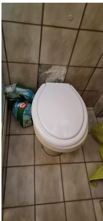
Foto n.28– Bagno wc– vista di dettaglio n.3
