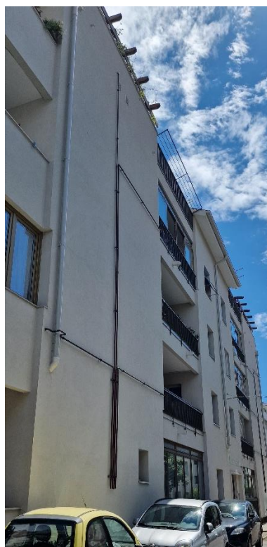
Foto n. 2 – Facciata d'ingresso dell'edificio – vista n.2
