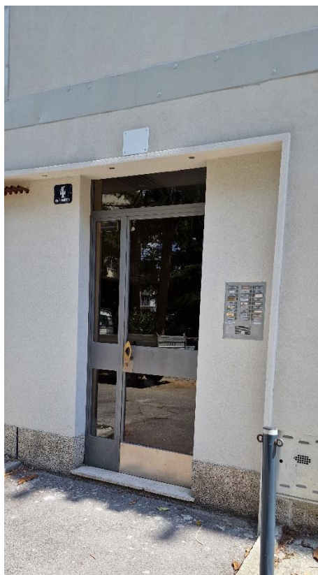
Foto n.7 – Portone d’ingresso dell’ edificio
