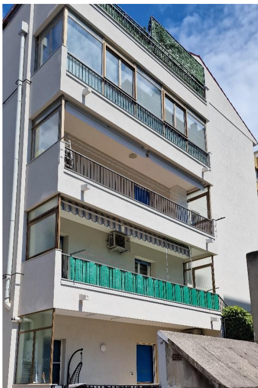
Foto n.5 — Facciata laterale dell'edificio
