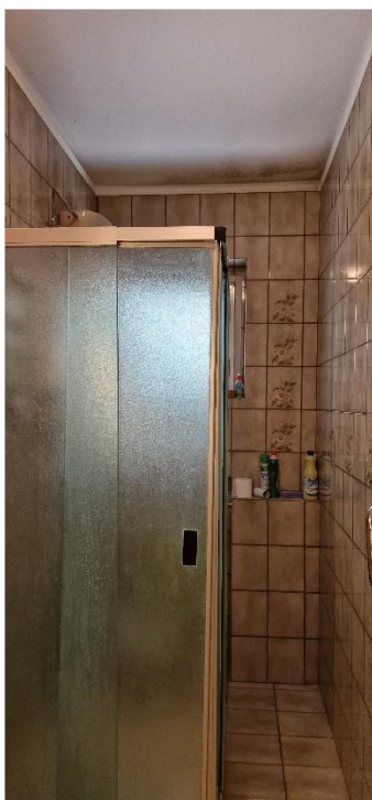
Foto n.27 – Bagno wc– vista di dettaglio n.1
