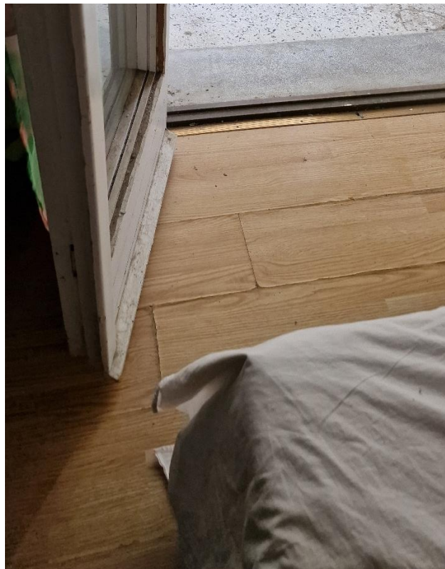
Foto n.20 – Stanza – vista di dettaglio n.7
