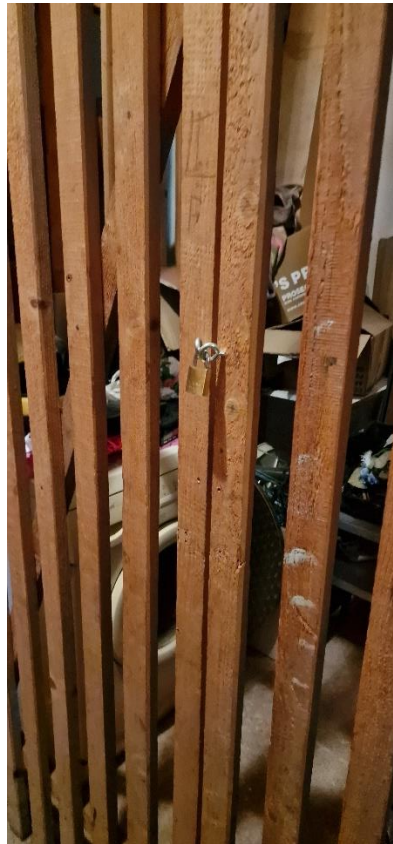
Foto n.42 – Cantina- vista di dettaglio n.1
