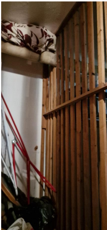
Foto n.45 – Cantina – vista di dettaglio n.4
