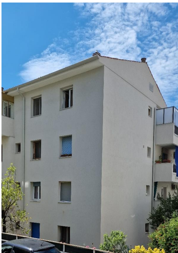
Foto n. 6 – Altra facciata laterale dell' edificio
