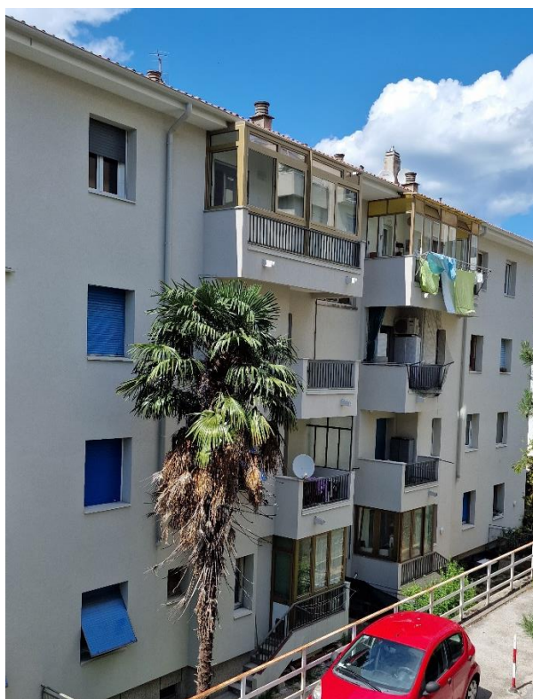
Foto n. 3 – Facciata tergale dell'edificio
