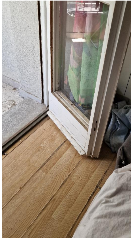
Foto n.19 – Stanza – vista di dettaglio n.6
