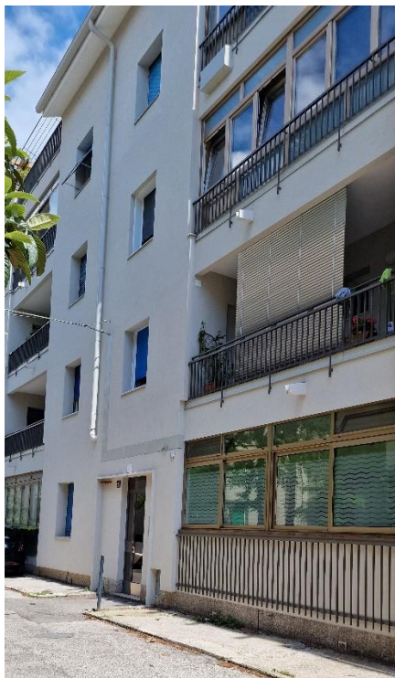
Foto n. 1 – Facciata d'ingresso dell'edificio – vista n.1
