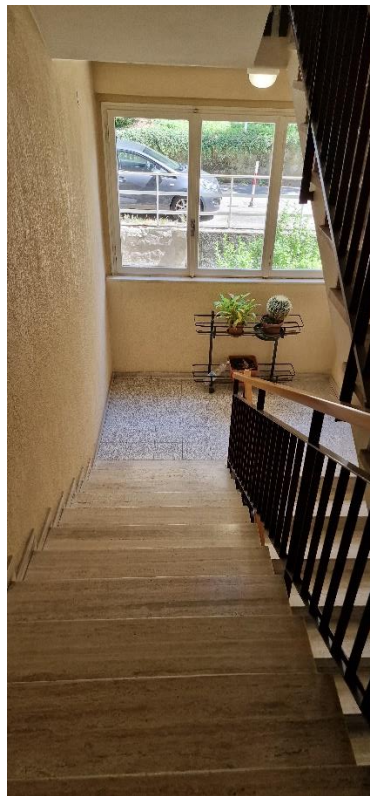
Foto n.12 – Vano scala dell'edificio – vista di dettaglio n.2
