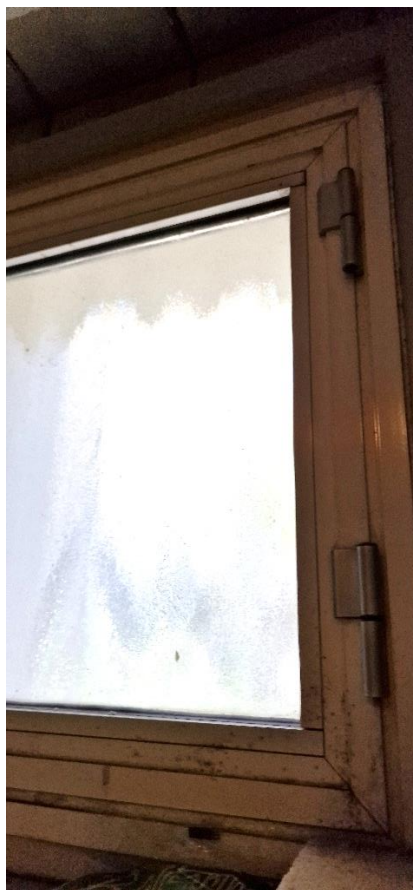
Foto n.33– Bagno wc– vista di dettaglio n.7
