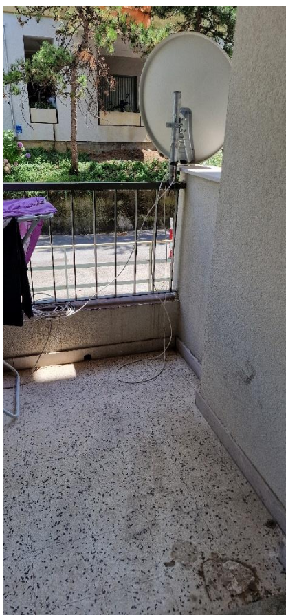
Foto n.37 – Poggiolo – vista di dettaglio n.1
