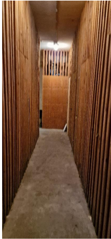
Foto n.41 – Vista piano terra adibito a cantine
