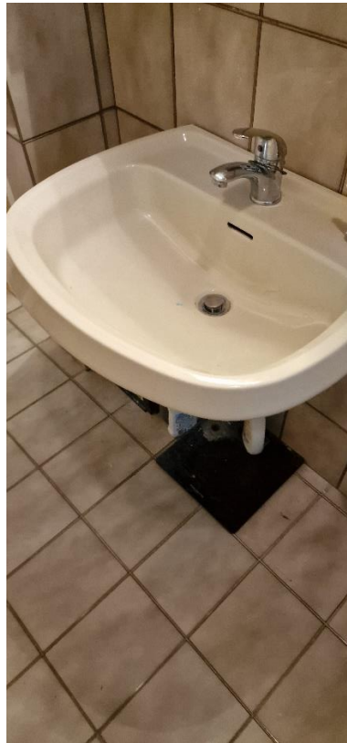
Foto n.30– Bagno wc– vista di dettaglio n.5
