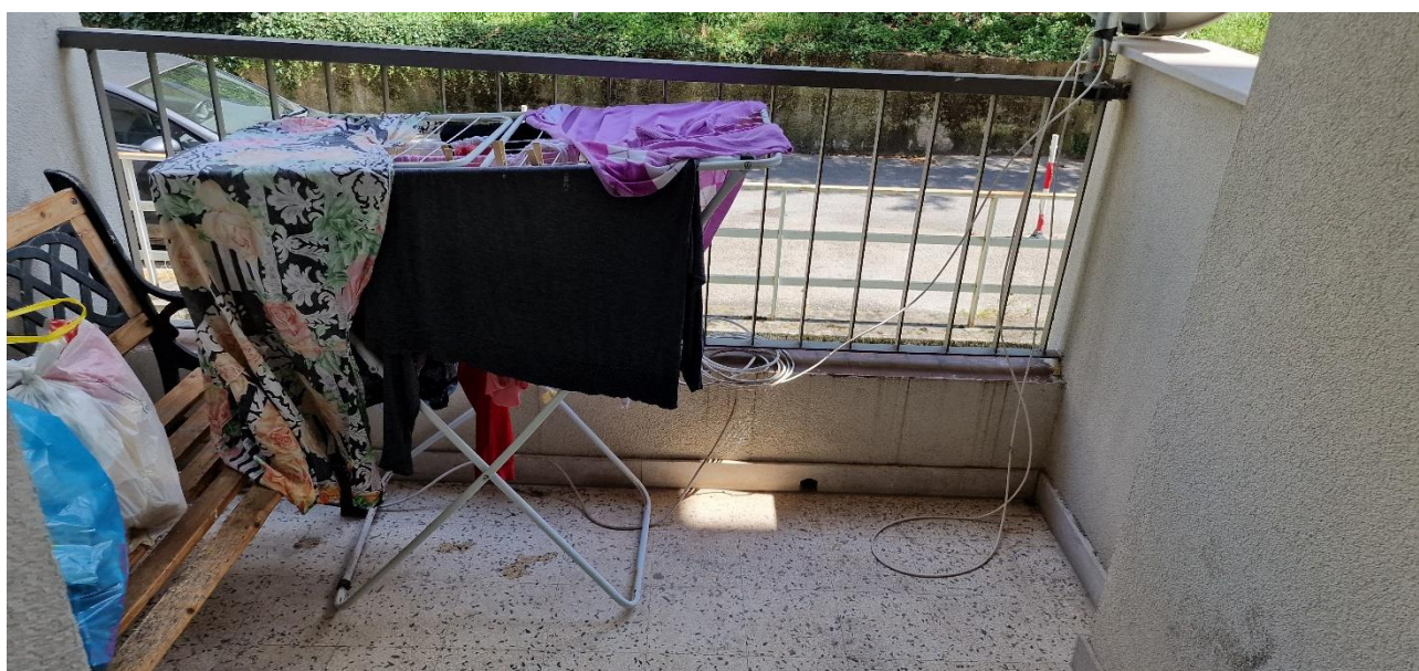
Foto n.38 – Poggiolo – vista di dettaglio n.2
