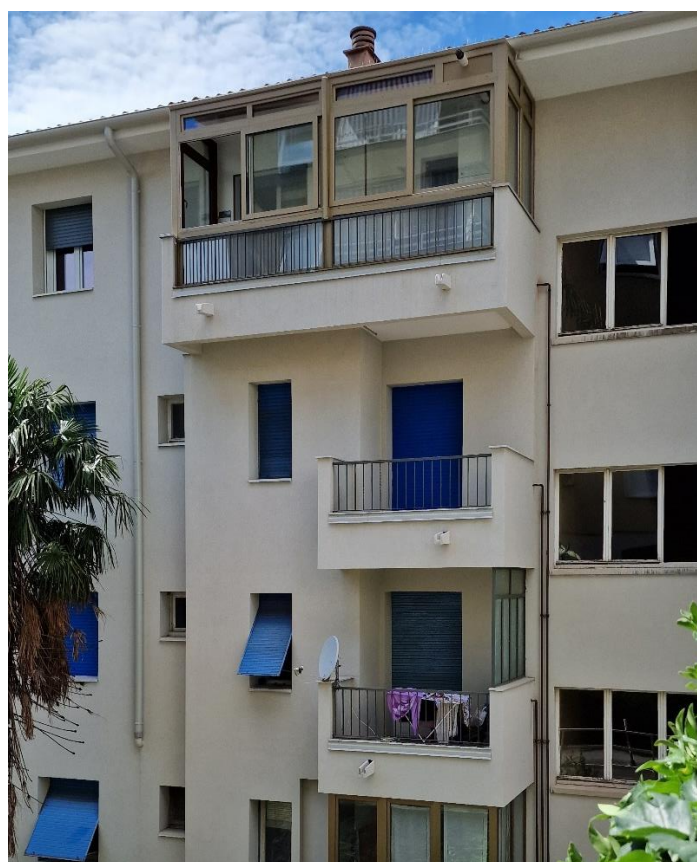
Foto n. 4 – Facciata tergale dell' edificio – vista di dettaglio verso l'alloggio
