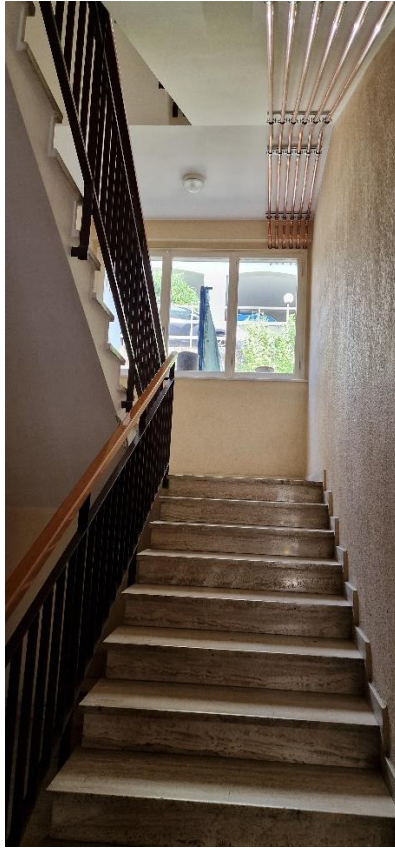
Foto n.11 – Vano scala dell'edificio – vista di dettaglio n.1
