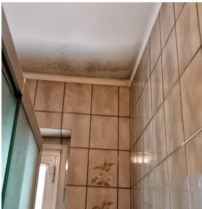
Foto n.32- Bagno wc- vista di dettaglio n.7
