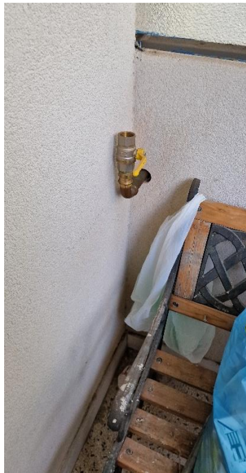
Foto n.40 – Poggiolo – vista di dettaglio n.4
