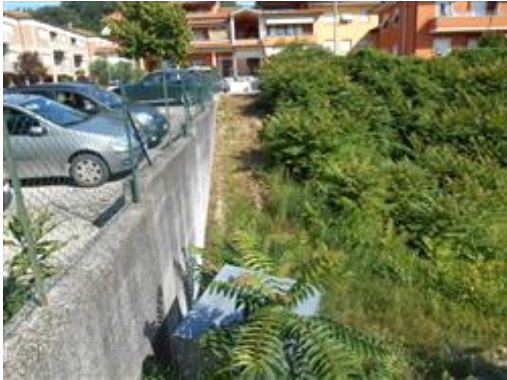
Vista della zona ingresso con rampa del LOTTO "A" (nel Piano di Lottizzazione)
