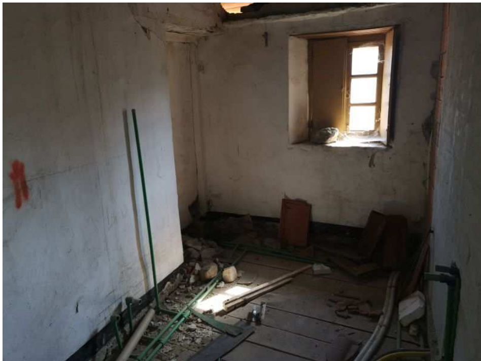
Foto 19 – Piano secondo, stato rustico
