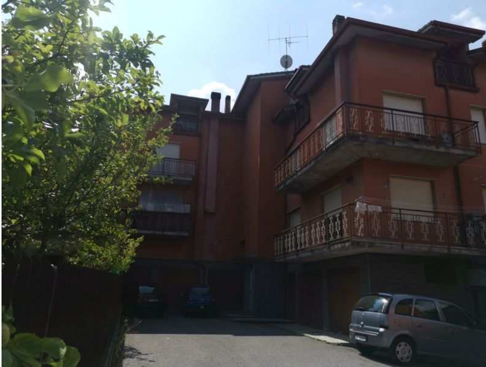
Foto 23 – Vista esterni dell'edificio
