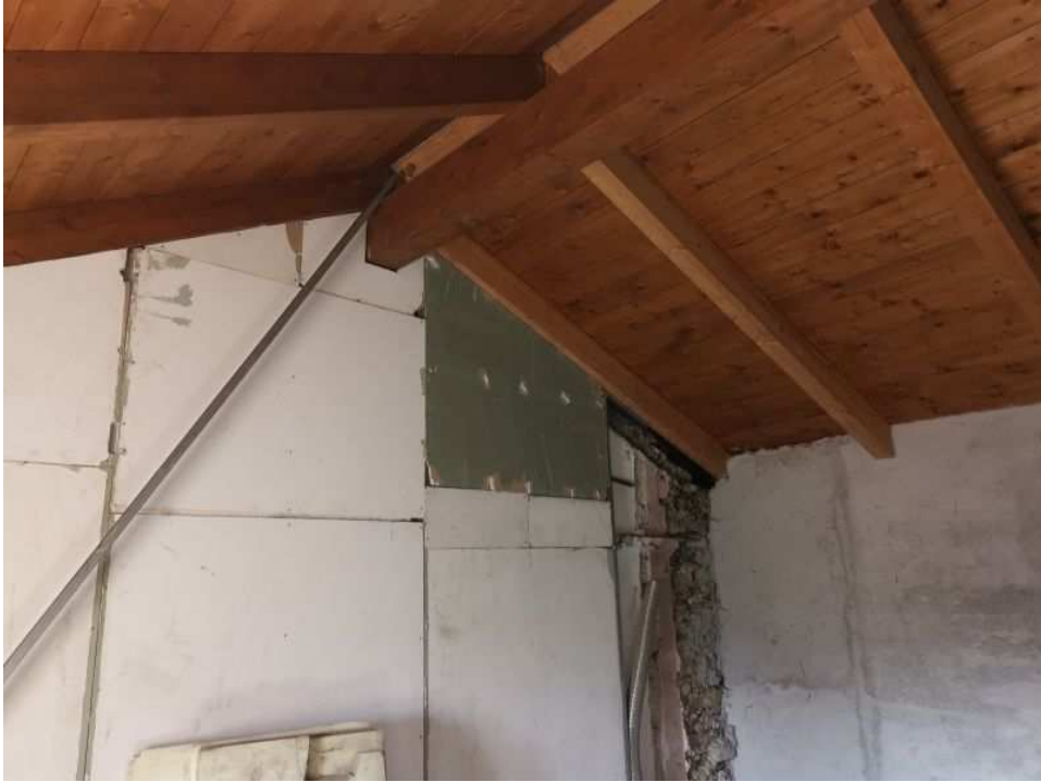
Foto 20 – Piano secondo, stato rustico
