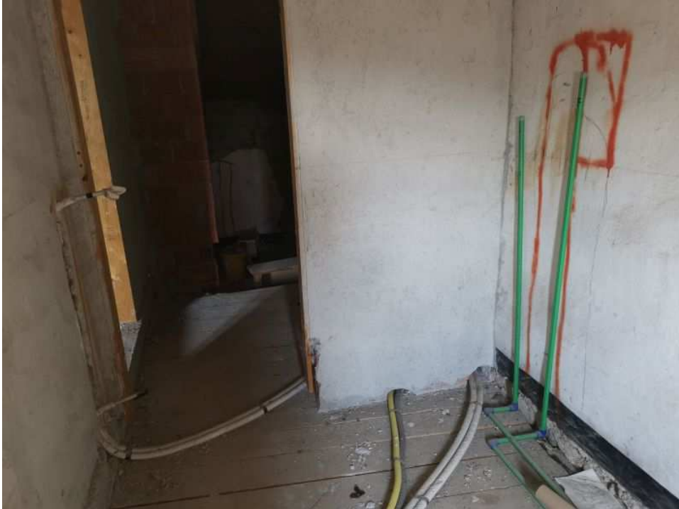
Foto 18 – Piano secondo, stato rustico
