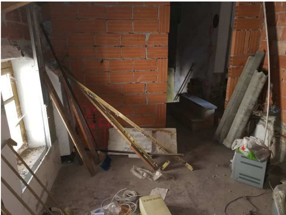
Foto 15 – Piano secondo, stato rustico
