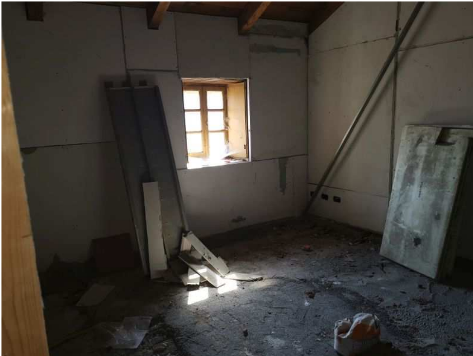
Foto 21 – Piano secondo, stato rustico
