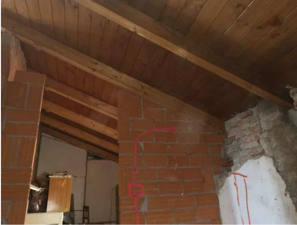
Foto 16 – Piano secondo, stato rustico
