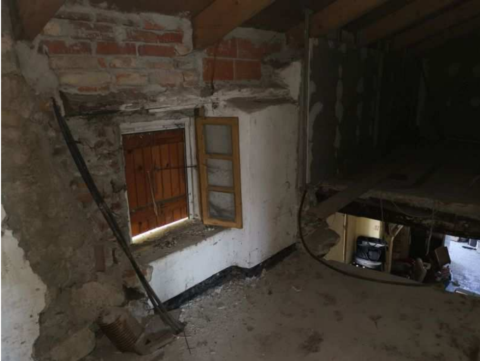
Foto 14 – Piano secondo, stato rustico
