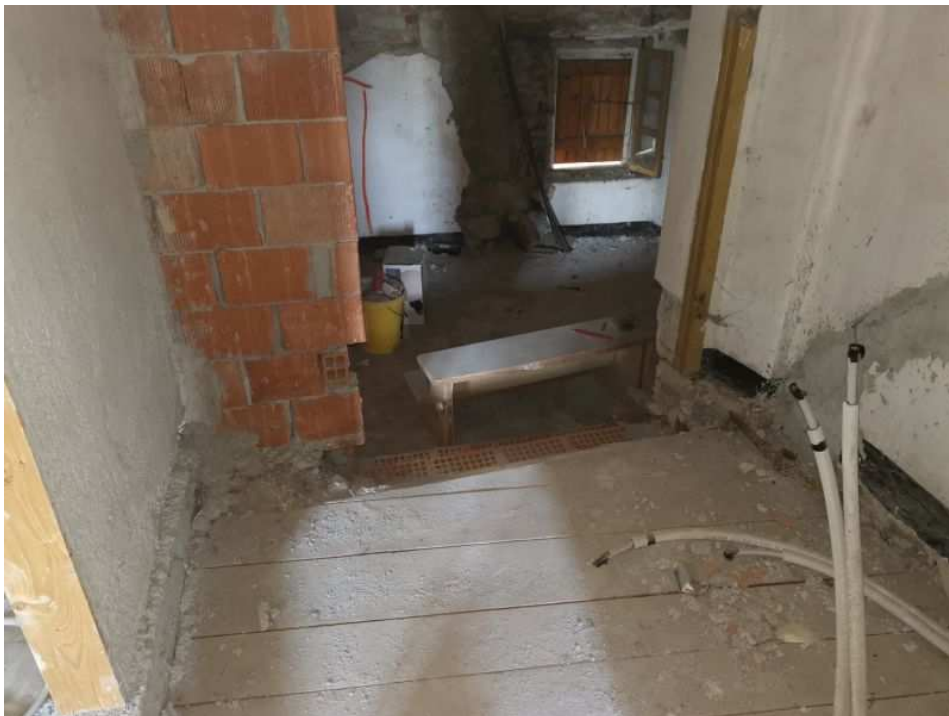
Foto 17 – Piano secondo, stato rustico
