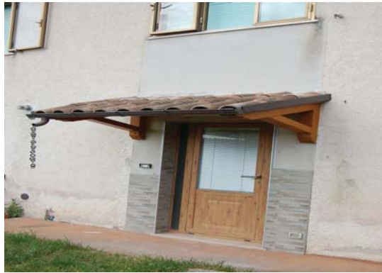
FOTO 9 – INGRESSO AL PIANO TERRA RETRO FABBRICATO
