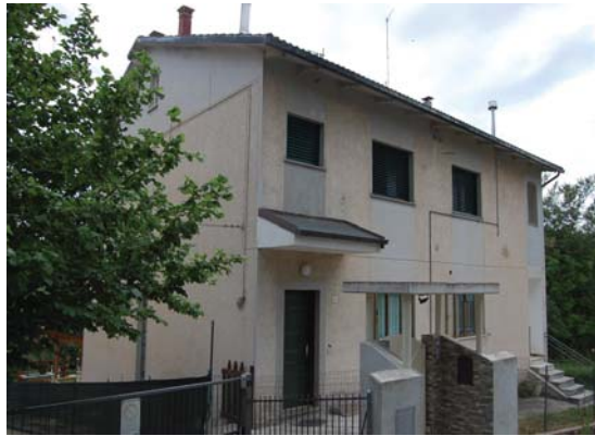
FOTO 1 - FRONTE E LATO SINISTRO FABBRICATO
