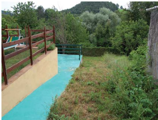
FOTO 7 – SCOPERTO RETRO FABBRICATO
