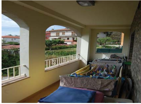
FOTO 25 – LOGGIA PIANO TERZO - SOFFITTA
