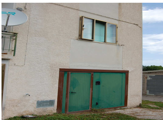
FOTO 3 – INGRESSO LOCALE AL PIANO TERRA MURATO DALL'INTERNO
