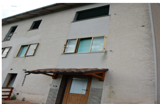
FOTO 4 – PENSILINA INGRESSO P. S1 RETRO FABBRICATO
