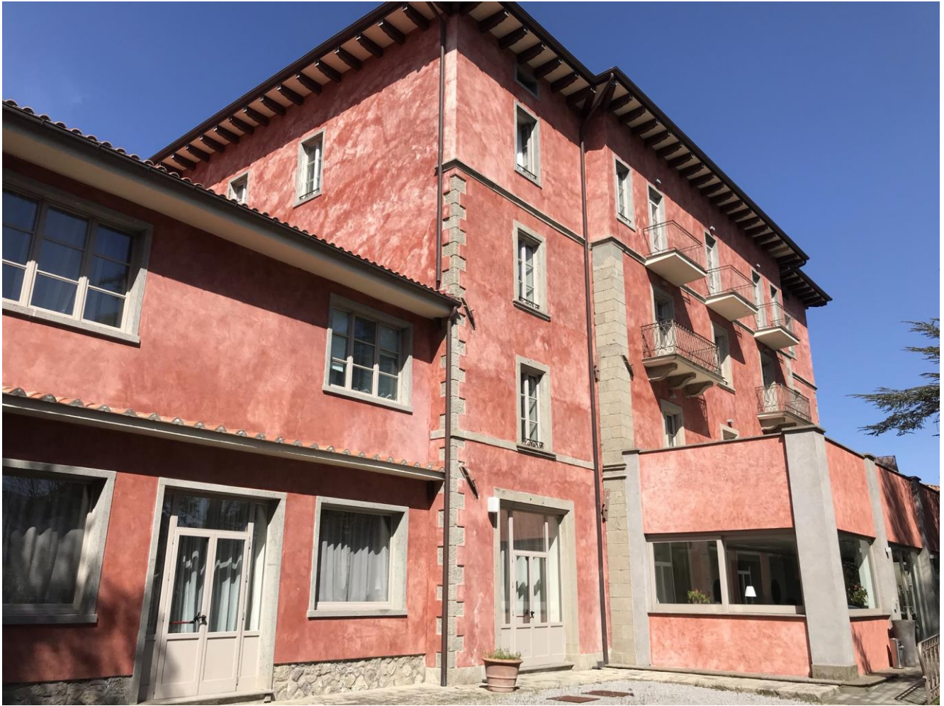
Vista lato sud est fabbricato
