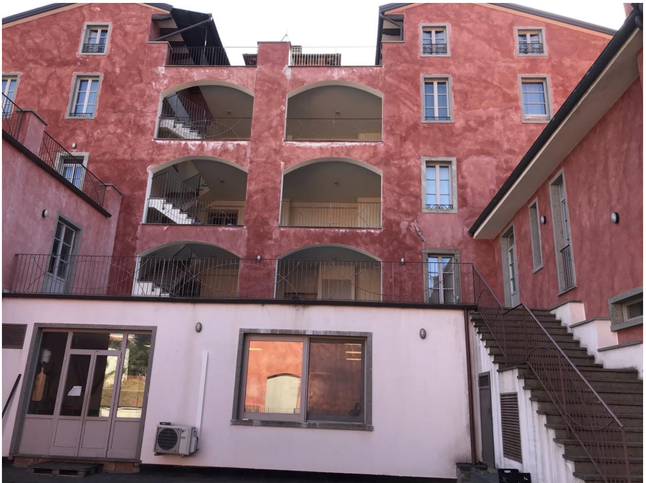
Vista lato ovest fabbricato
