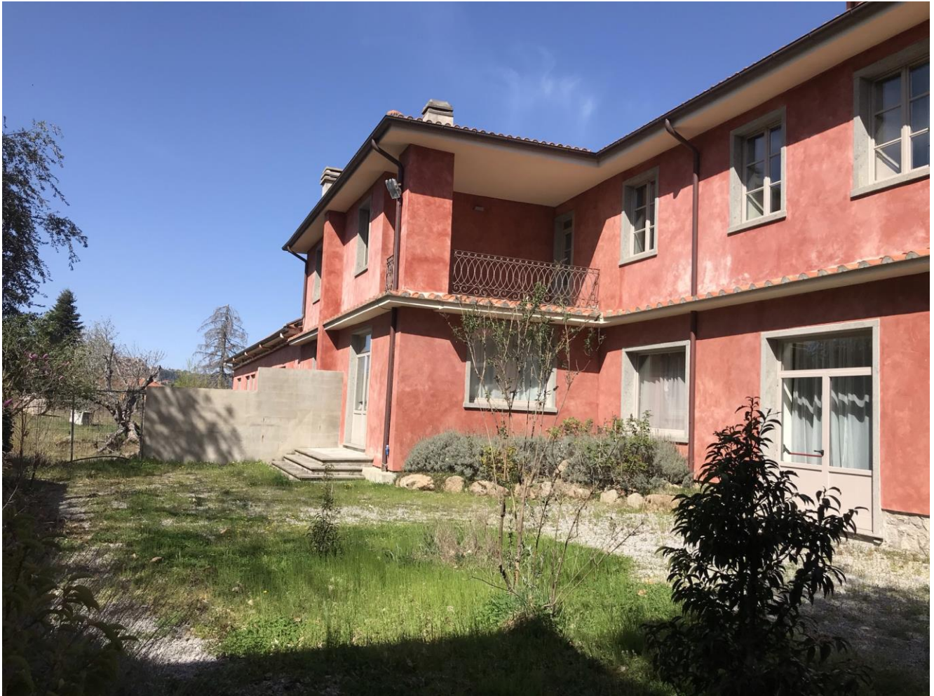
Vista lato sud fabbricato
