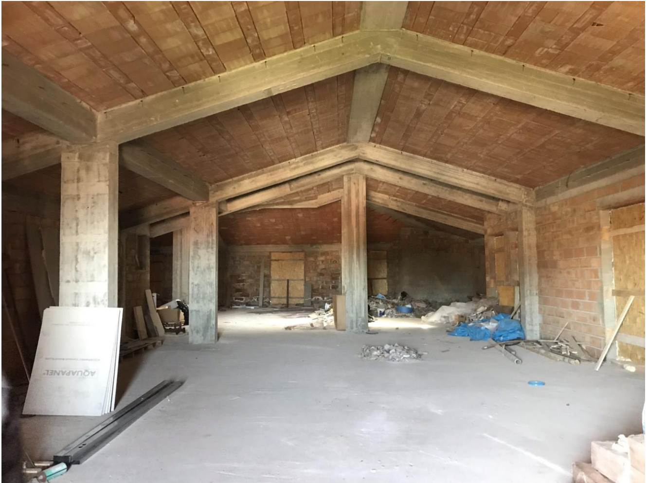
Area di cantiere al piano primo: vista interna
