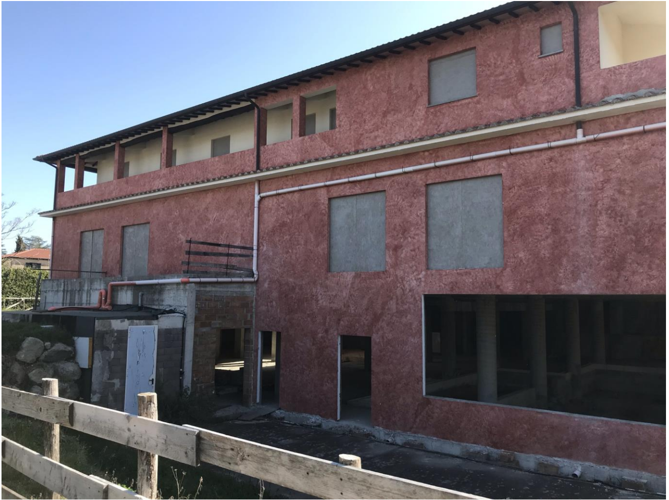
Vista del volume in ampliamento non terminato e scorcio piano interrato
