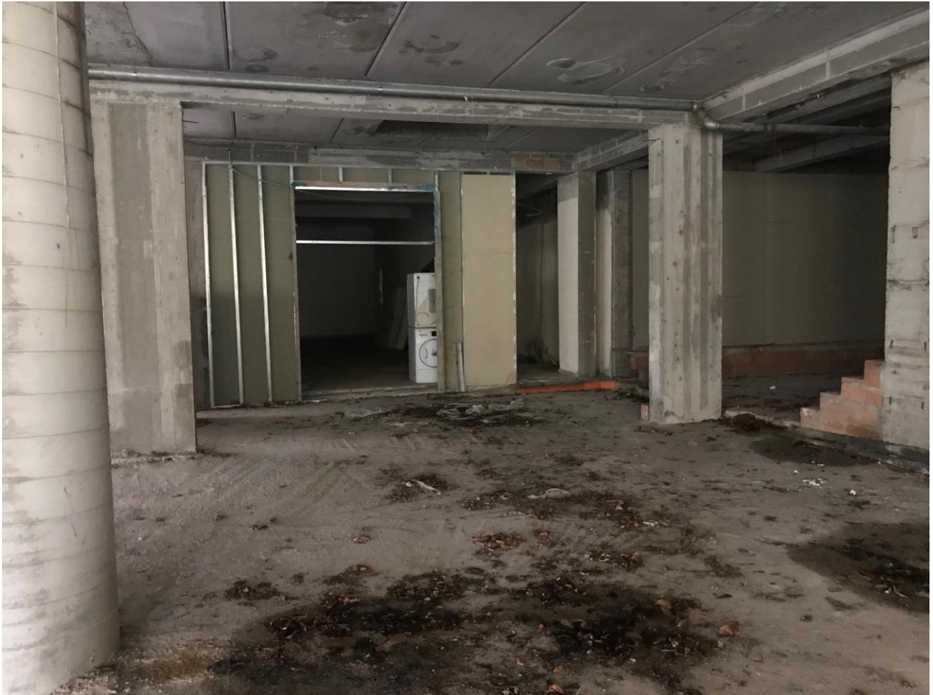
Area di cantiere al piano interrato: vista magazzino incompleto
