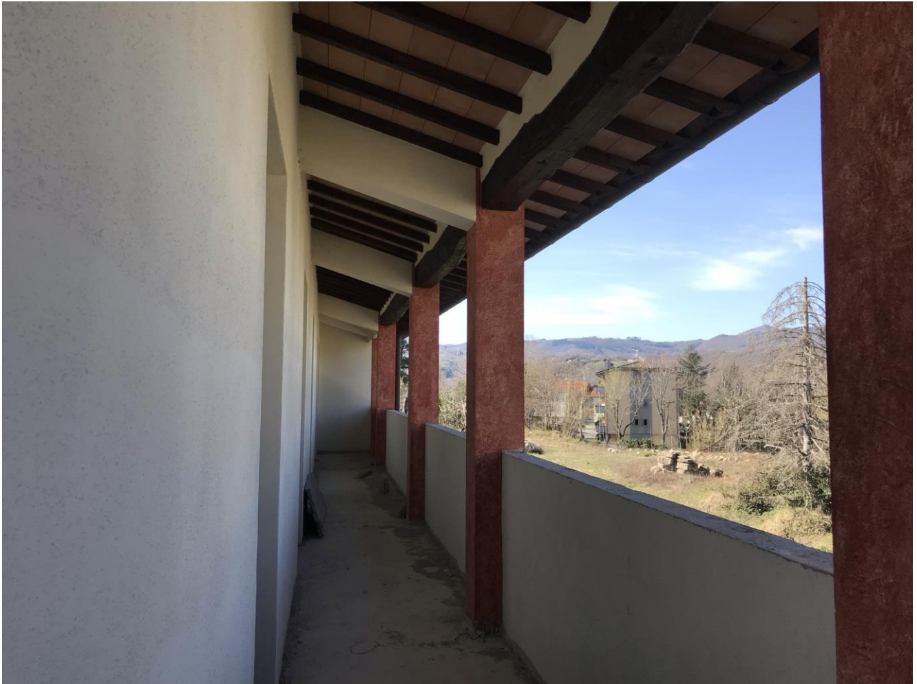
Area di cantiere al piano primo: vista terrazze
