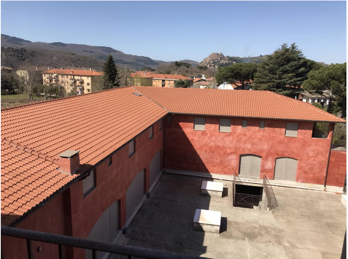
Vista del volume in ampliamento non terminato dalla loggia esterna
