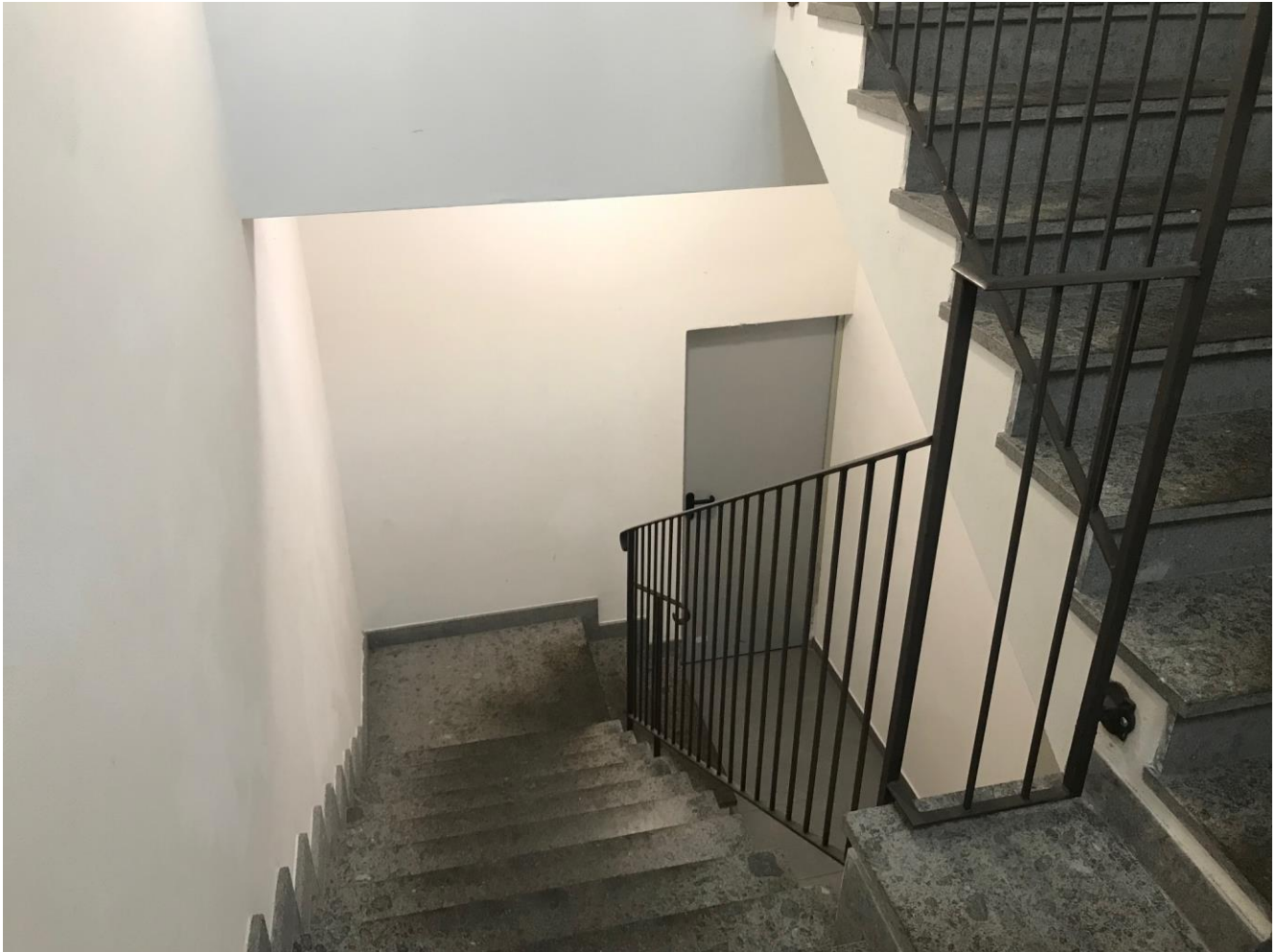
Rampa scale di collegamento con piano interrato
