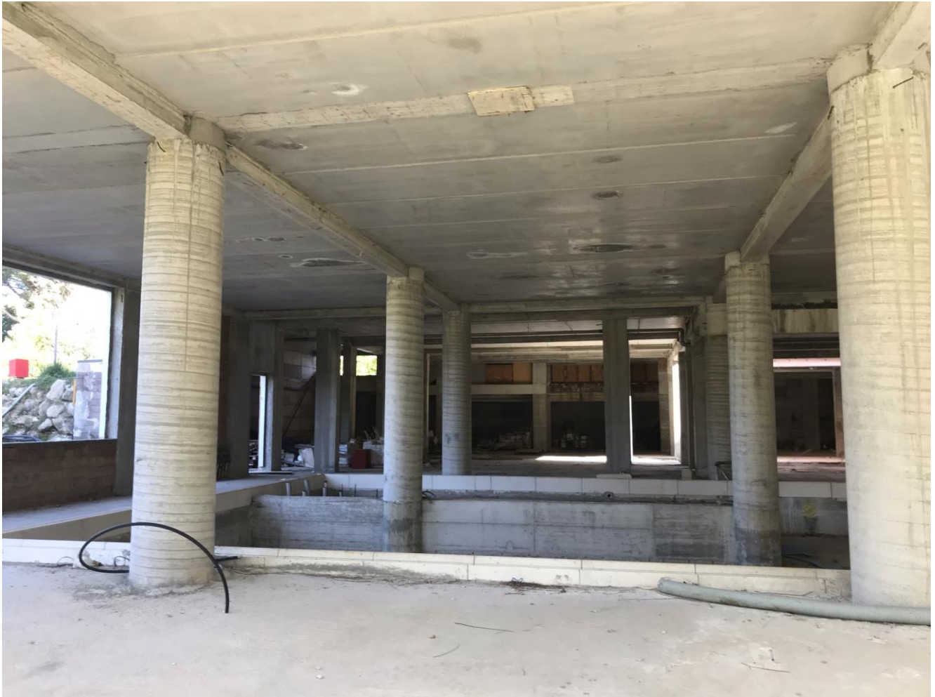
Area di cantiere al piano interrato: vista piscina
