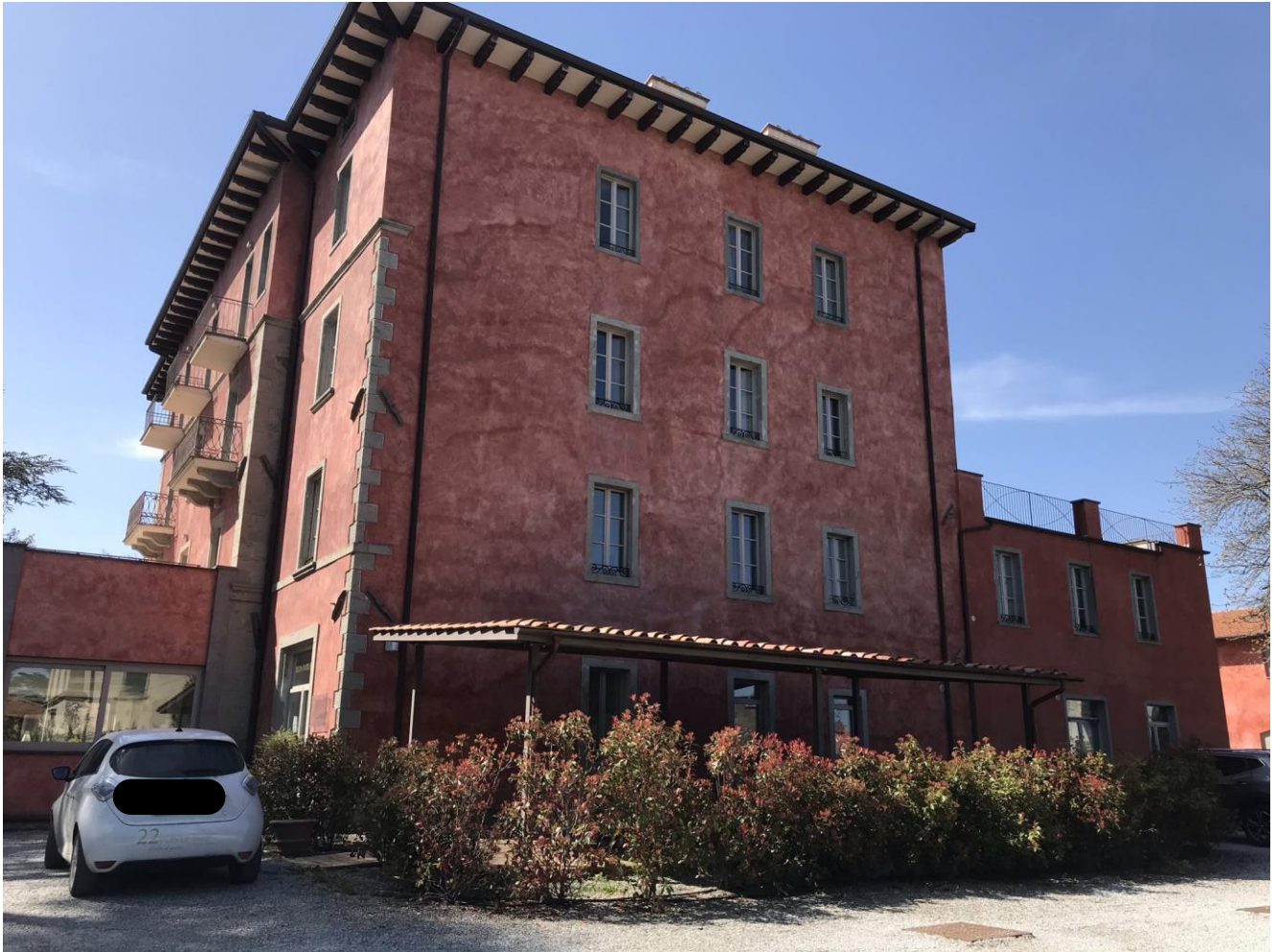
Vista lato nord fabbricato
