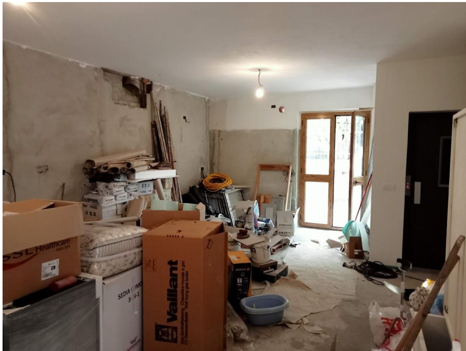
Foto n° 6 di 36 – Piano Terra (Vano cucina stato grezzo)
