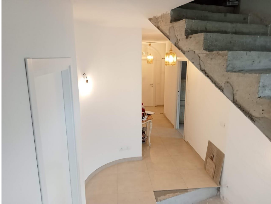
Foto n° 7 di 36 – Piano Primo
