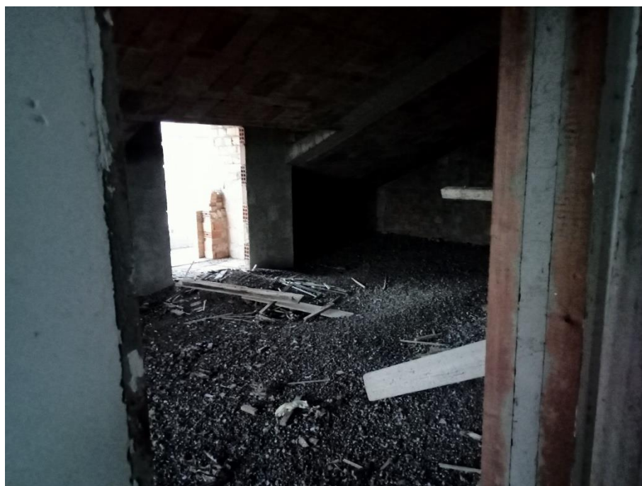
Foto n° 30 di 36 (Locale sottotetto)
