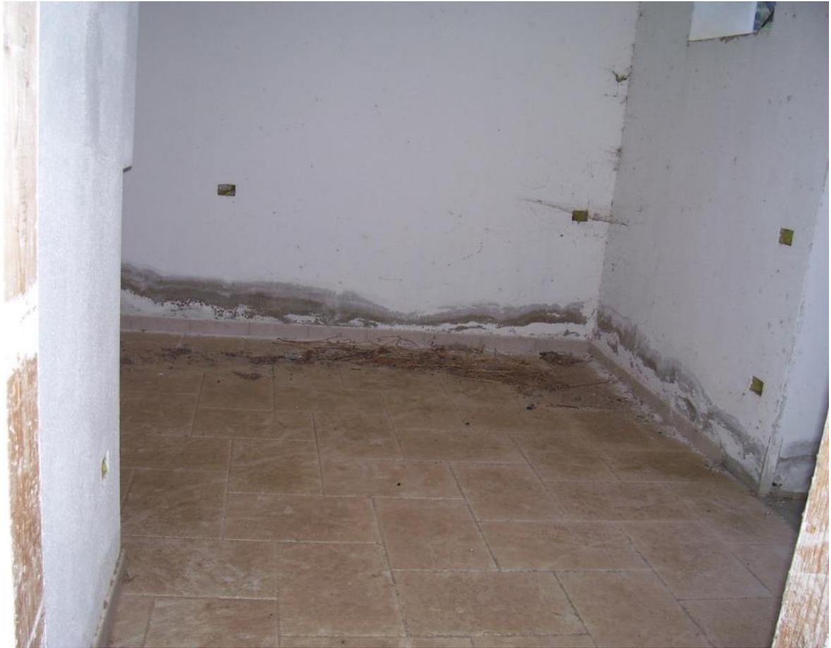
Foto 35. Infiltrazioni di umidità nei seminterrati
