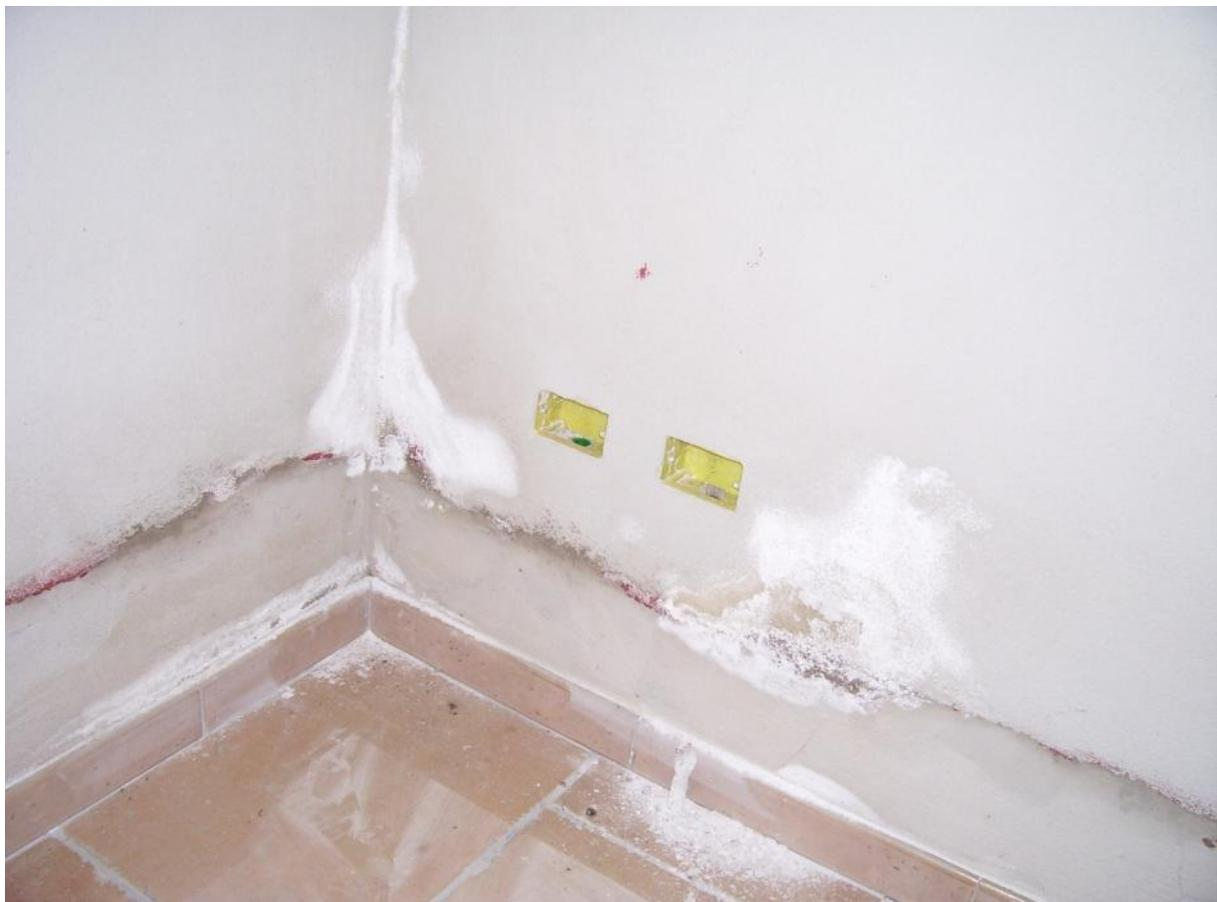
Foto 36. Infiltrazioni di umidità nei seminterrati
