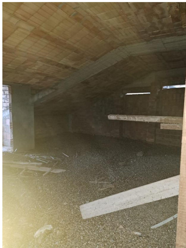
Foto n° 10 di 17 LOTTO n° 6 – Unità in corso di definizione (Locale sottotetto)
