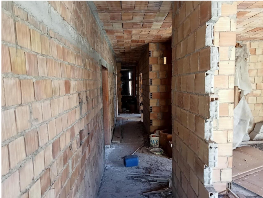
Foto n° 9 di 17 LOTTO n° 5 – Unità in corso di definizione
