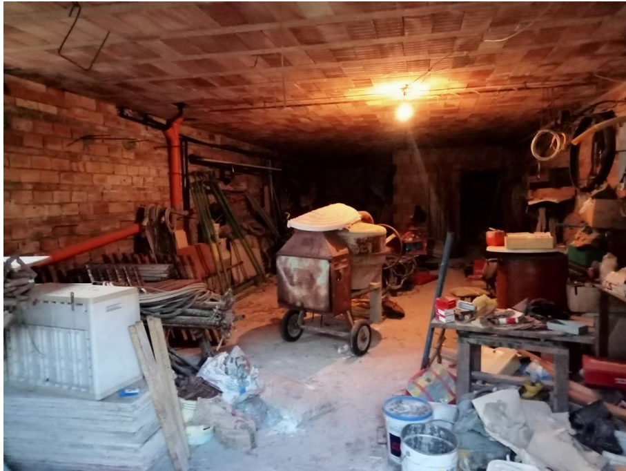
Foto n° 13 di 17 LOTTO n° 7 – Autorimessa
