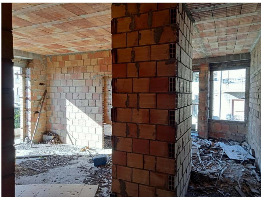
Foto n° 8 di 17 LOTTO n° 5 – Unità in corso di definizione
