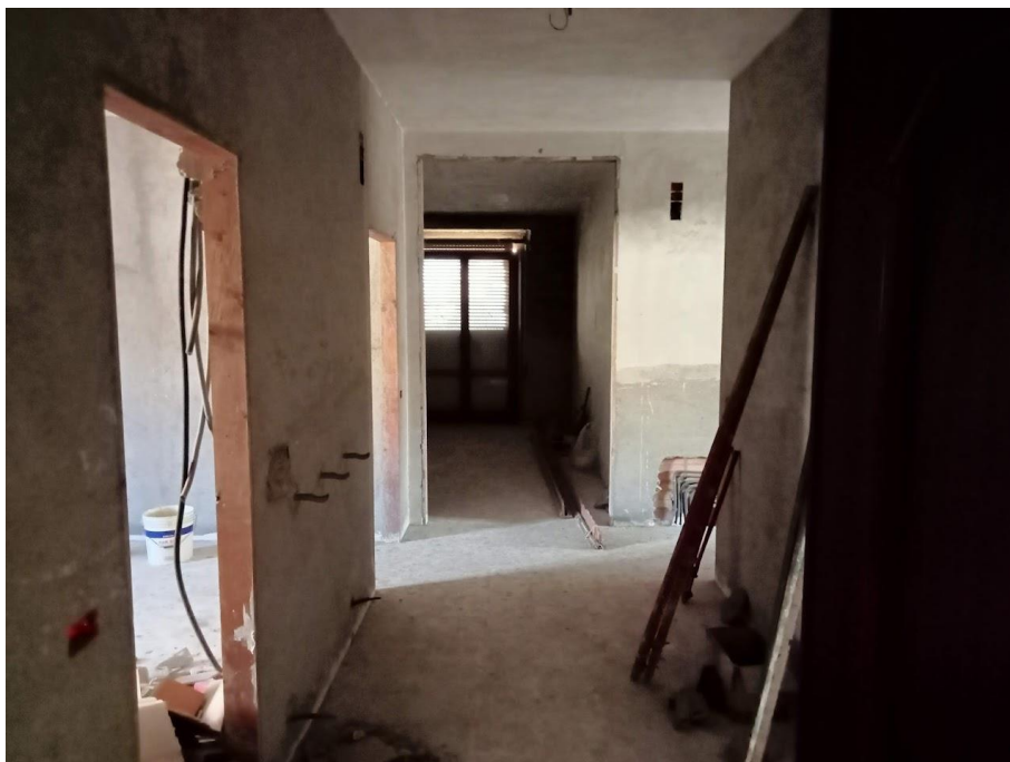
Foto n° 7 di 17 LOTTO n° 4 – Unità in corso di definizione
