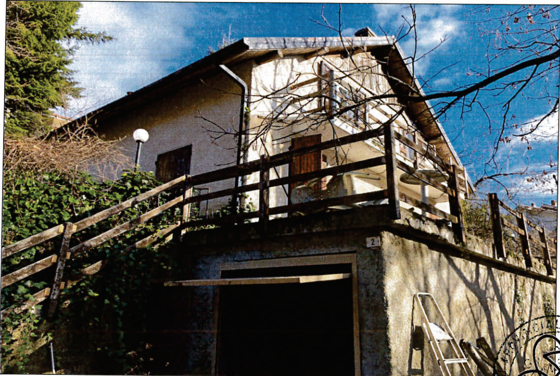
FOTO N° 1: Vista esterna fabbricato.
