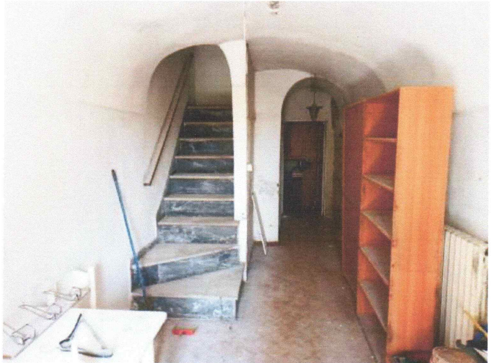
Foto n° 4 di 6 – Vista interna (Piano terra)
