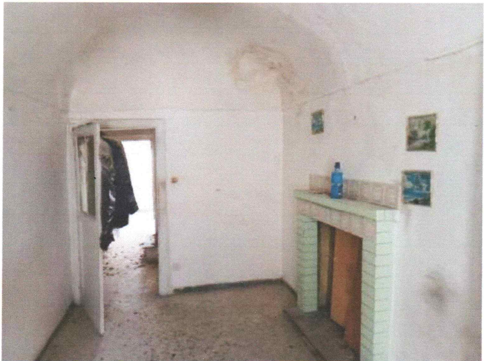
Foto n° 5 di 6 – Vista interna (Piano primo)
