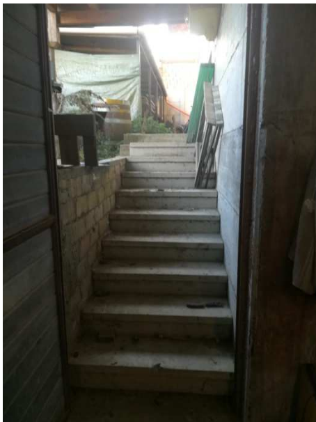
Fronte a sud-est
