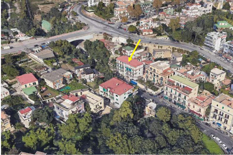
Fotografia 3 – Inquadramento territoriale lato Sud.
