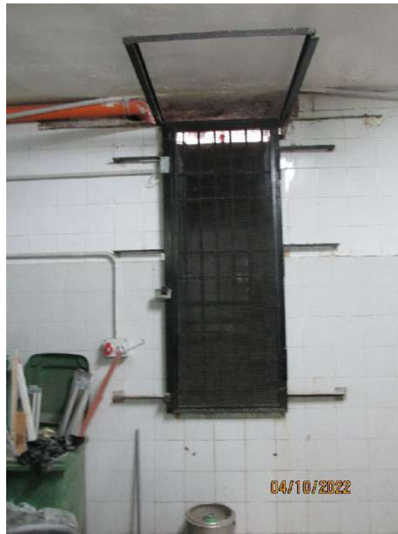
Fotografia 31 – Locale 2/a Sub 102 : Una delle tre lustriere, è stata trasformata in apertura per il carico/scarico di materiali, mediante intervento edilizio che ha interessato sia la parete perimetrale del locale mediante il taglio verticale di parte di essa, sia l'estradosso del marciapiede mediante la realizzazione di una botola.
