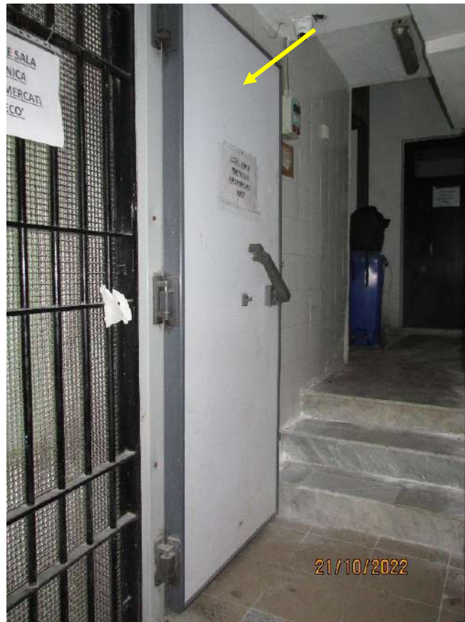
Fotografia 20 – Locale 1 Sub 101: vi si accede tramite una porta frigo posta sul piccolo ballatoio comune del piano seminterrato alla destra di chi scende le scale.
