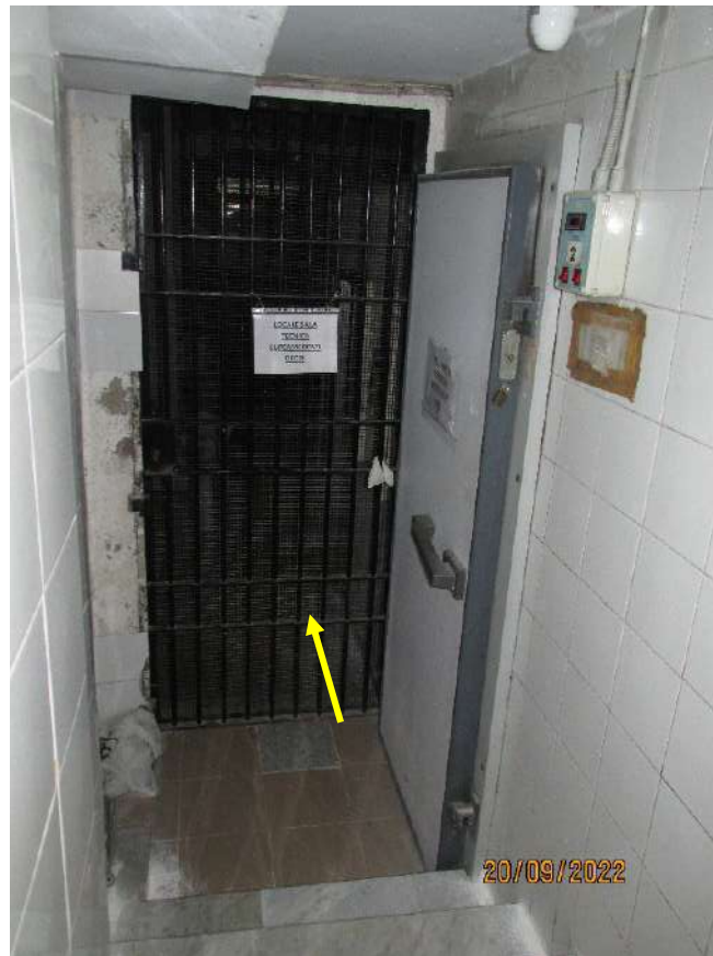
Fotografia 23 – Locale 2/a Sub 102 : vi si accede tramite un serramento in ferro posto di fronte al piccolo ballatoio del piano seminterrato alla destra di chi scende le scale.
