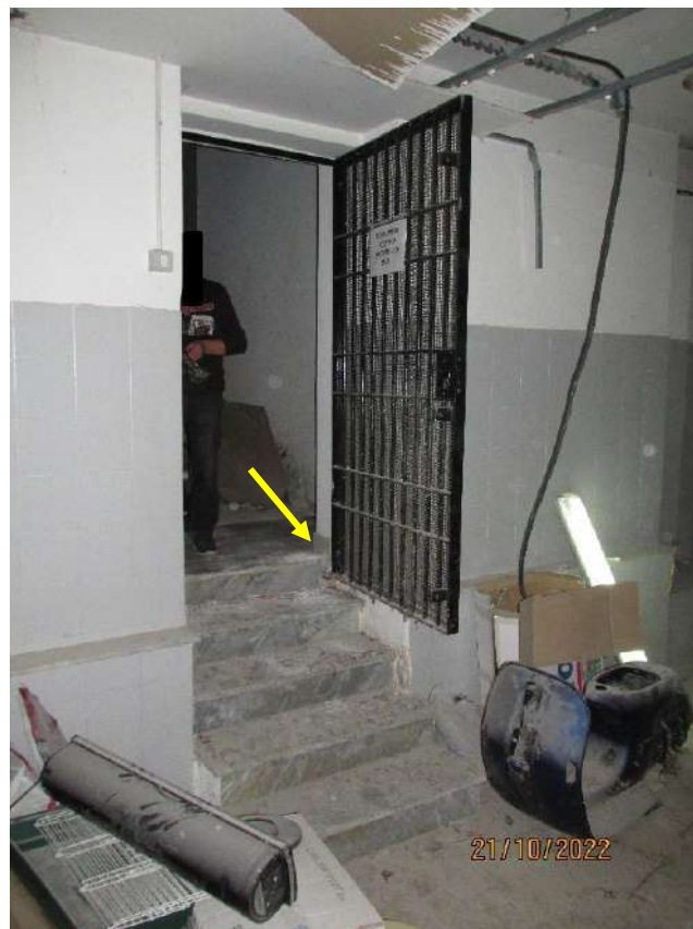
Fotografia 35 – Locale 2/b Sub 102: vi si accede attraverso una porta in ferro posta frontalmente a chi giunge sul ballatoio del piano seminterrato mediante un piccolo rampante di scala.
