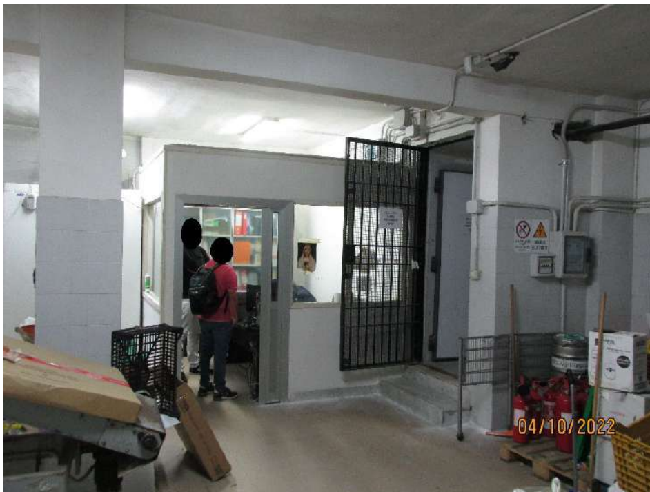
Fotografia 24 – Locale 2/a Sub 102 : Il locale occupa una superficie utile calpestabile pari a mq. 106,96 e un'altezza interna dal piano di calpestio pari a ml. 3,10.
