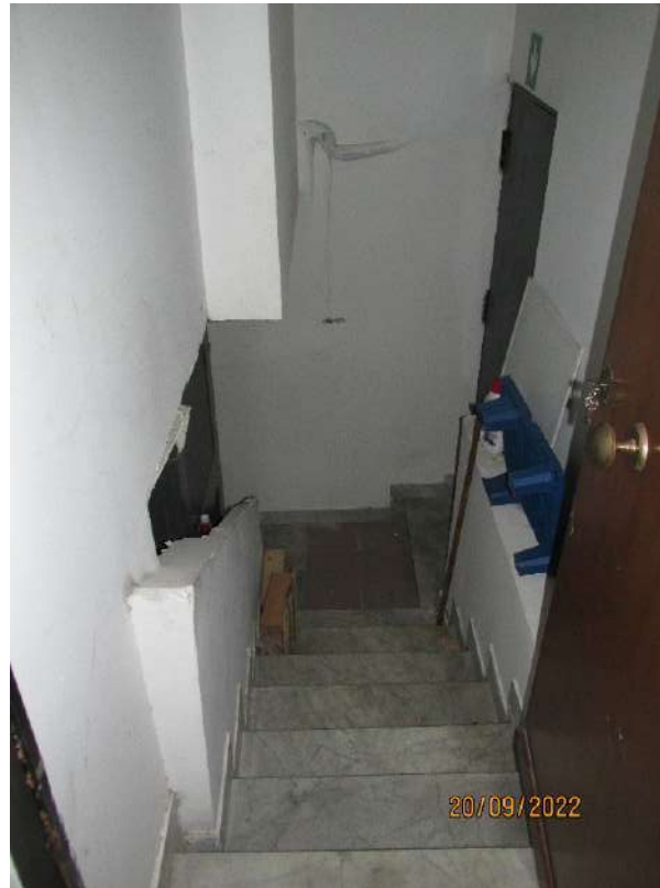
Fotografia 16 – I rampanti di scala che conduce al piano interrato, presentano le pedate dei gradini rivestite con lastre in marmo bianco con venature grigio, intervallate da ballatoi pavimentato con piastrelle in ceramica smaltata.
