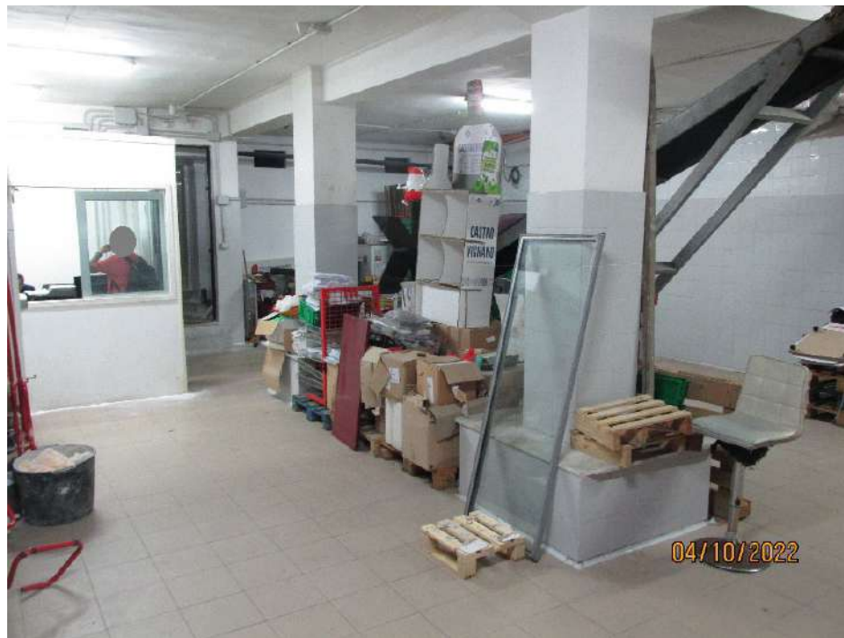
Fotografia 28 – Locale 2/a Sub 102: I due pilastri a vista sono rivestiti con piastrelle in ceramica smaltata nella parte inferiore, mentre nella parte superiore sono rivestiti con intonaci ordinari a finitura liscia e tinteggiata con pittura lavabile.
