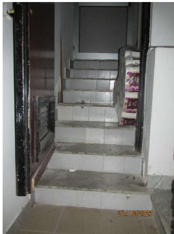
Fotografia 19 – Il dislivello tra il piano interrato e il confinante locale a piano terra, è colmato da un rampante di scala che sfruttando la parete perimetrale del fabbricato si collega al pianerottolo del rampante di scala che dall'androne del fabbricato porta al disimpegno comune del piano interrato.
