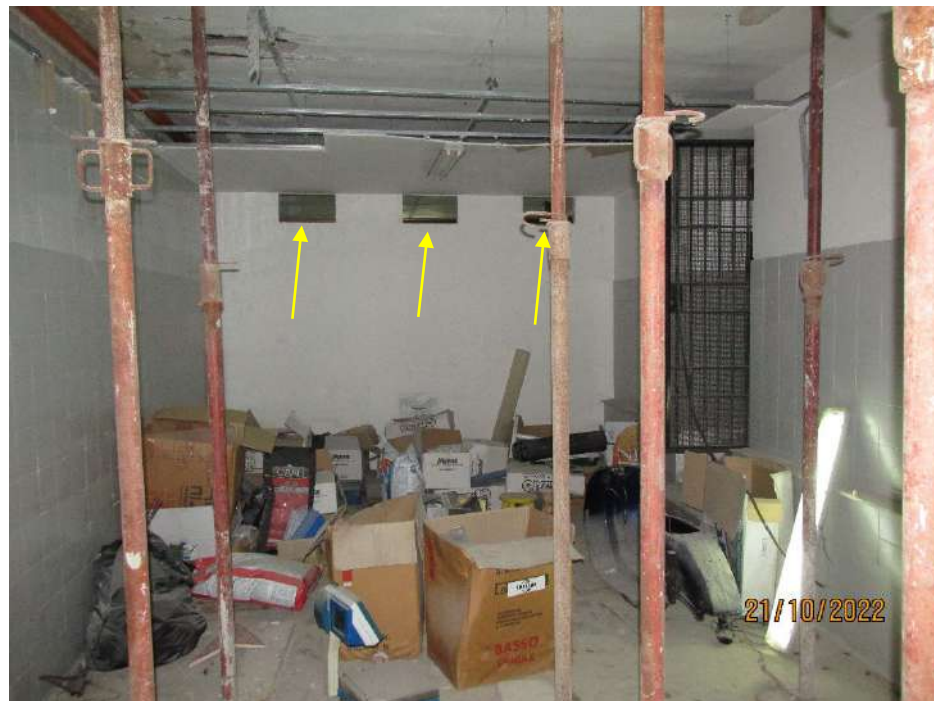
Fotografia 39 – Locale 2/b Sub 102 : L'ambiente non presenta aperture e/o luci verso l'esterno, ma esistono delle piccole aperture poste nella parte alta della parete di confine con il "Locale 2/a Sub 102" che consentono un minimo di ricambio dell'aria al locale.
