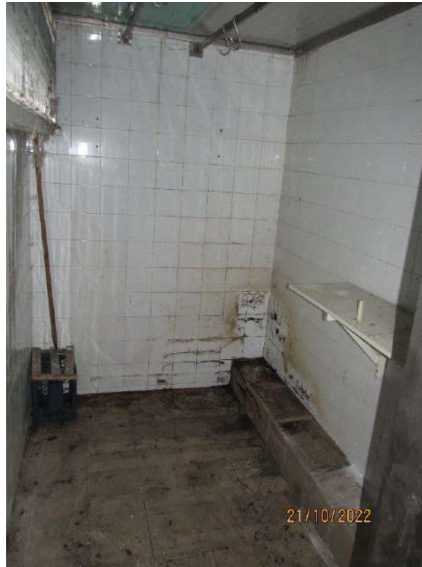
Fotografia 21 – Locale 1 Sub 101: Il locale attualmente è destinato a cella frigorifero, l una superficie calpestabile utile netta pari a mq. 5,60 e un'altezza d piano di calpestio pari a ml. 2,80. La pavimentazione e le pareti risultano interamente rivestite con piastrelle di ceramica smaltate mentre il soffitto risulta costituito da pannelli coibentati.
