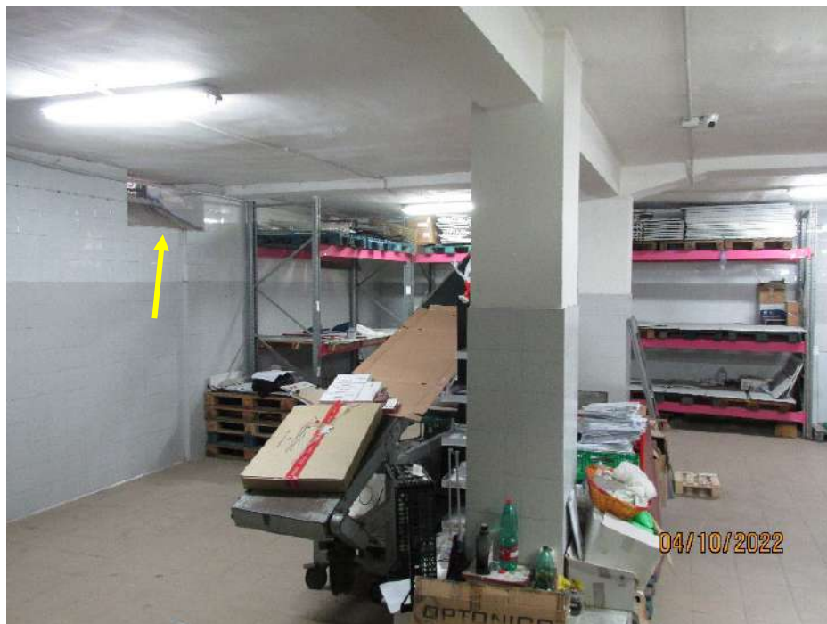
Fotografia 30 – Locale 2/a Sub 102 : Il locale deposito, è dotato di tre piccoli lustriere, poste nella parte alta della parete perimetrale esposta a sud-ovest verso il marciapiede di Via Discesa Coroglio.
