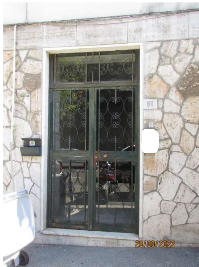
Fotografia 10 – All'interno del fabbricato vi si accede dal civico n. 80 di Via Discesa Coroglio tramite un varco pedonale protetto da un serramento in ferro con vetrate a due ante, munito esternamente di impianto citofonico collegato agli appartamenti.
