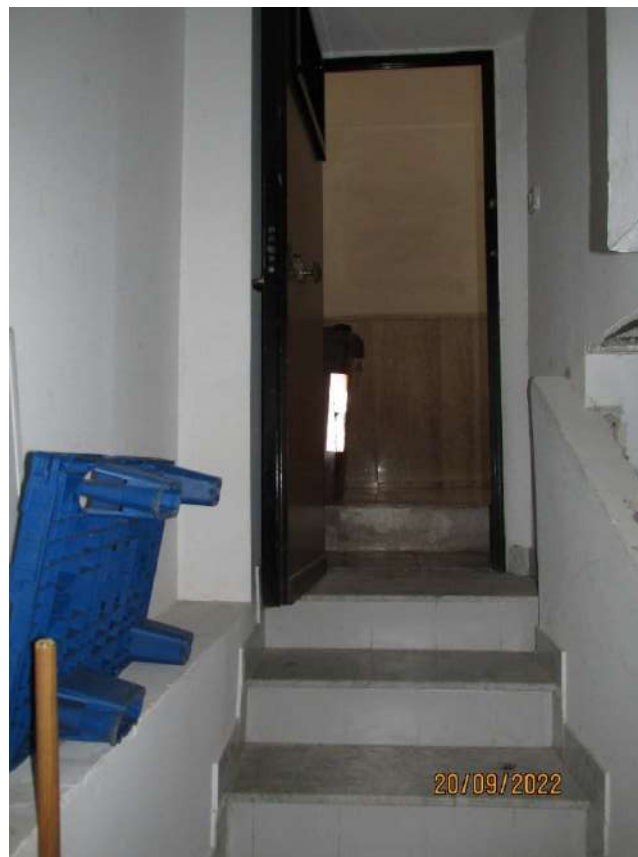
Fotografia 15 – L’accesso al piano interrato del fabbricato, avviene a mezzo di due rampanti di scala intervallate da un pianerottolo, l’intero interrato è costituito dai soli due locali deposito staggiati e dal un ulteriore locale di proprietà di terzi contraddistinto catastalmente con sub 4 destinato a cantinola.
