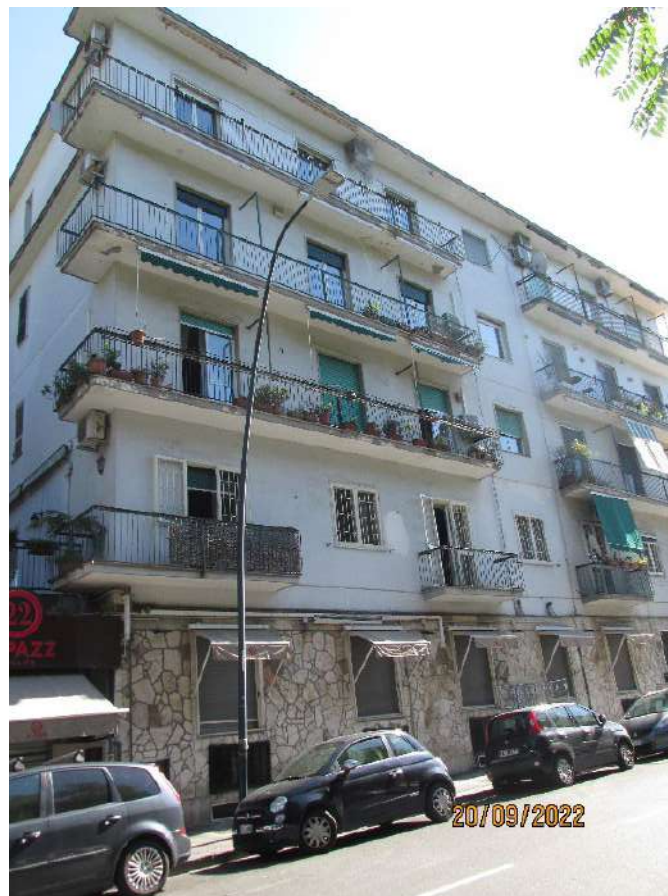
Fotografia 7 – Le strutture portanti dell'edificio sono costituite da un reticolato di pilastri e travi in cemento armato con solai piani in laterocemento.
