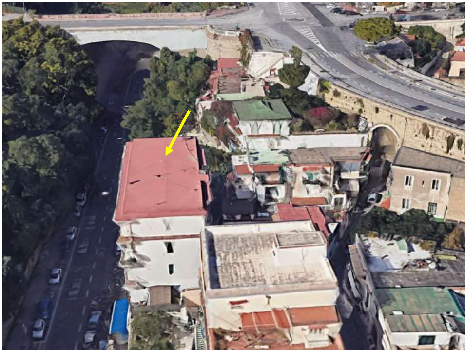
Fotografia 9 – La copertura del fabbricato è costituita da un terrazzo piano, rivestito con guaina bituminosa.
