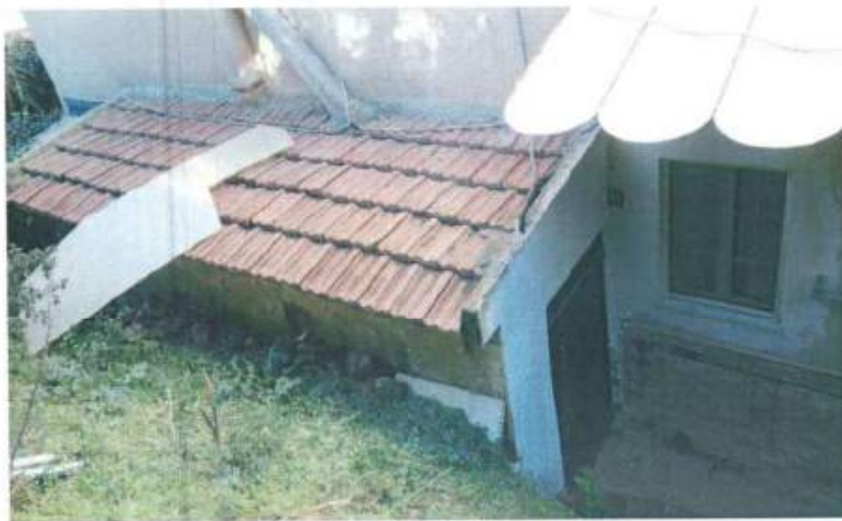
FOTO B17 (vista retro Abitazione - Locale Tecnico)
