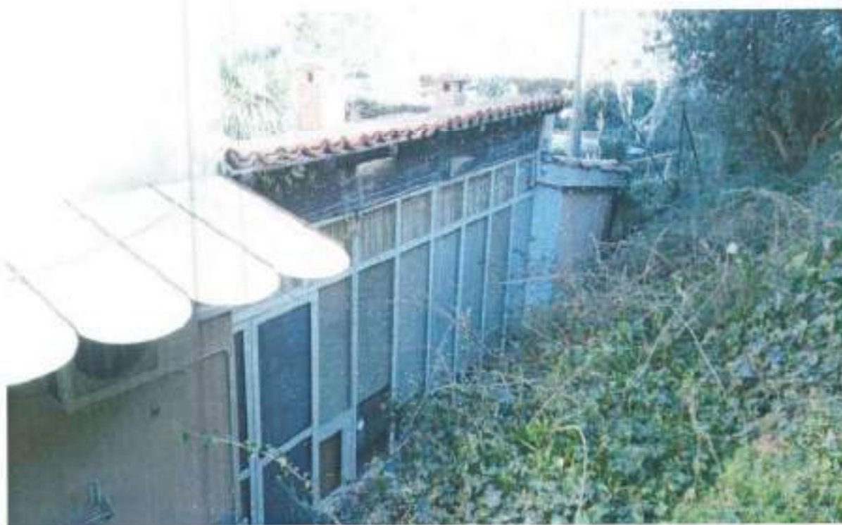
FOTO B18 (vista retro Abitazione - Veranda)
