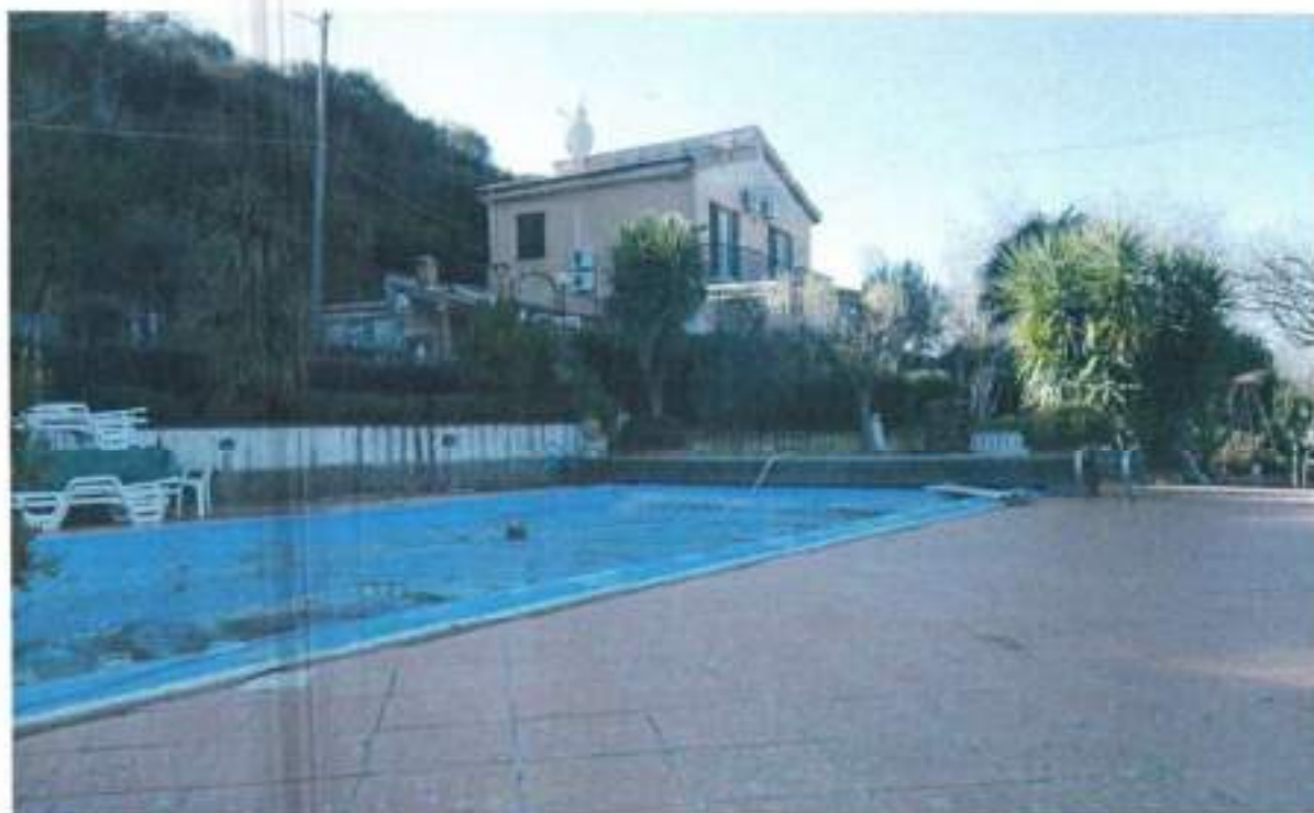
FOTO B9 (Area piscina e vista Abitazione)
