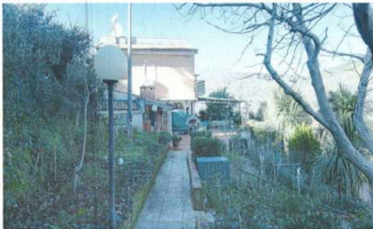
FOTO B14 (vista laterale Abitazione)
