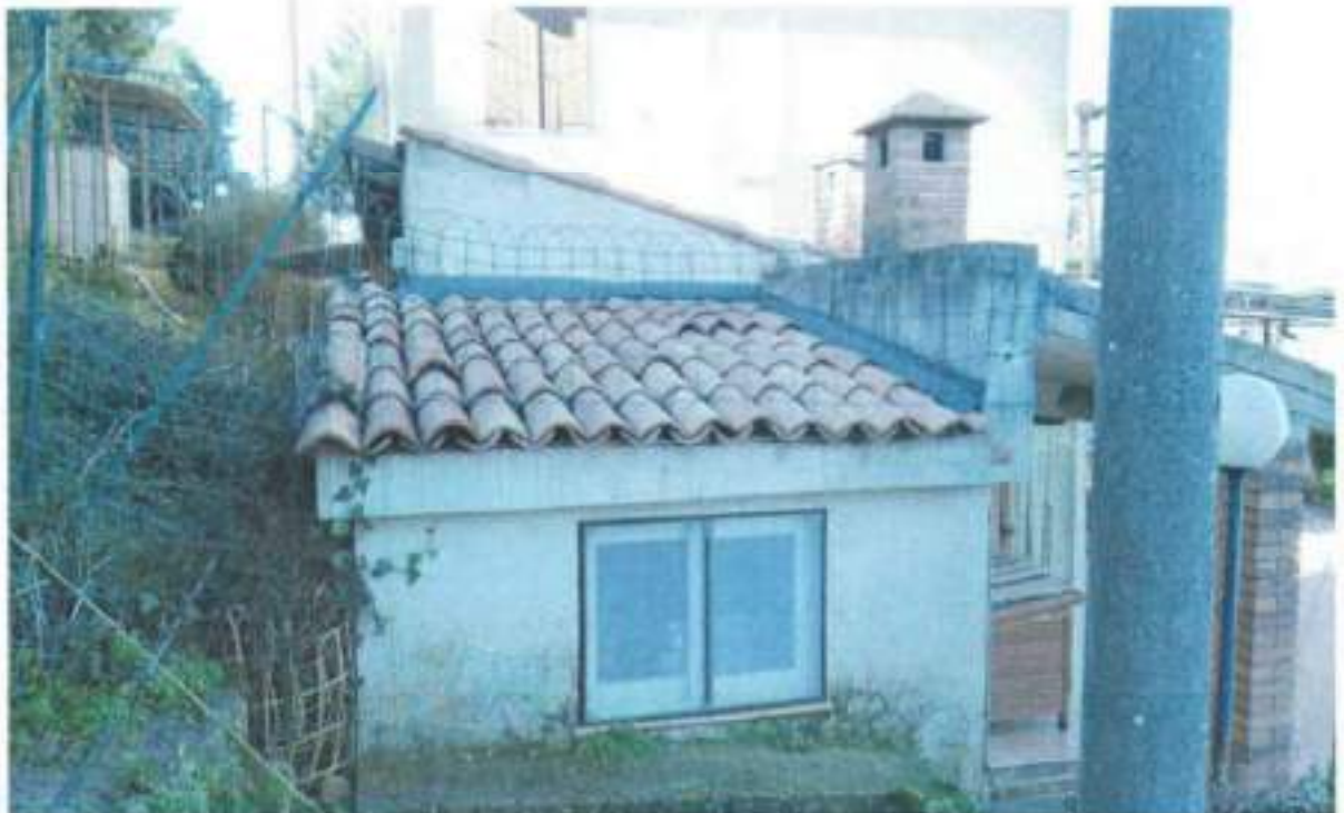
FOTO B16 (vista laterale - Deposito)
