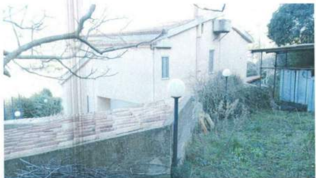
FOTO B8 (Zona retro Garage e vista posteriore Abitazione)
