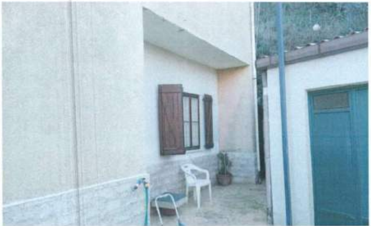
FOTO B15 (vista laterale Abitazione-Garage)
