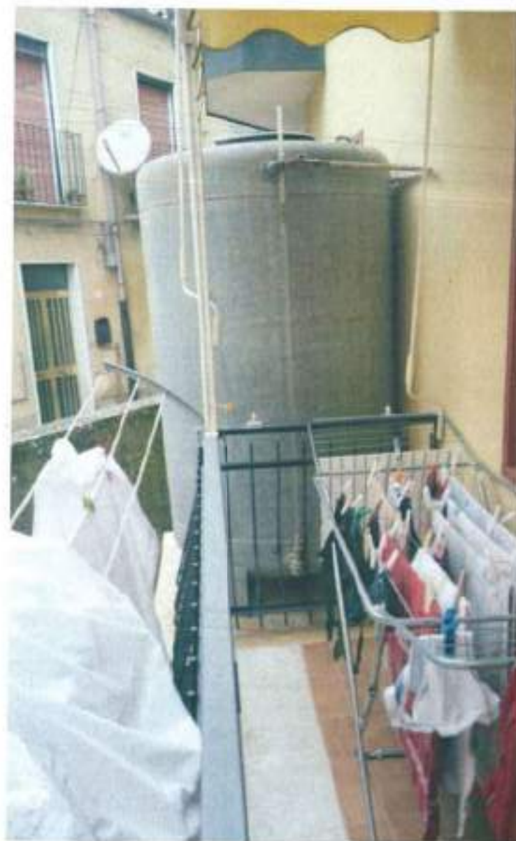
FOTO A20 ( Balcone 2 - vasca di riserva idrica )
