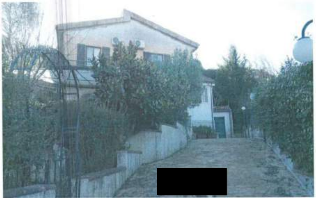
FOTO B7 (Rampa d'ingresso e vista principale Abitazione)
