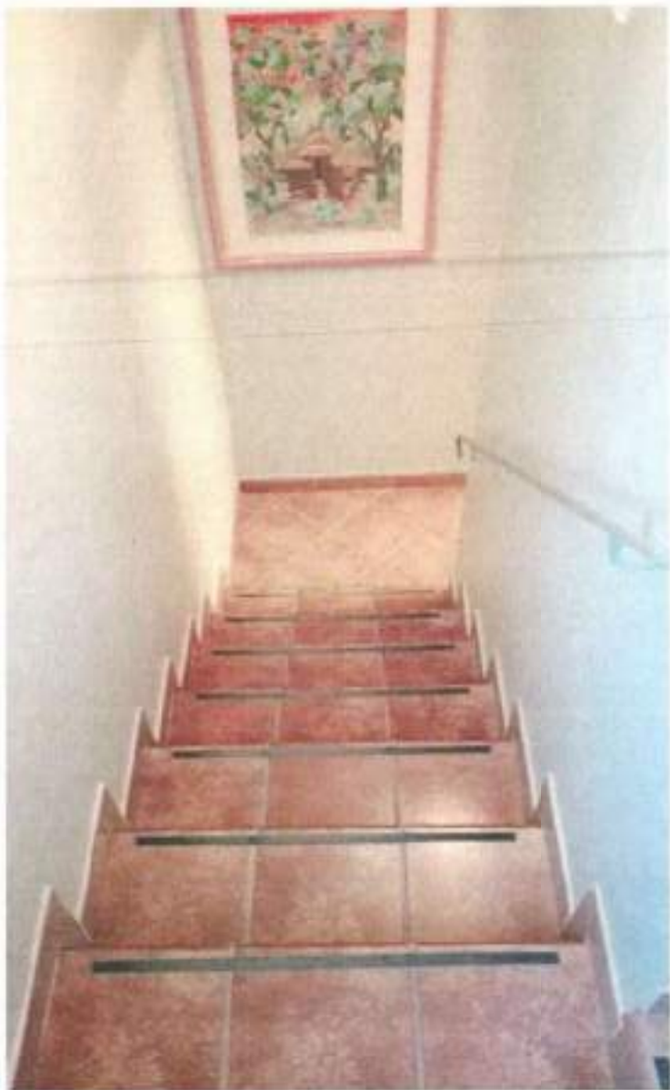
FOTO B29 (Vano scala - 1° rampa)
